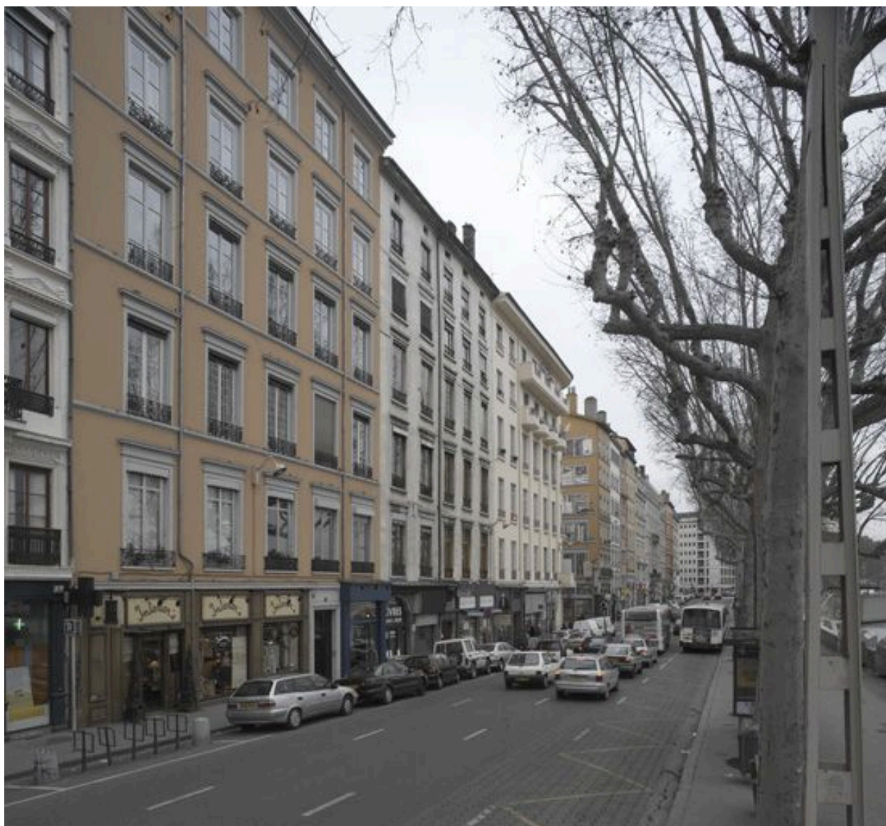
Vue générale dans l'ensemble des 3 immeubles
