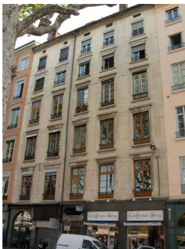
Façade sur rue, vue générale Phot. Phot. Inv. D. Chevallier IVR82_20046900588NUCA
