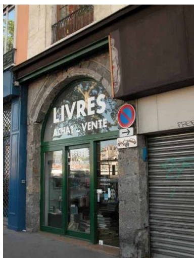
Façade sur rue, détail de la 1ère ouverture de boutique à gauche Phot. Phot. Inv. D. Chevallier IVR82_20046900590NUCA
