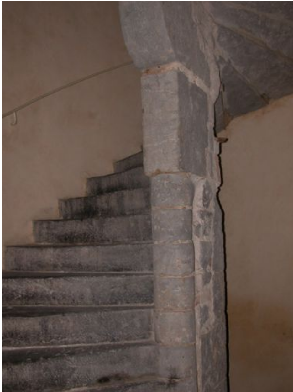
Corps longeant l'impasse, escalier vu depuis le palier du 1er étage
