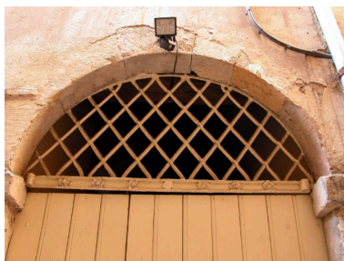
Corps longeant l'impasse, pavillon d'escalier, grille de tympan de la porte Phot. Bernard Ducouret IVR82_20046900604NUCA
