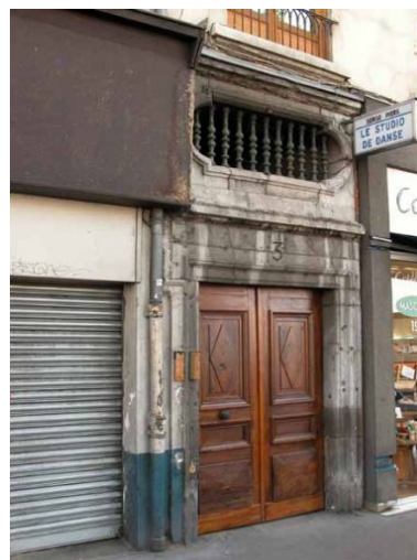
Façade sur rue, porte Phot. Phot. Inv. D. Chevallier IVR82_20046900589NUCA
