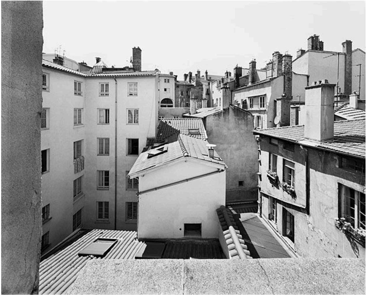
Vue générale depuis le toit du temple de la rue Lanterne : au centre (pignon le plus gris), corps longeant l'impasse ; au fond (ouverture en arc), pavillon d'escalier du bâtiment sur rue
