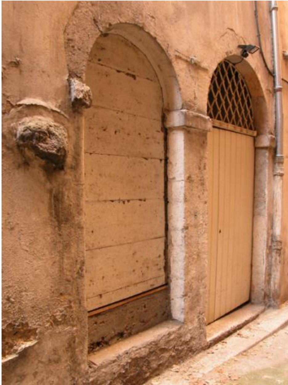
Corps longeant l'impasse, pavillon d'escalier, portes
