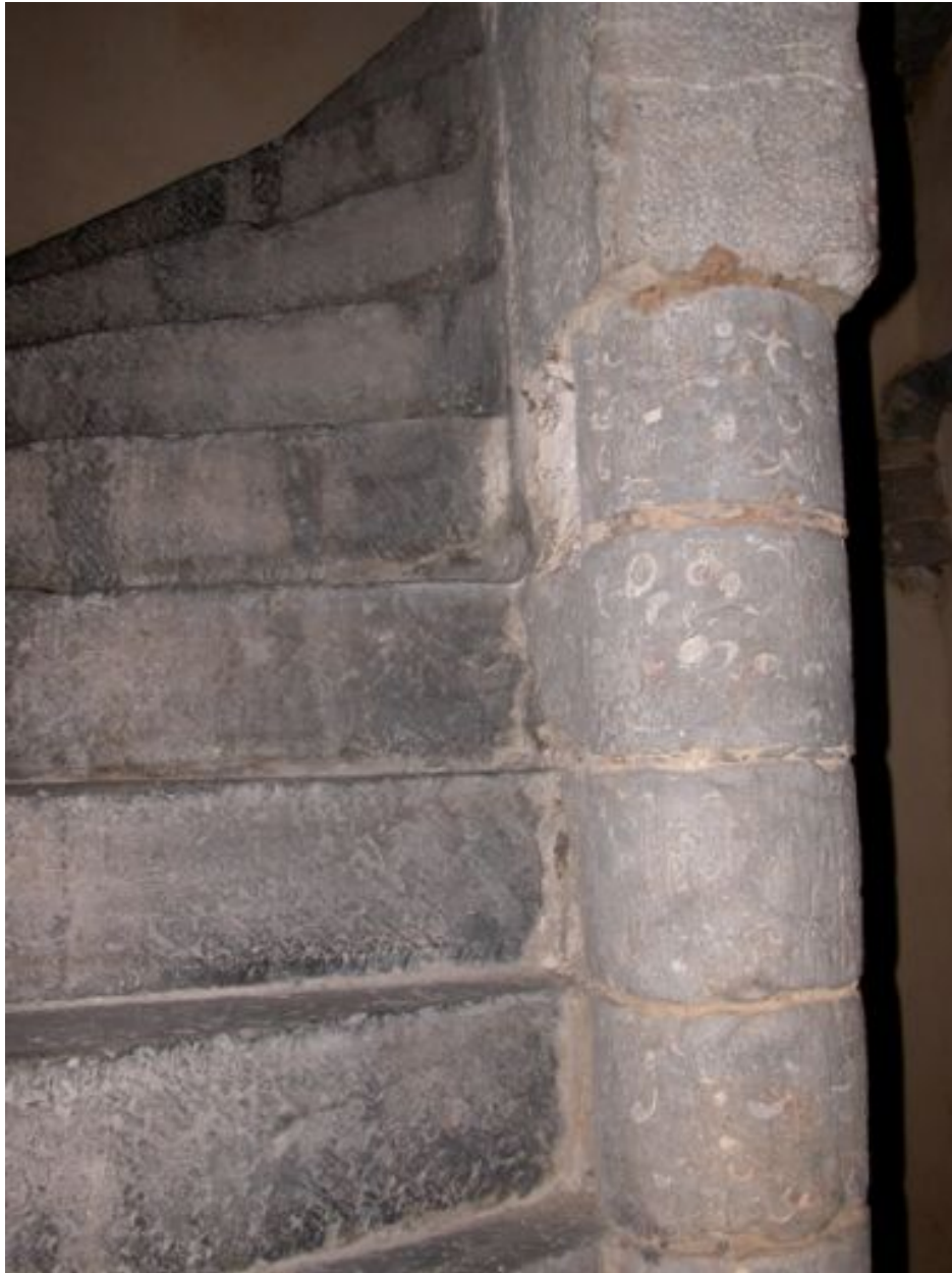
Corps longeant l'impasse, détail du noyau de l'escalier
