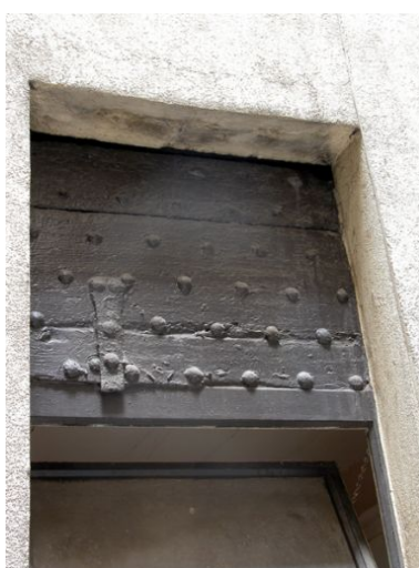
1ère cour, corps de liaison à droite, détail de la fermeture d'une fenêtre du 1er niveau
