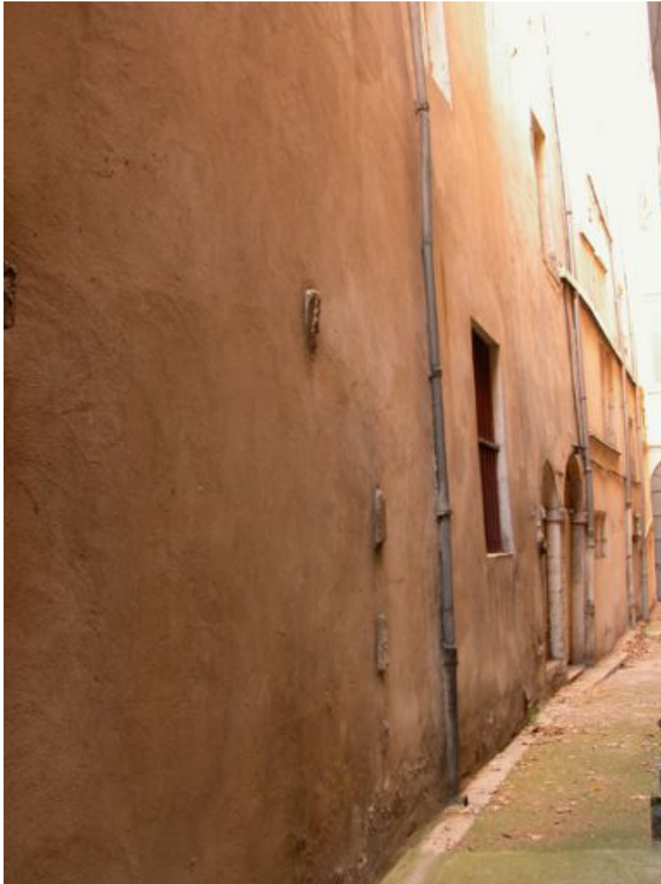
Corps longeant l'impasse, rez-de-chaussée
