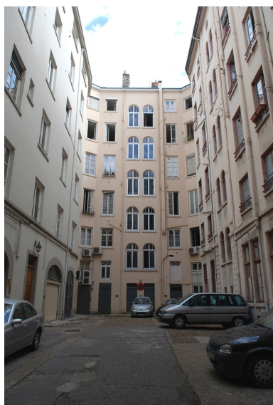
La cour Phot. Véronique Belle IVR82_20096904965NUCA
