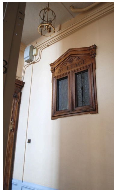
Palier du troisième étage : fenêtres de second jour Phot. Véronique Belle IVR82_20096904964NUCA
