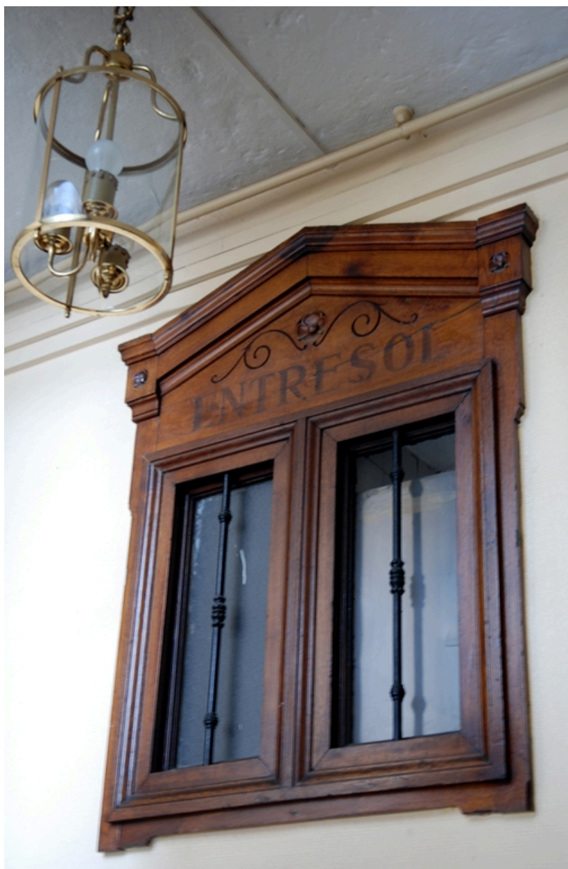
Palier de l'entresol : fenêtres de second jour
