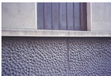
Vue sud détail façade Phot. Nadine Halitim-Dubois IVR82_20026904534ZE
