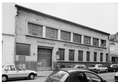
Vue générale façade nord avec enseigne moulée dans le béton Phot. Martial Couderette IVR82_20016903102P
