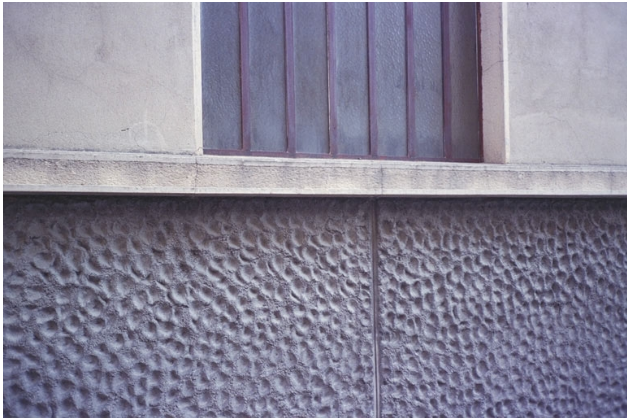
Vue sud détail façade
