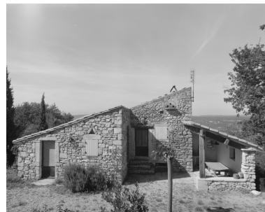
La Côte. Elévation principale de la ferme parc. D 193. Phot. Alain Franchella IVR82_19972600503X
