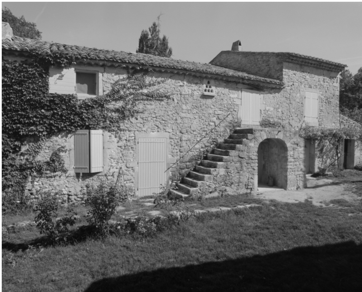
La Valadière. Vue de l'élévation principale de la ferme parc. B 193-194.
