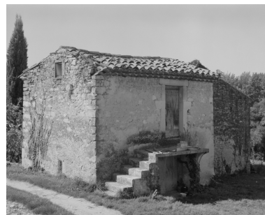
La Valadière. Une dépendance de la ferme parc. B 193-194. Phot. Alain Franchella IVR82_19972600474X
