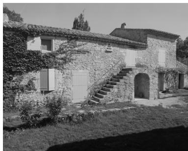
La Valadière. Vue de l'élévation principale de la ferme parc. B 193-194. Phot. Alain Franchella IVR82_19972600477X
