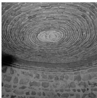
Vue de la coupole plate en brique de la glacière.
