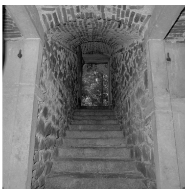
Vue de l'escalier descendant à la glacière, du sud. Phot. Eric Dessert IVR82_20014201664X
