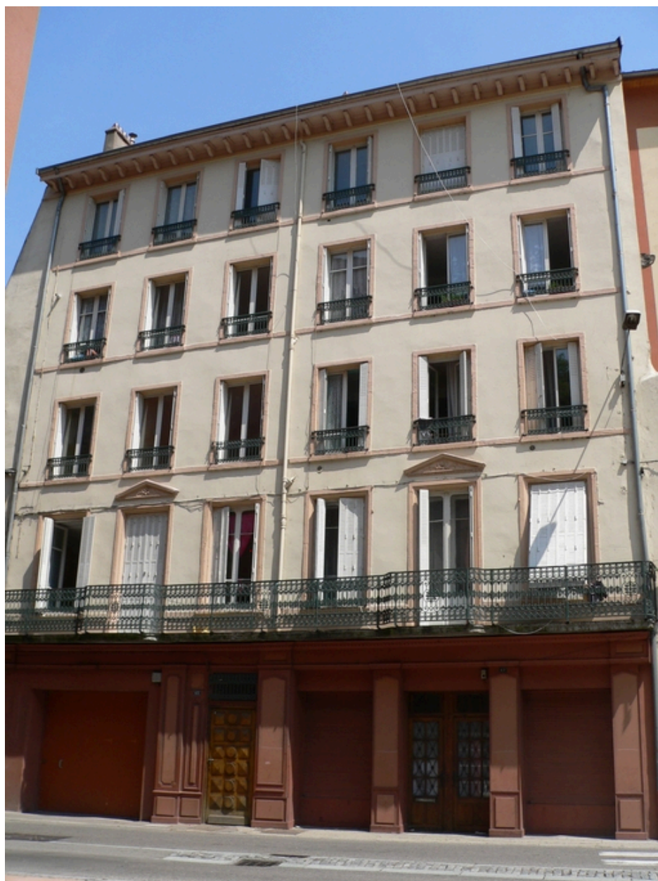
Façade principale sur rue
