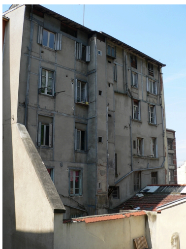
Façade arrière Phot. Isabelle Dupuis IVR82_20093800476NUCA
