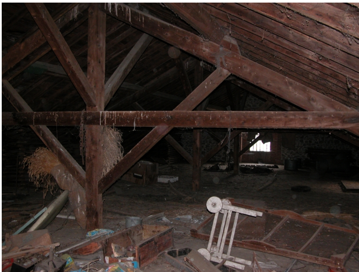
Vue intérieure du comble.
