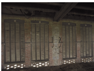
Détail des volets ajourés de la halle de séchage du 1er étage (fermés).
