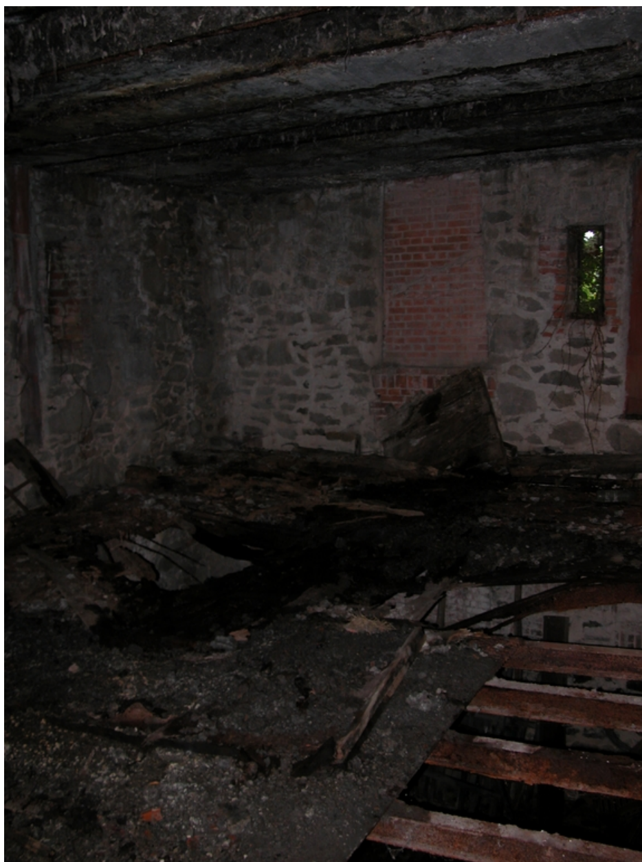
Vue intérieure du four, niveau haut.
