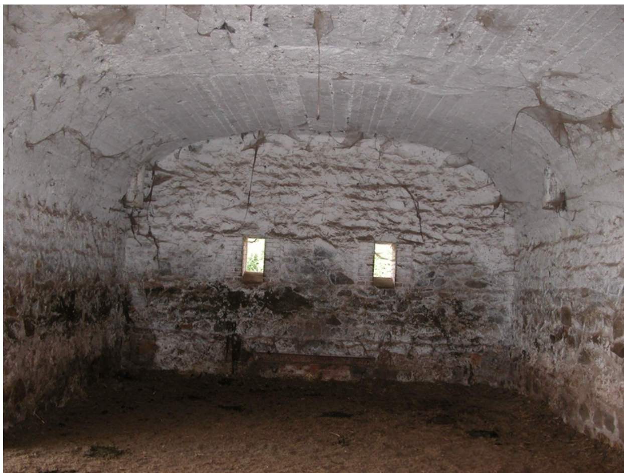
Vue intérieure : salle voûtée.
