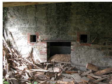
Vue de l'entrée du four. Phot. Thierry Monnet IVR82_20134204378NUCA
