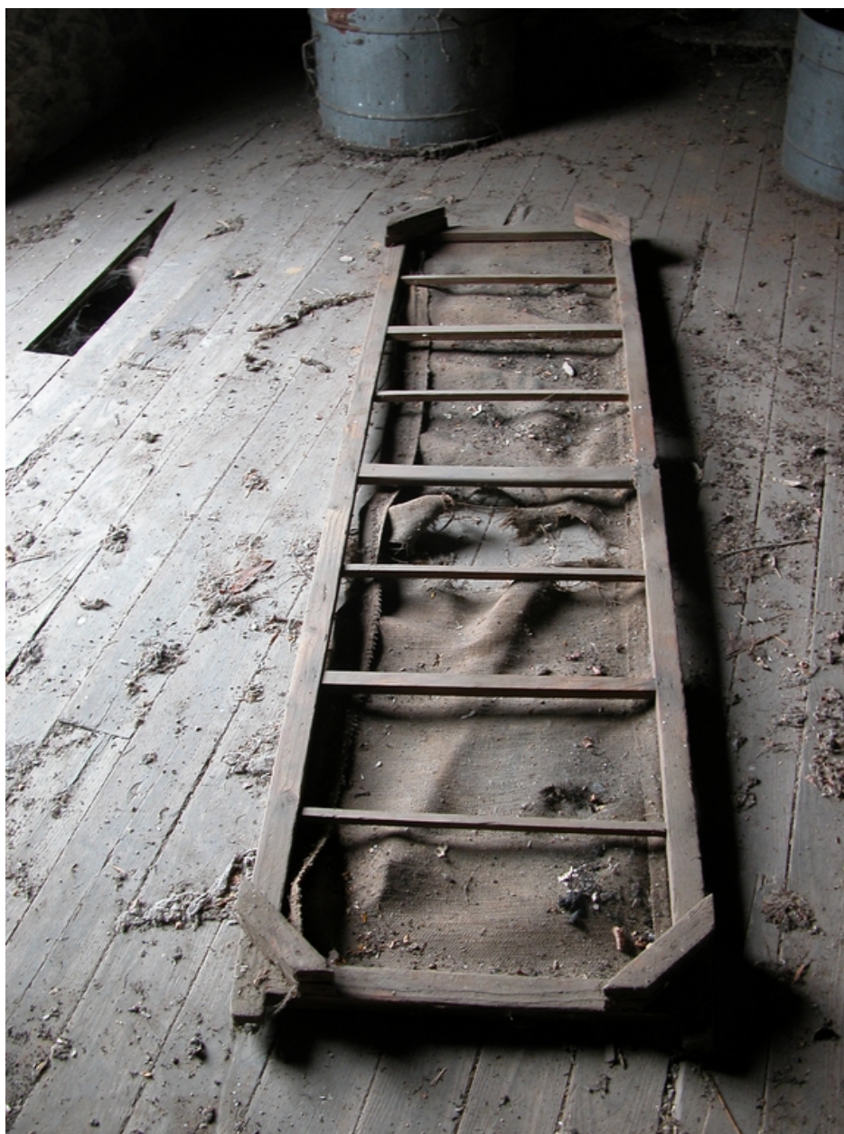
Détail d'une claie de séchage (face cadre).
