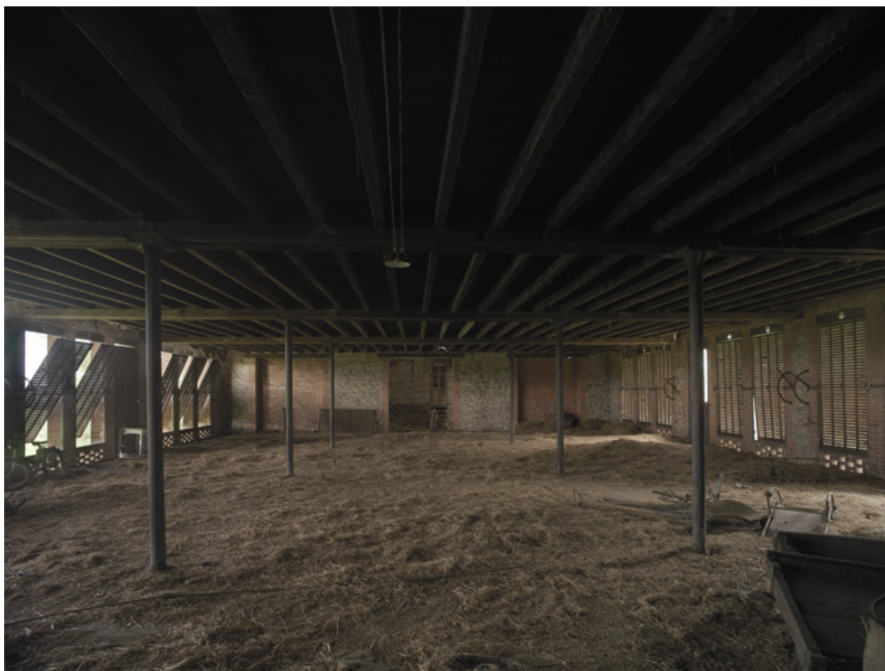
Vue intérieure de la halle de séchage du 1er étage.
