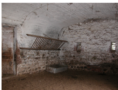
Vue intérieure : salle voûtée. Phot. Thierry Monnet IVR82_20134204380NUCA
