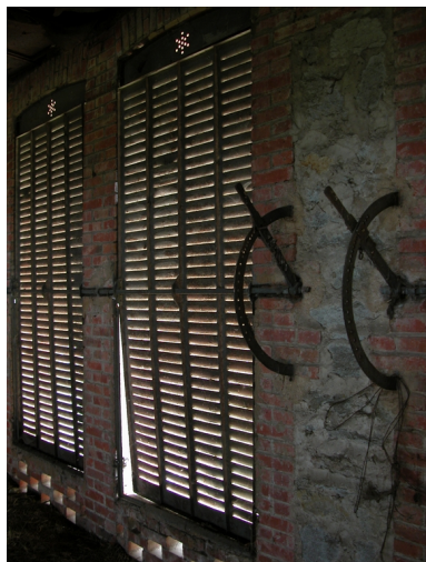
Détail des volets ajourés de la halle de séchage du 1er étage (fermés). Phot. Caroline Guibaud IVR82_20134204386NUCA
