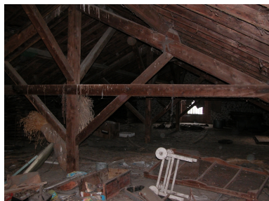
Vue intérieure du comble. Phot. Caroline Guibaud IVR82_20134204385NUCA
