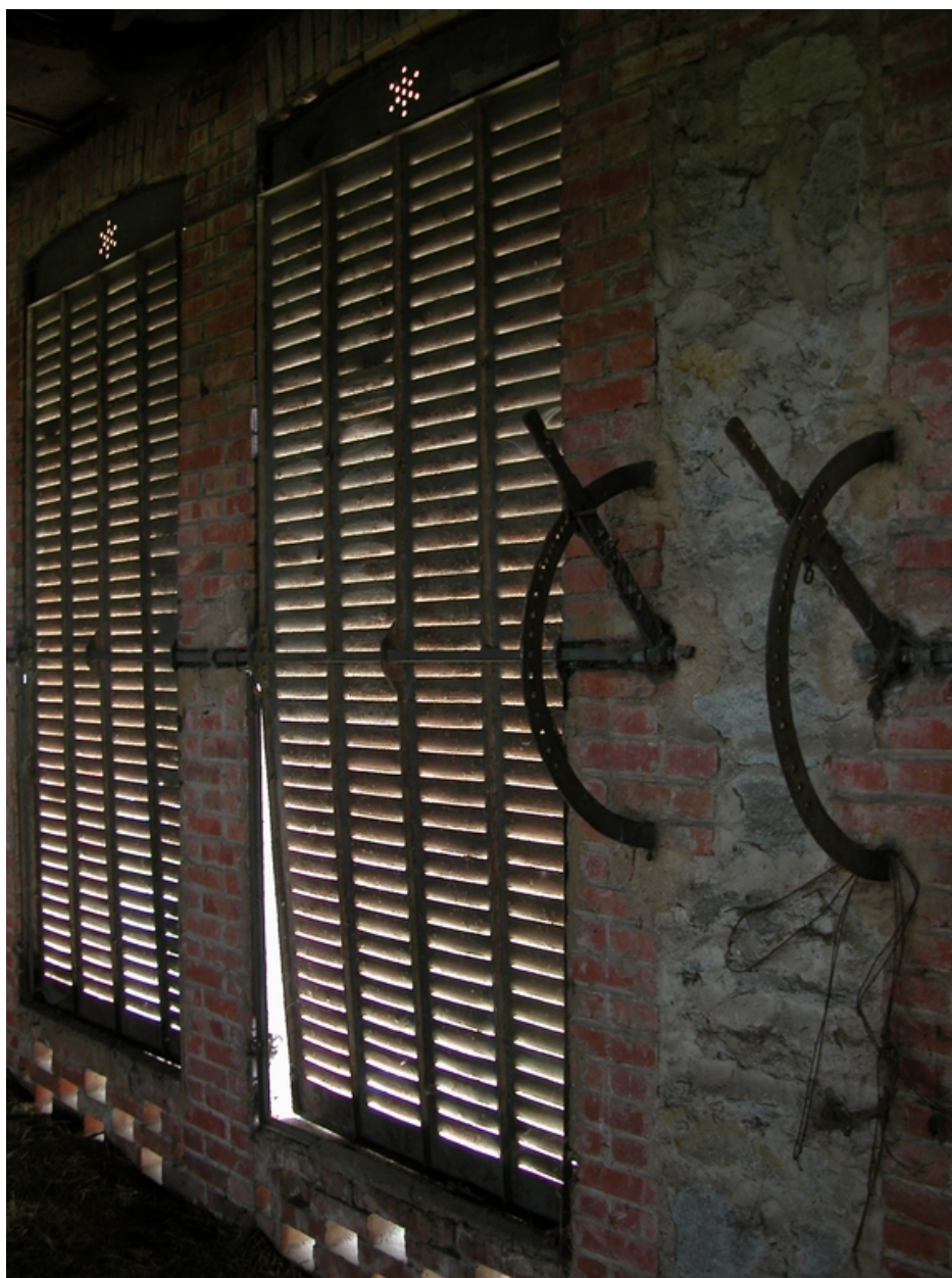
Détail des volets ajourés de la halle de séchage du 1er étage (fermés).
