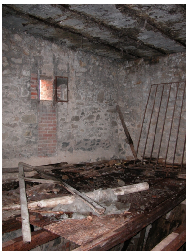
Vue intérieure du four, niveau haut. Phot. Caroline Guibaud IVR82_20134204390NUCA
