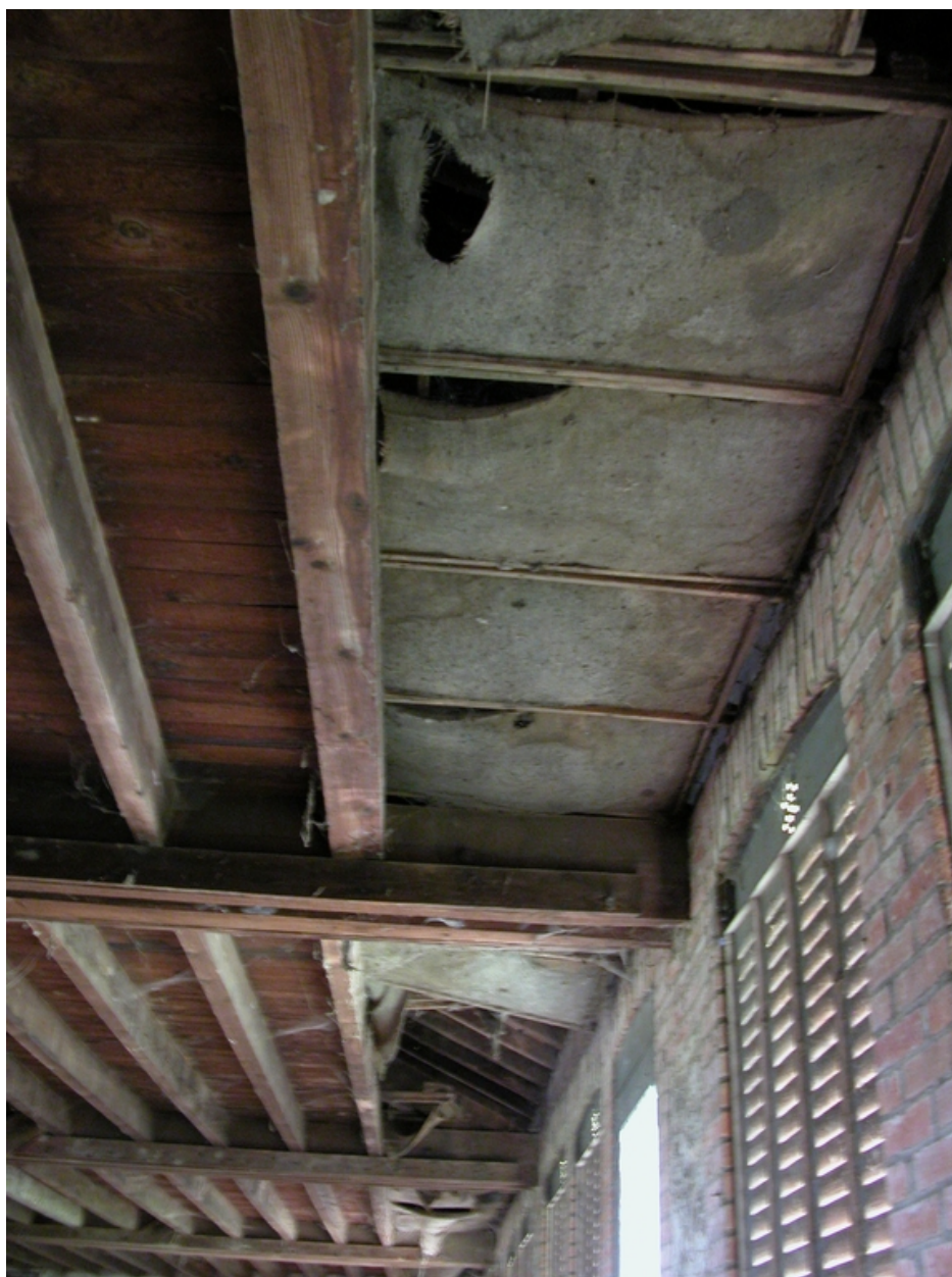
Détail du plafond de la halle de séchage du 1er étage.
