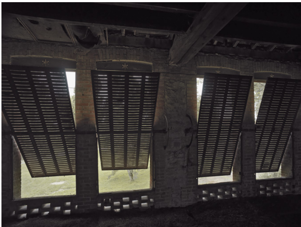
Détail des volets ajourés de la halle de séchage du 1er étage (ouverts).
