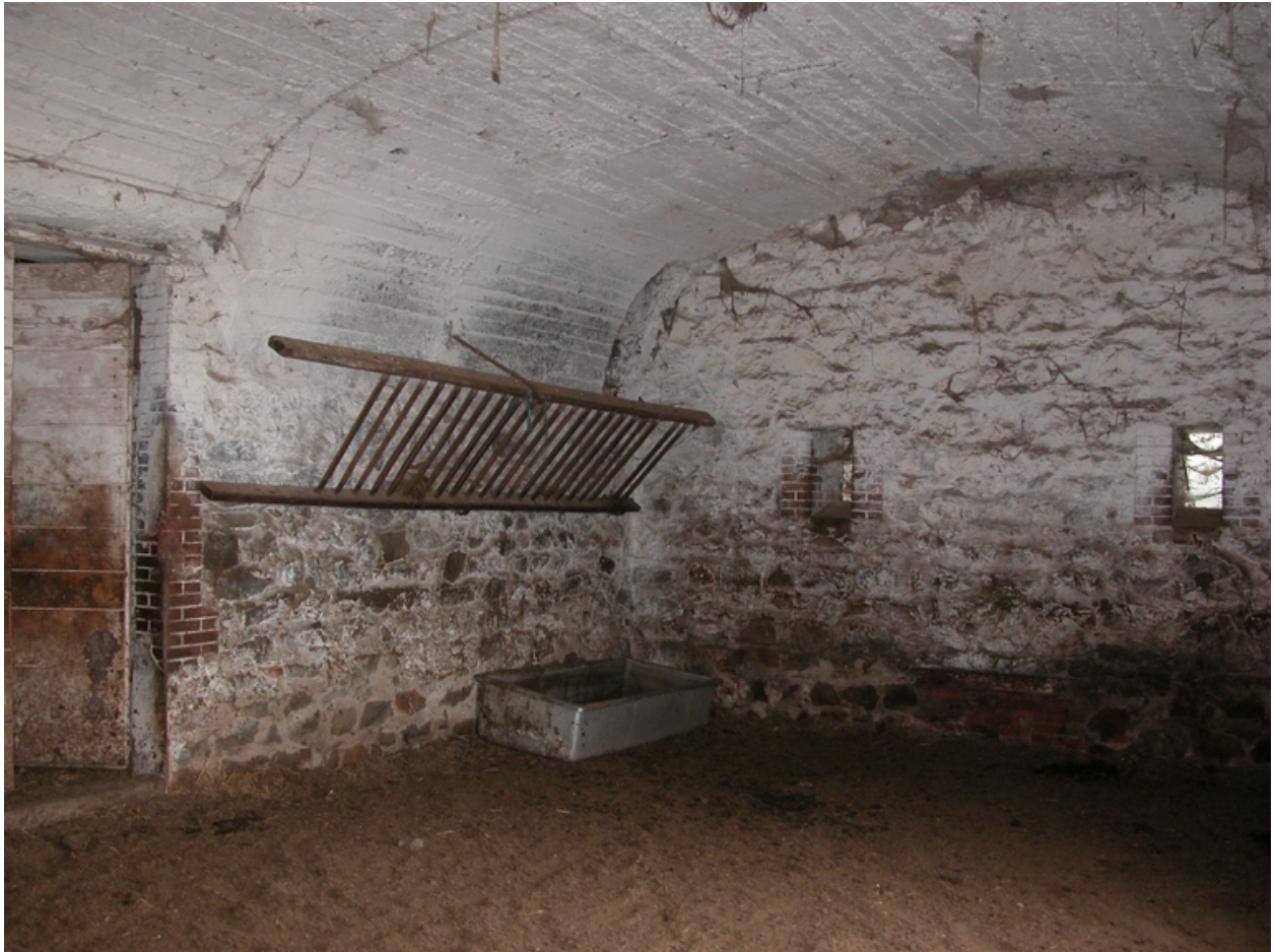
Vue intérieure : salle voûtée.
