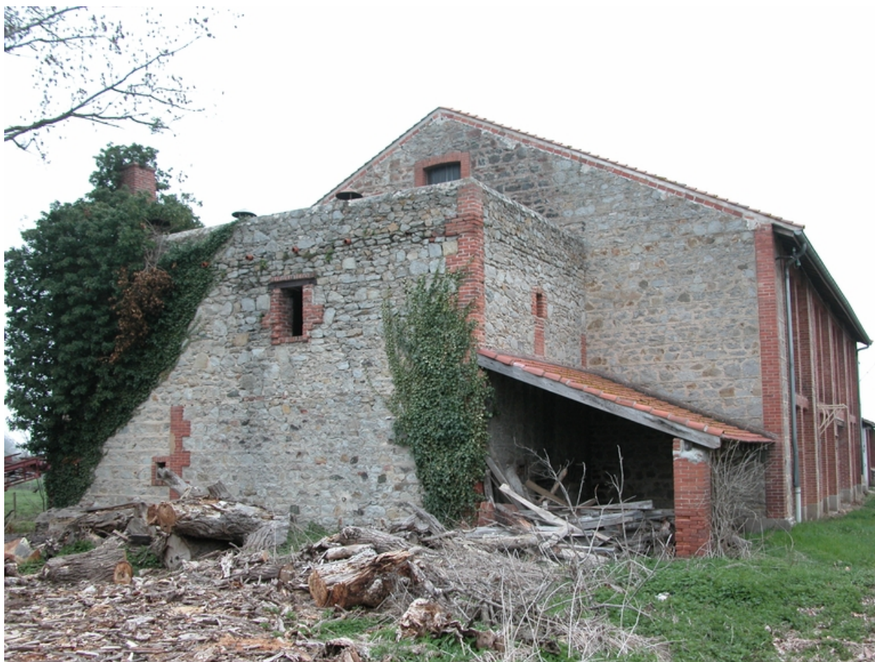
Vue d'ensemble de l'élévation ouest : vestige du four.
