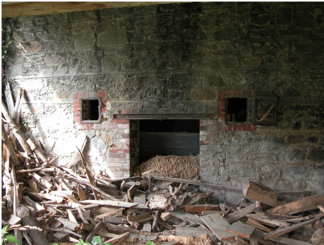
Vue de l'entrée du four.
