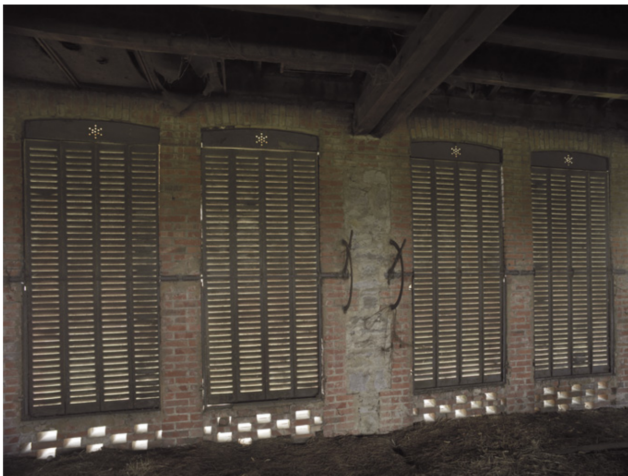
Détail des volets ajourés de la halle de séchage du 1er étage (fermés).
