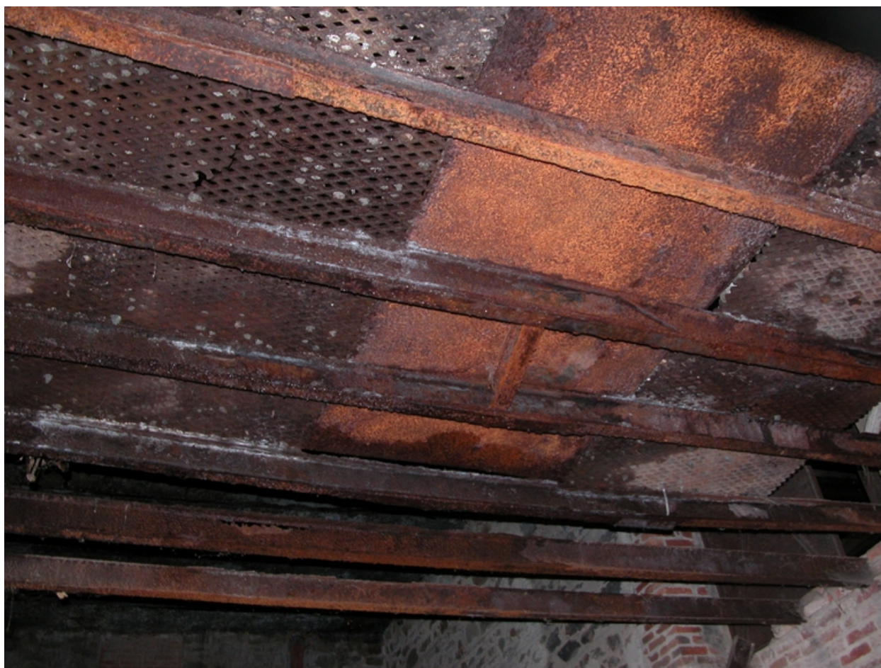
Vue intérieure du four, plafond ajouré du niveau bas.
