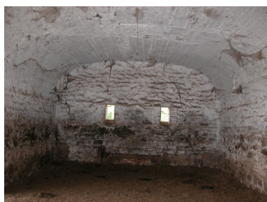
Vue intérieure : salle voûtée. Phot. Thierry Monnet IVR82_20134204379NUCA
