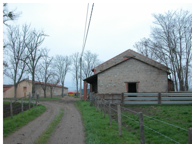
Vue générale depuis le sud. Phot. Caroline Guibaud IVR82_20134204371NUCA
