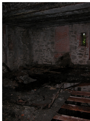
Vue intérieure du four, niveau haut. Phot. Caroline Guibaud IVR82_20134204389NUCA
