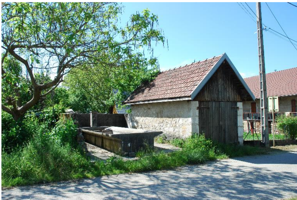
Vue d'ensemble du four à pain avec un bassin - lavoire - fontaine sur le côté.
