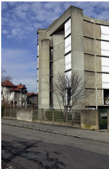
Détail de la cage d'escalier extérieure Phot. Bernard Ducouret IVR82_20016900906NUCA
