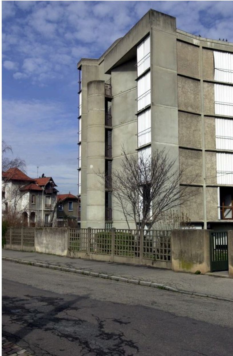
Détail de la cage d'escalier extérieure
