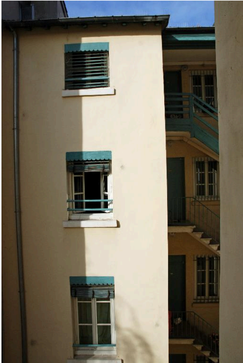
Immeuble sud, vue des coursières en façade postérieure
