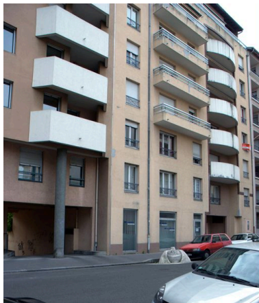
Vue générale depuis le nord Phot. Maryannick Chalabi IVR82_20106905087NUCA
