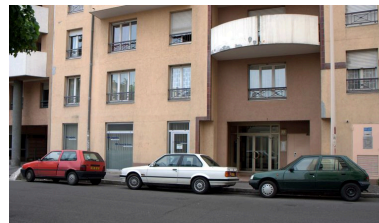
Elévation antérieure, détail du rez-de-chaussée Phot. Maryannick Chalabi IVR82_20106905088NUCA
