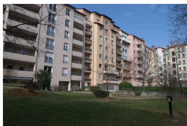
Elévations postérieures des immeubles 5, 7 et 9 rue Nicolai Phot. Maryannick Chalabi IVR82_20126902449NUCA
