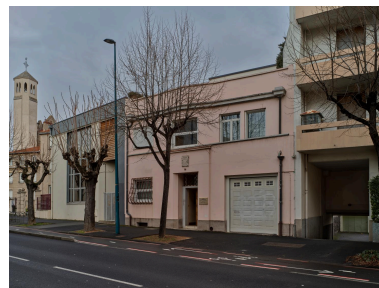
En vis-à-vis sur le boulevard Jean-Jaurès, le domicile et cabinet de l'architecte Albéric Aubert Phot. Christian Parisey IVR84_20256300402NUCA
