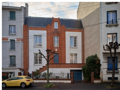
Façade sur le boulevard Jean-Jaurès Phot. Christian Parisey IVR84_20256300305NUCA
