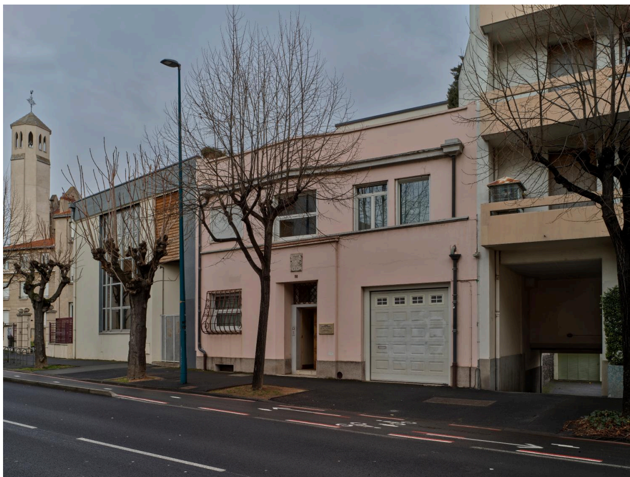
En vis-à-vis sur le boulevard Jean-Jaurès, le domicile et cabinet de l'architecte Albéric Aubert
