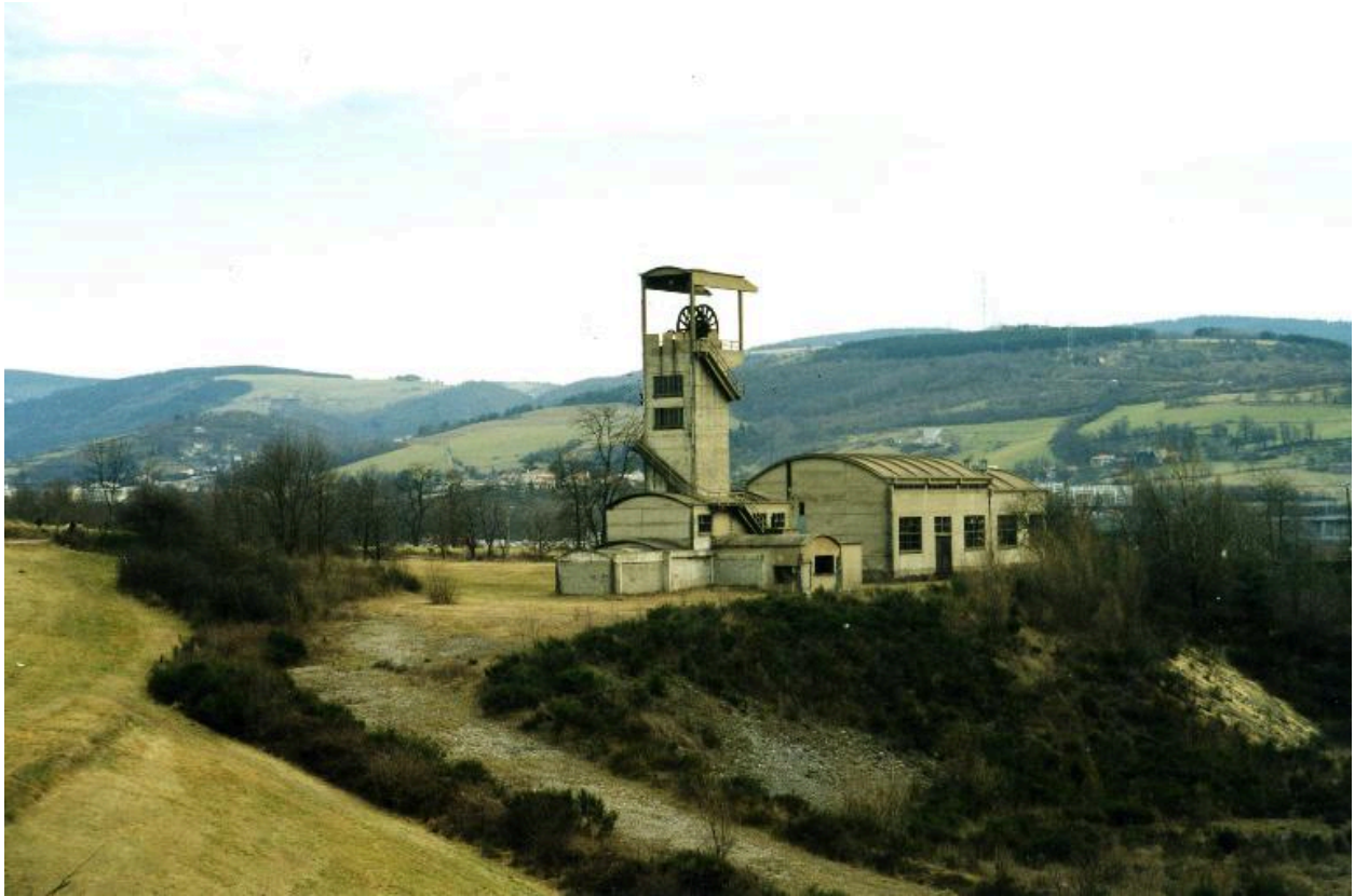
Vue générale, vue sud
