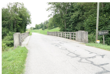
Pont Borian, vue sur la chaussée et les gardes-corps Phot. Pascale Renard IVR84_20207403132NUCA
