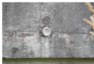
Pont Borian, détail de la borne géodésique Phot. Pascale Renard IVR84_20207403130NUCA
