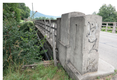
Pont Borian, vue de la face amont Phot. Pascale Renard IVR84_20207403128NUCA
