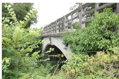
Pont Borian, vue de la face aval Phot. Pascale Renard IVR84_20207403127NUCA
