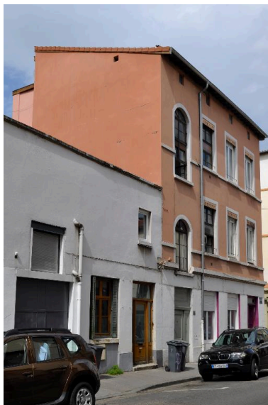
Elévation sur la rue Reinach, vue du mur pignon et de la toiture à un pan Phot. Magali Delavenne IVR84_20176901039NUCA
