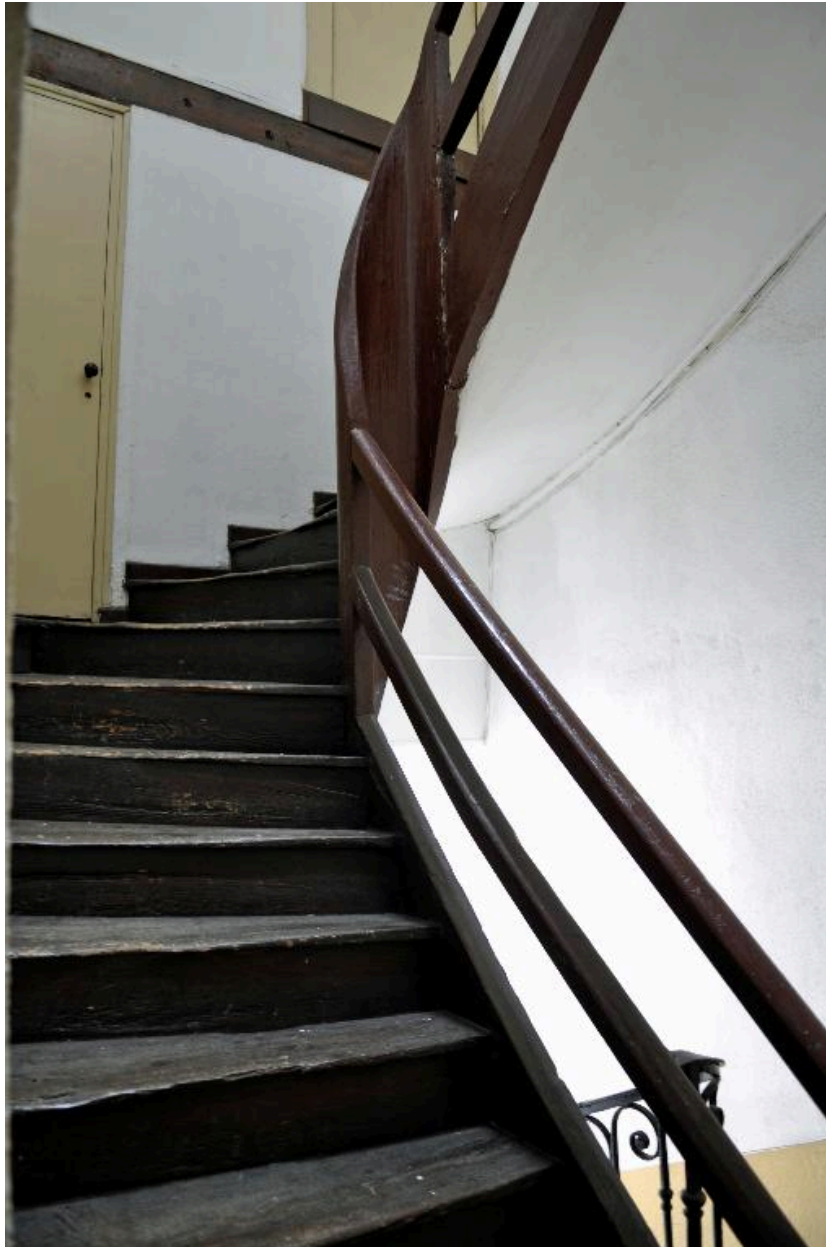
Vue intérieure, dernière volée de l'escalier en bois
