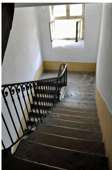
Vue intérieure, l'escalier Phot. Magali Delavenne IVR84_20176901042NUCA
