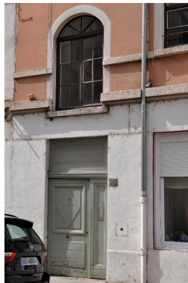
Elévation sur la rue Reinach, vue de la porte et baie cintrée éclairant l'escalier Phot. Magali Delavenne IVR84_20176901040NUCA
