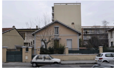
Façade antérieure Phot. Julien Defillon IVR82_20106900866NUCA
