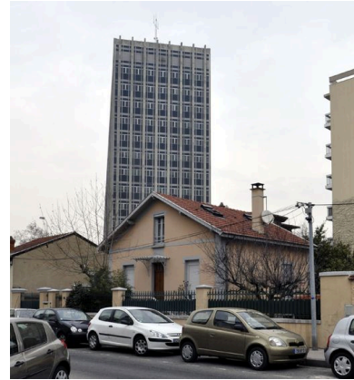
Façade antérieure et façade latérale Phot. Julien Defillon IVR82_20106900869NUCA
