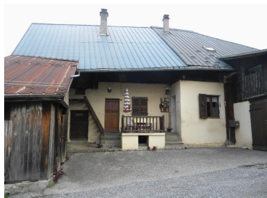
Vue de la façade principale. Phot. Jérôme Daviet IVR82_20157401663NUCA
