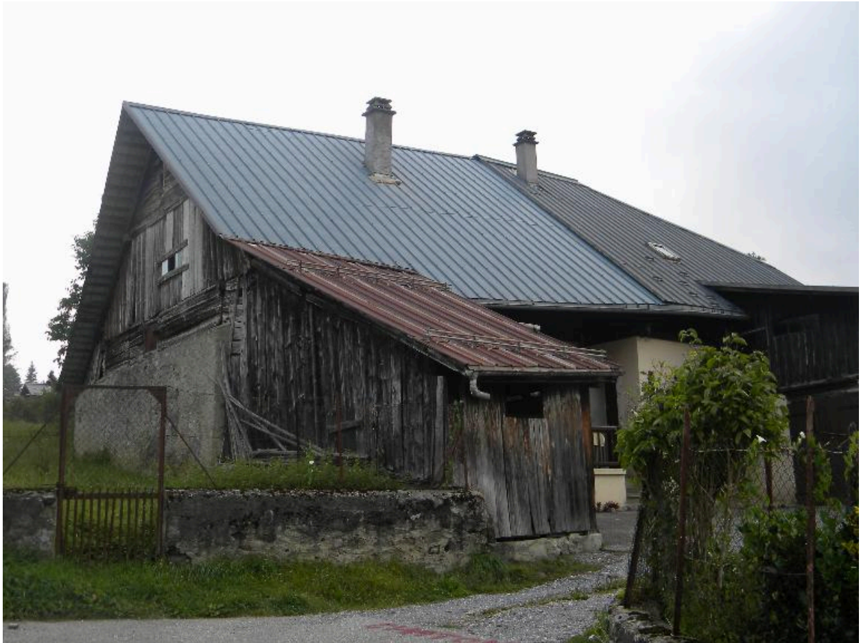
Vue de trois-quarts sud-ouest
