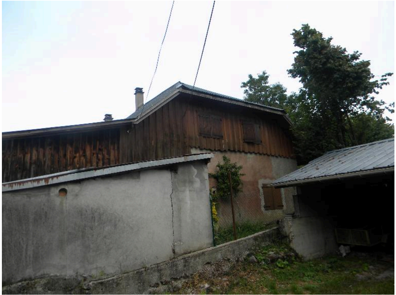
Vue du pignon est.
