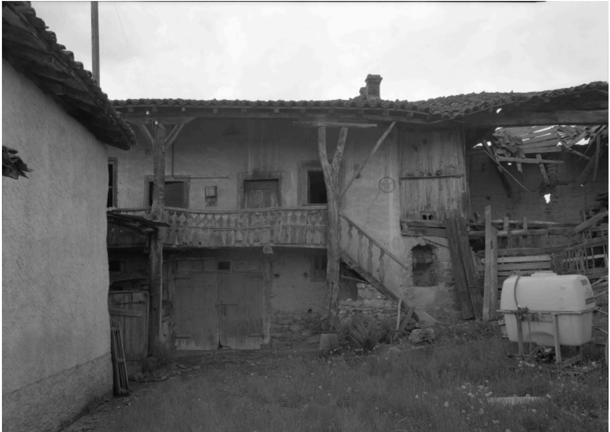
Vue d'ensemble du logis ancien de face.
