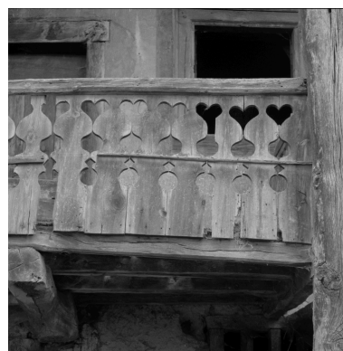
Logis ancien, vue de détail de la galerie en bois découpé Phot. Jean-Marie Refflé IVR82_20024201012X
