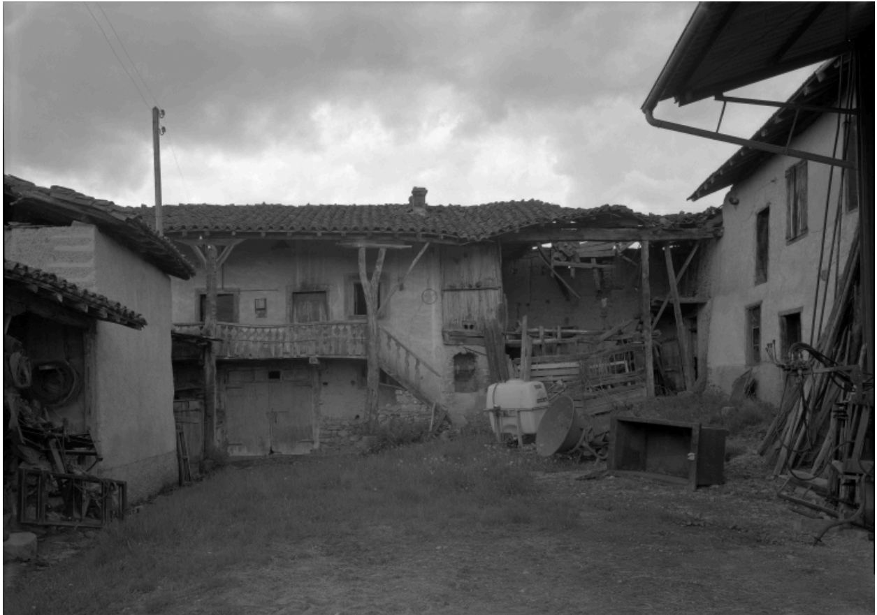
Vue d'ensemble du logis ancien de face.
