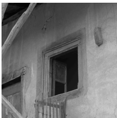
Logis ancien, vue d'ensemble de la baie à encadrement mouluré de la cuisine du premier étage. Phot. Jean-Marie Refflé IVR82_20024201008X
