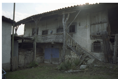
Vue d'ensemble du logis ancien. Phot. Thierry Monnet IVR82_20054200116ZE
