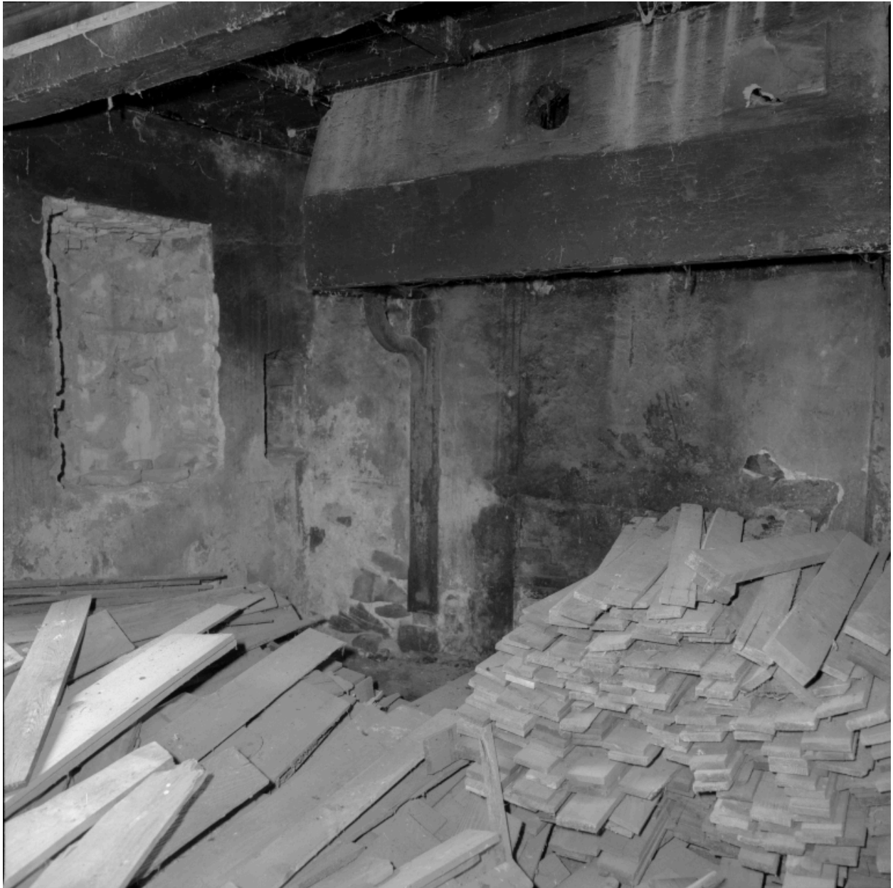
Second logis, cuisine, détail de la cheminée.
