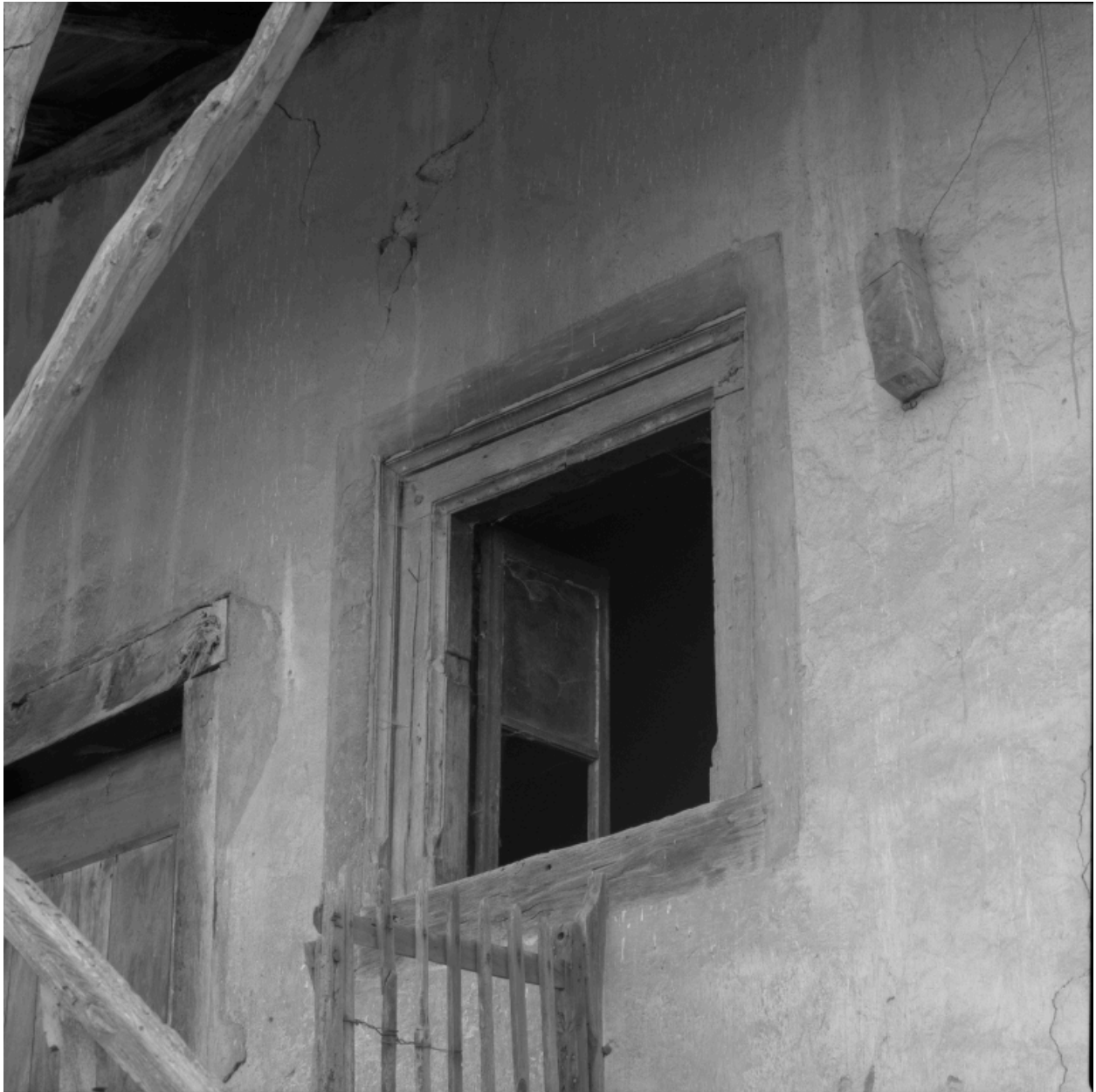
Logis ancien, vue d'ensemble de la baie à encadrement mouluré de la cuisine du premier étage.
