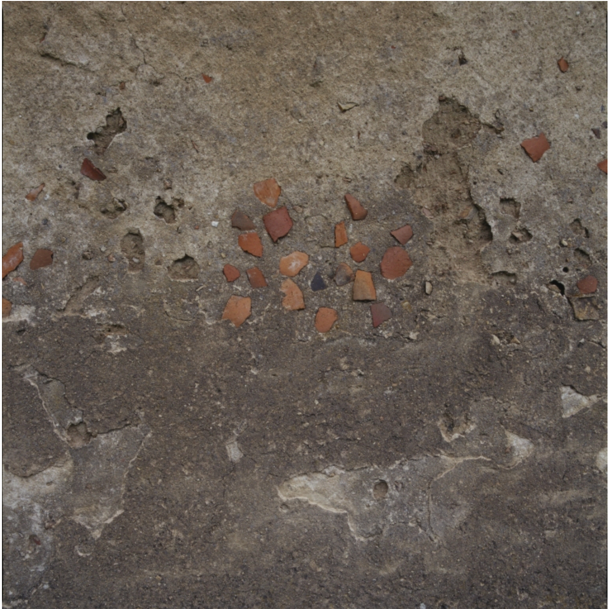
Elévations arrières de la ferme, détail de l'enduit.
