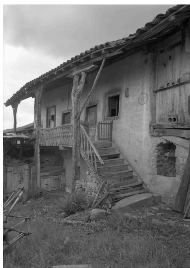
Vue d'ensemble du logis ancien de côté. Phot. Jean-Marie Refflé IVR82_20024201007P
