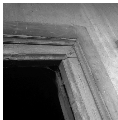
Logis ancien, vue de détail de la baie à encadrement mouluré de la cuisine du premier étage. Phot. Jean-Marie Refflé IVR82_20024201009X
