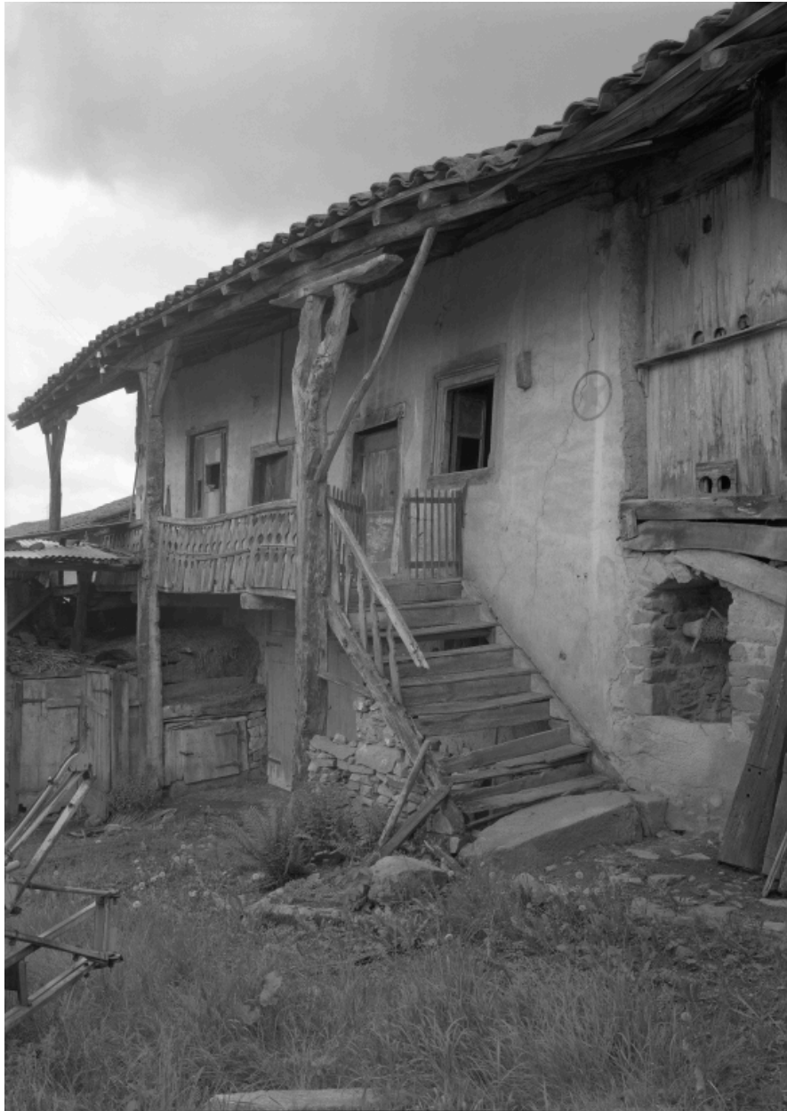
Vue d'ensemble du logis ancien de côté.
