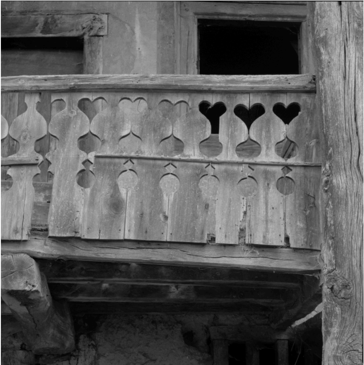
Logis ancien, vue de détail de la galerie en bois découpé
