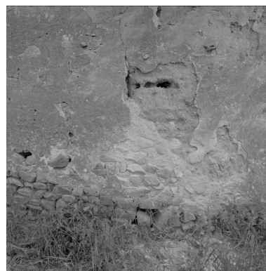
Elévations arrières de la ferme, détail de l'enduit. Phot. Jean-Marie Refflé IVR82_20024201018X
