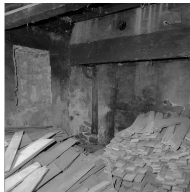
Second logis, cuisine, détail de la cheminée. Phot. Eric Dessert IVR82_20024201022X
