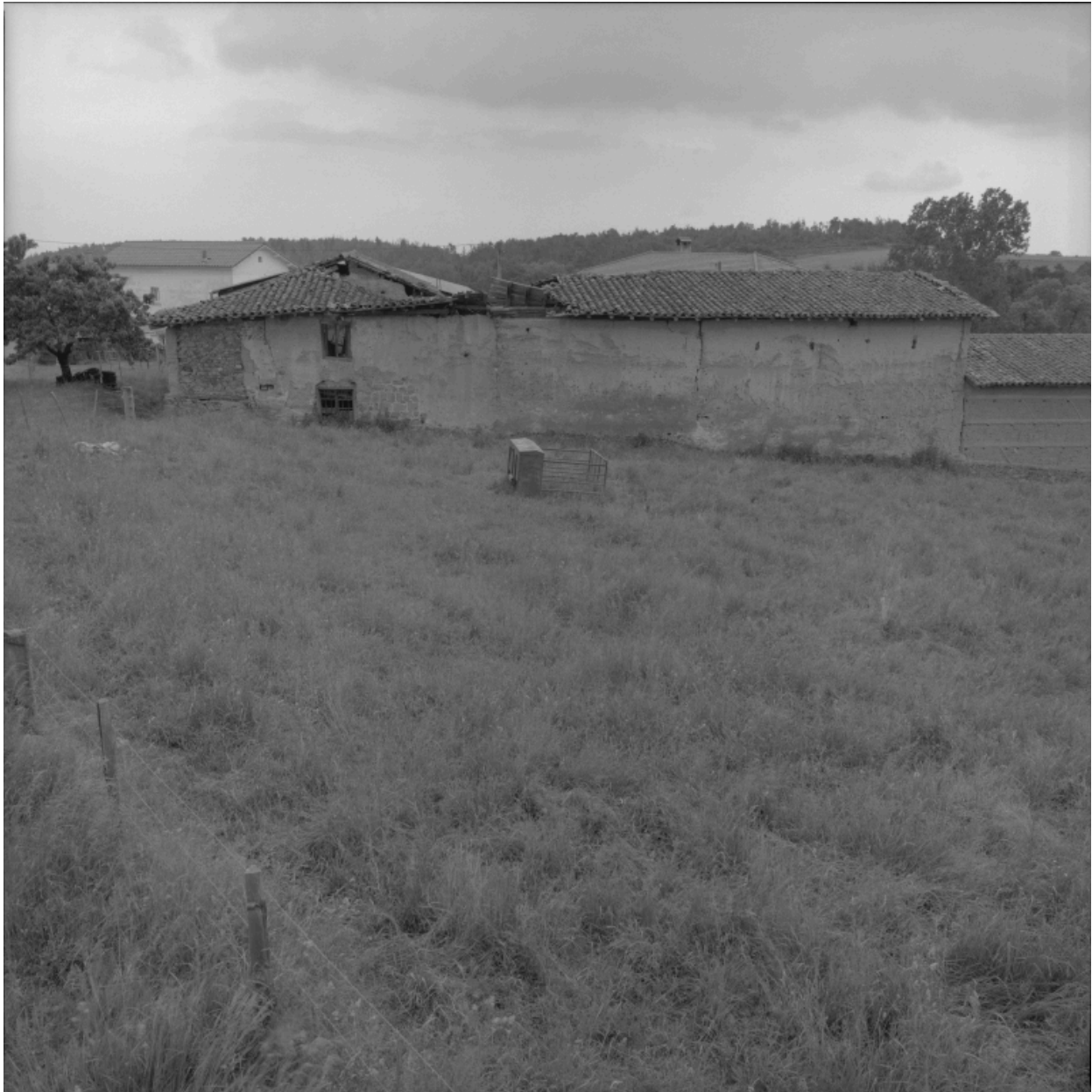
Elévations arrières de la ferme.
