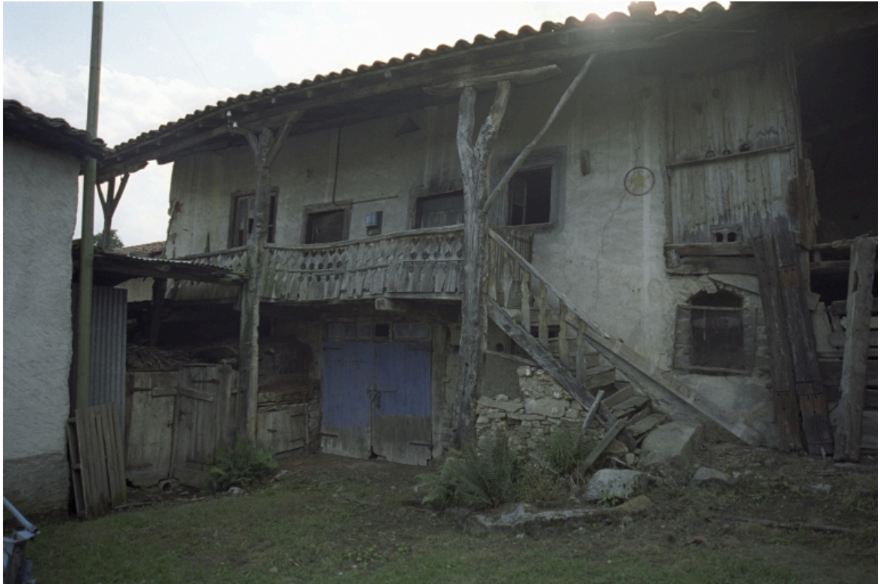
Vue d'ensemble du logis ancien.
