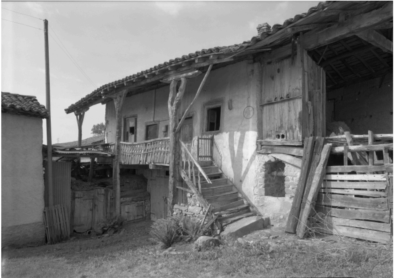
Vue d'ensemble du logis ancien de trois quarts.
