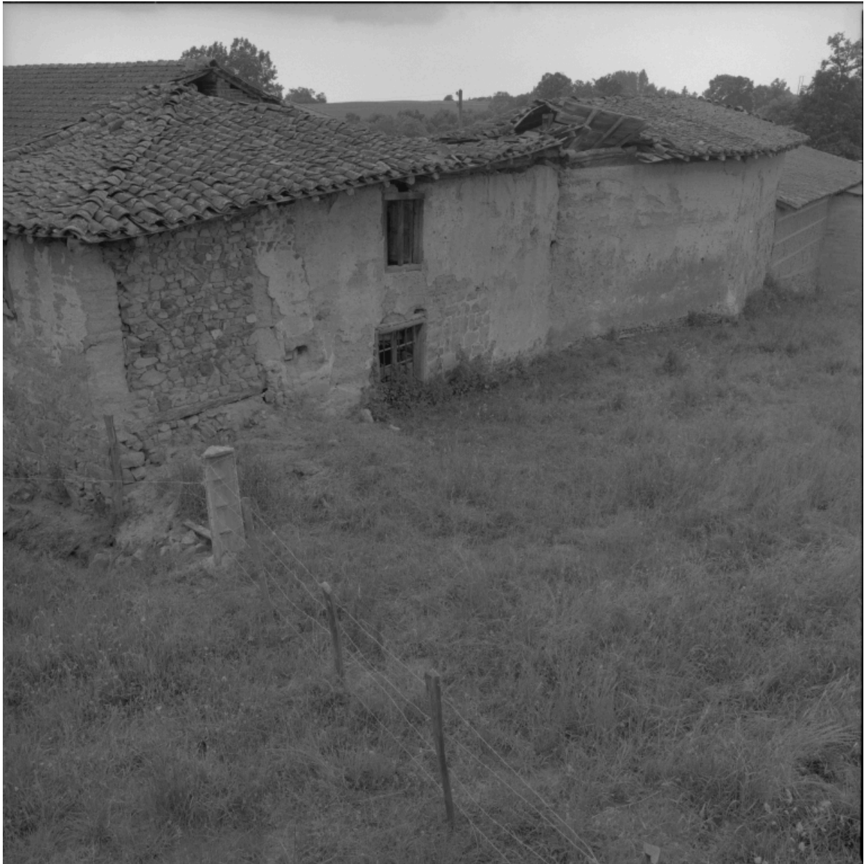
Elévations arrières de la ferme.
