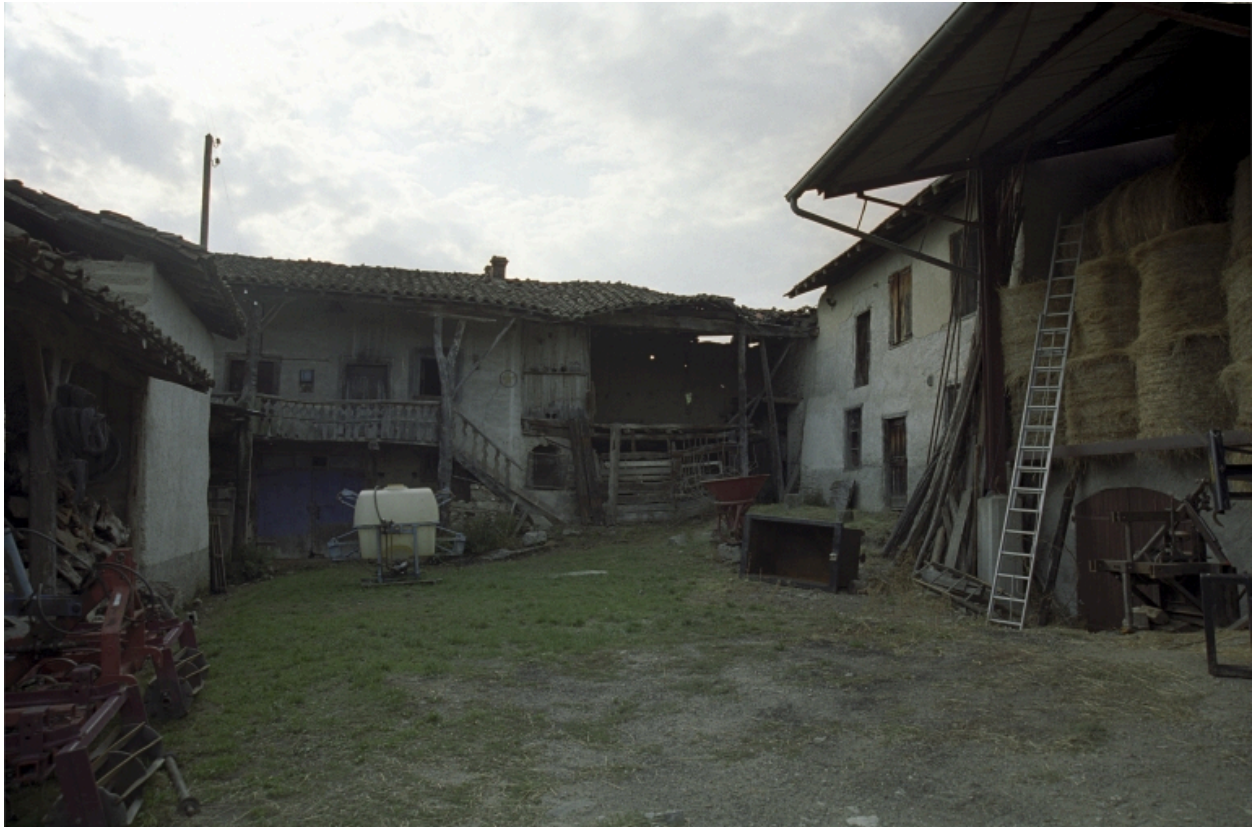
Vue d'ensemble de la ferme avec ses deux logis successifs.
