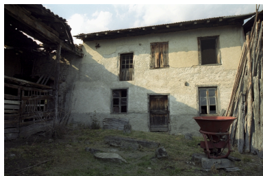
Vue d'ensemble du second logis. Phot. Thierry Monnet IVR82_20054200119ZE
