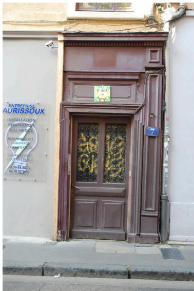
Vue de la porte d'entrée Phot. Nadine Halitim-Dubois IVR82_20146900070NUCA
