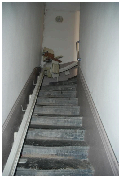
Vue de la première volée de l'escalier Phot. Nadine Halitim-Dubois IVR82_20146900082NUCA
