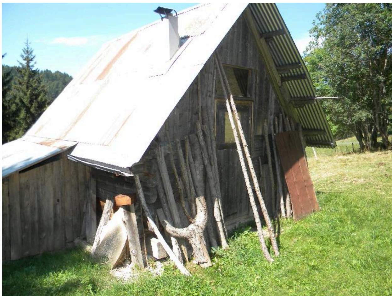
Vue de la façade arrière.
