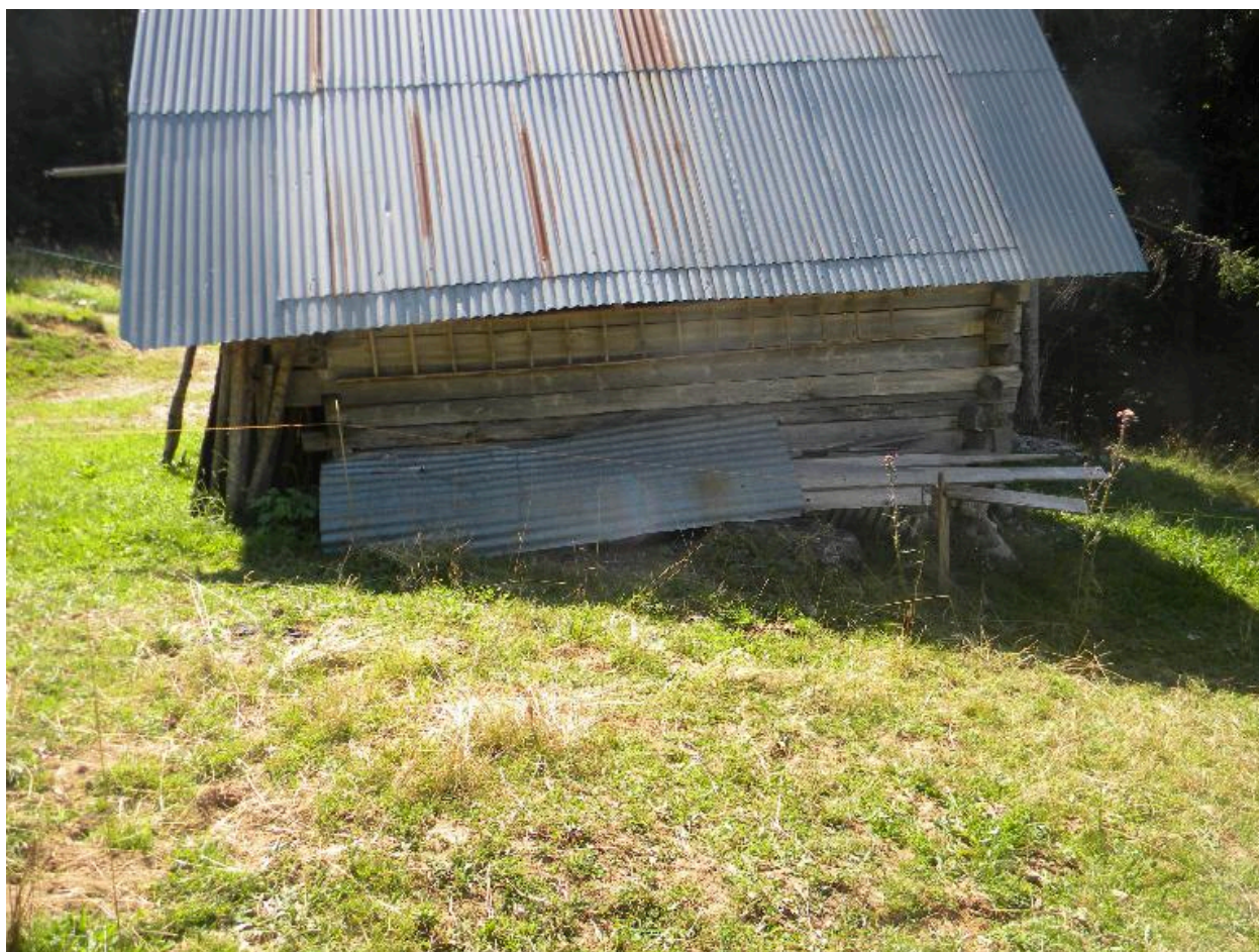
Vue de la façade ouest.
