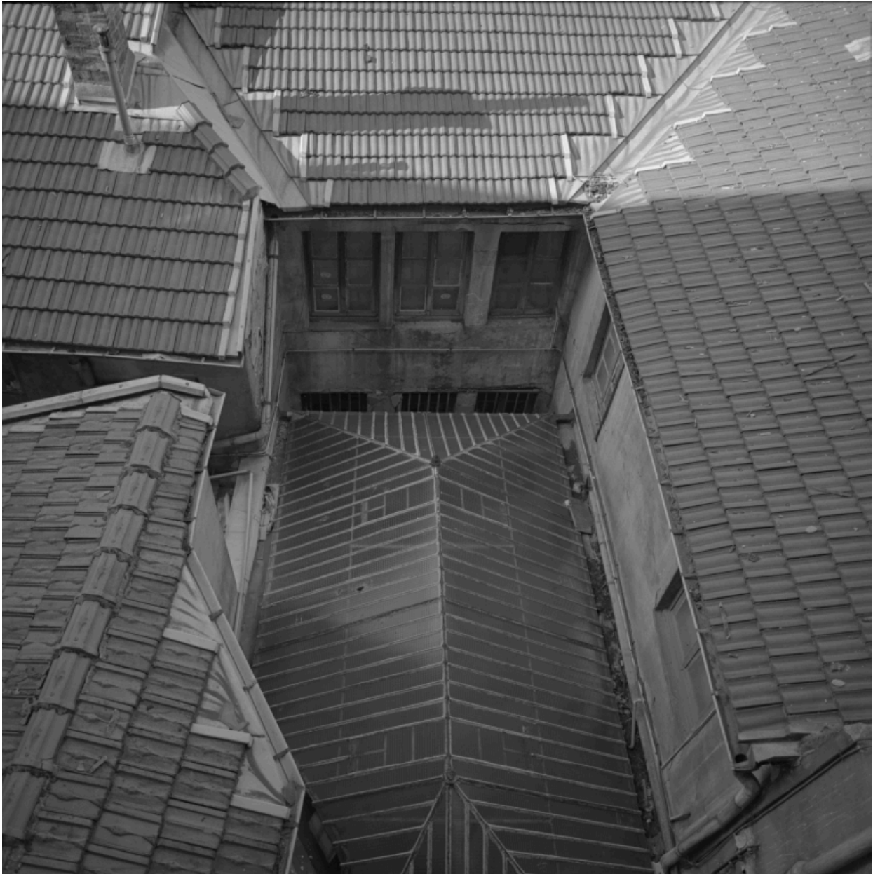
Détail de la verrière construite dans une des cours
