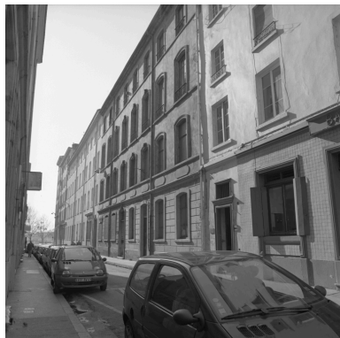
Vue générale depuis le nord-ouest Phot. Eric Dessert IVR82_20006900074X
