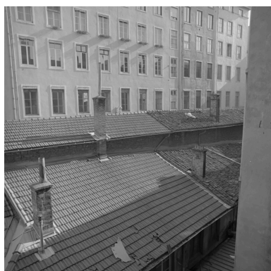
Détail des toits de l'atelier construit dans la cour Phot. Eric Dessert IVR82_20006900083X
