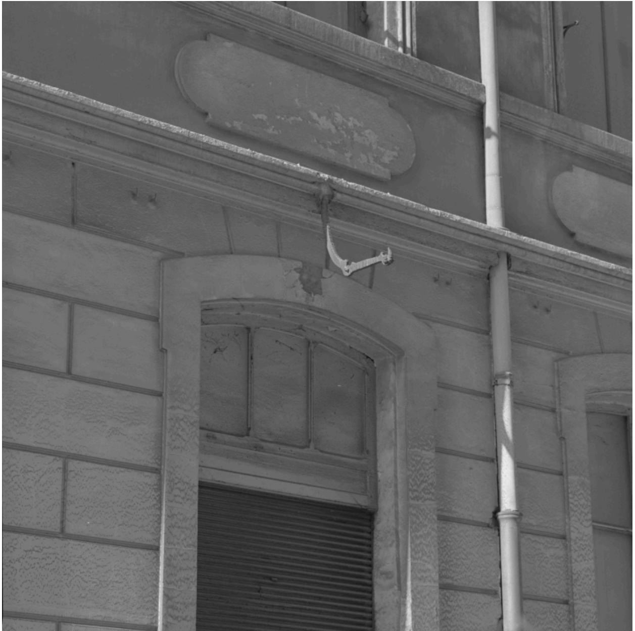
Détail d'accroche au-dessus d'une fenêtre
