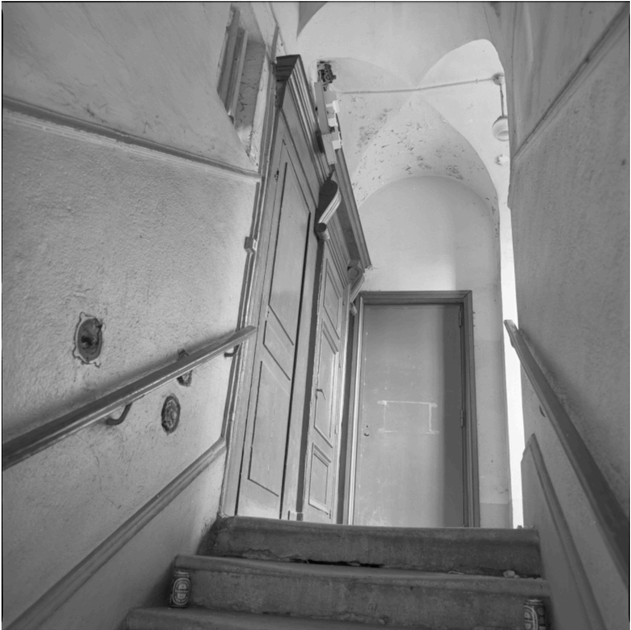
Vue des portes palières du 1er étage
