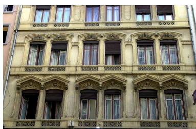
Façade principale, ensemble de fenêtres Phot. Lore Derail IVR82_20036901442NUCA
