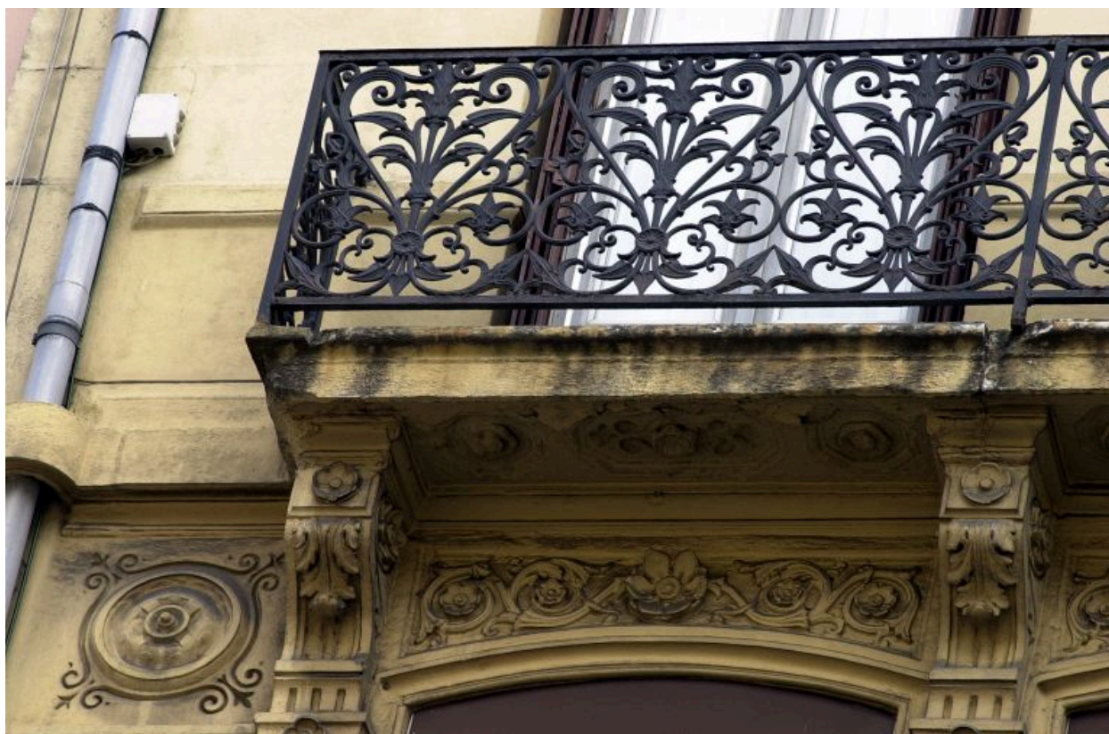
Façade principale, balcon du quatrième étage, sculptures et ferronnerie
