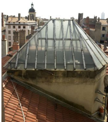
Couronnement de l'escalier Phot. Lore Derail IVR82_20036901391NUCA
