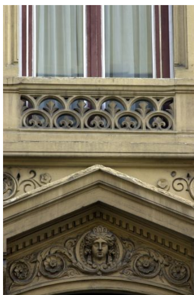
Façade principale, garde- corps du deuxième étage Phot. Lore Derail IVR82_20036901445NUCA
