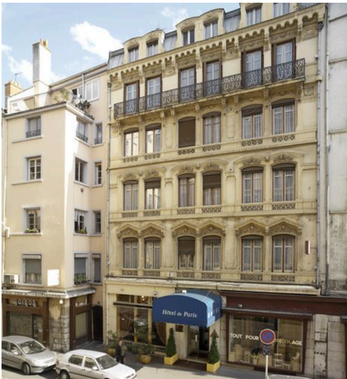
Façade principale sur rue
