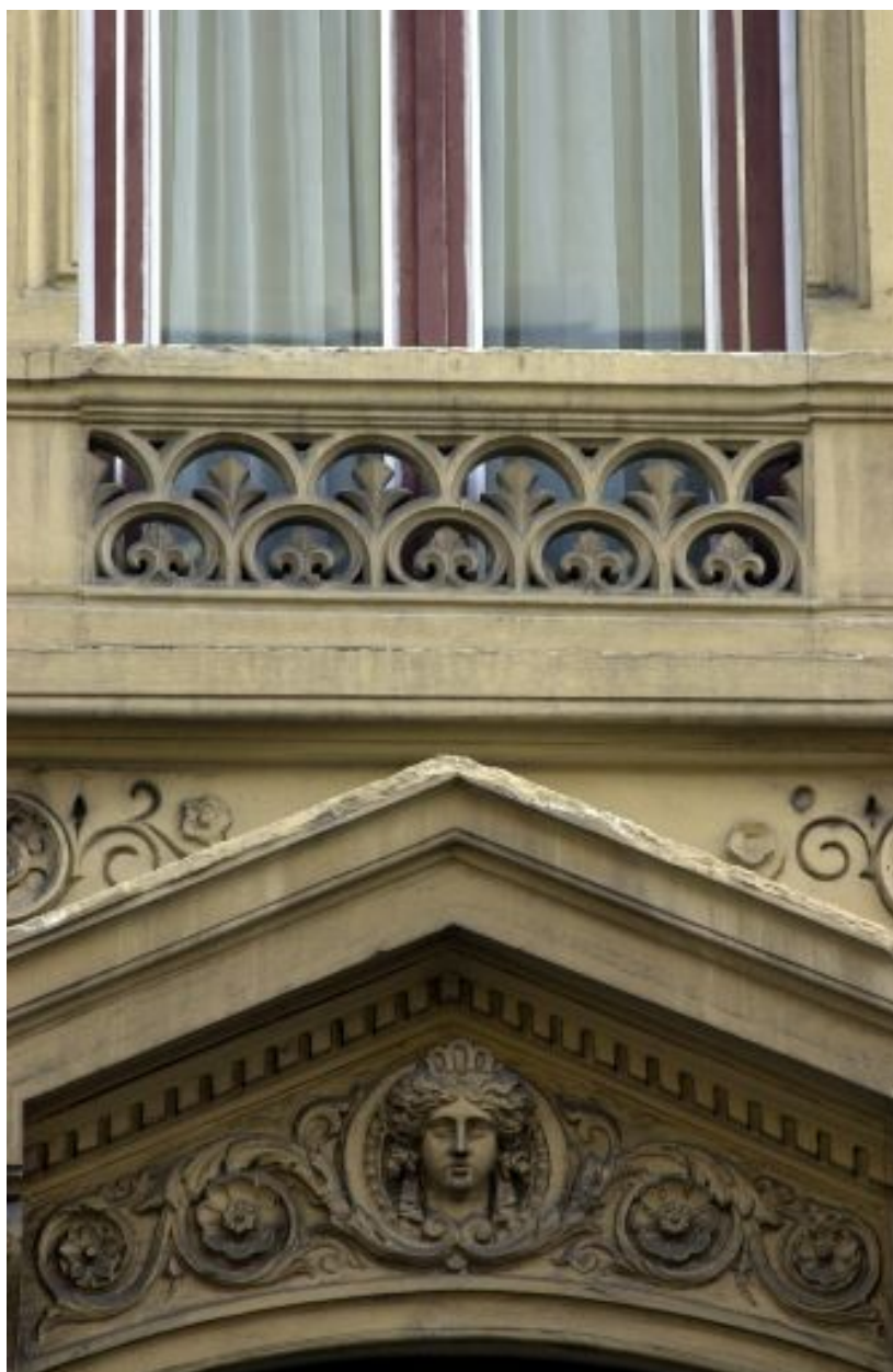
Façade principale, garde-corps du deuxième étage
