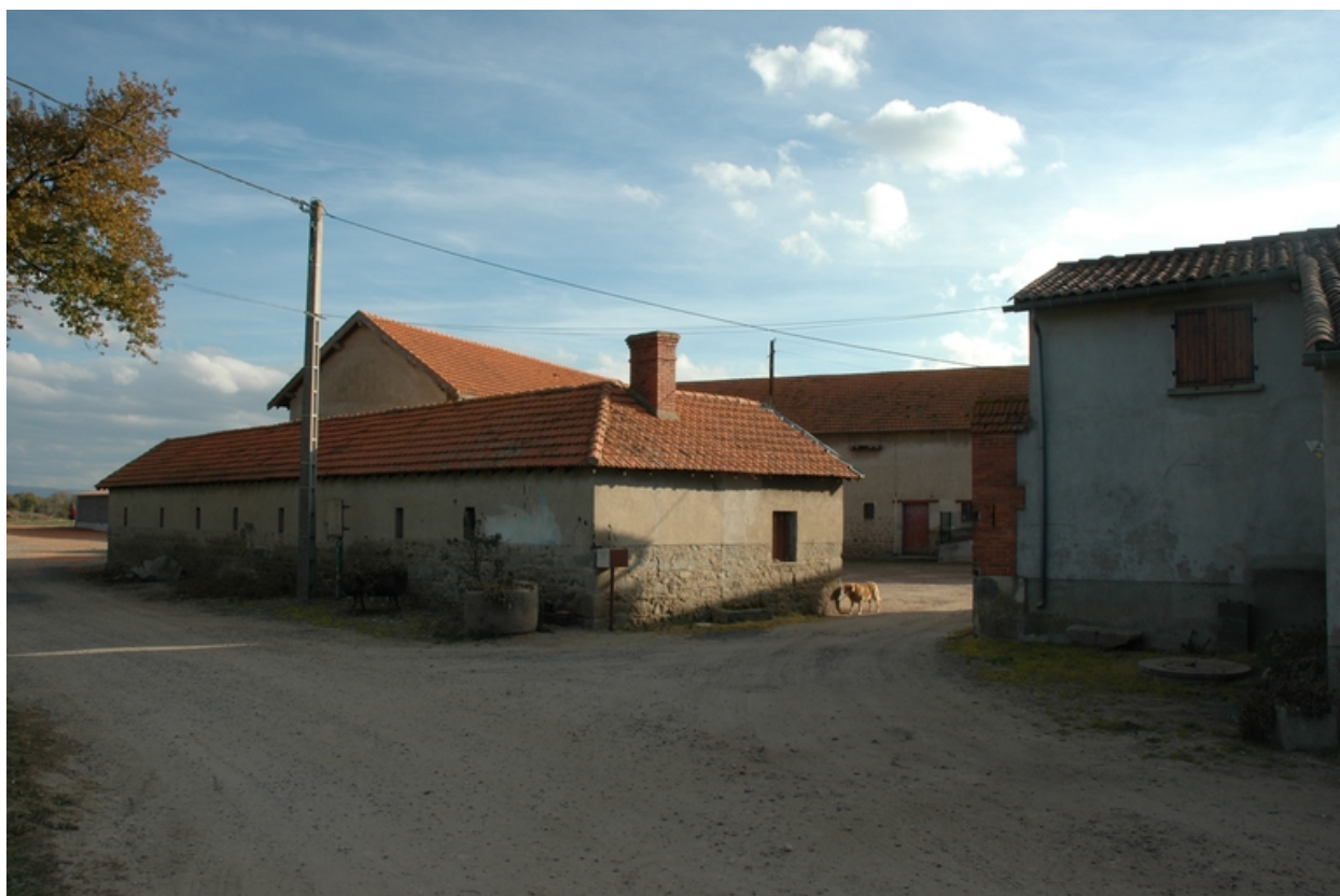
Vue des élévations nord de l'aile nord.
