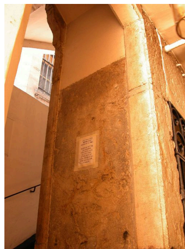
Noyau de la cage d'escalier Phot. David Chevallier IVR82_20066901464NUCA
