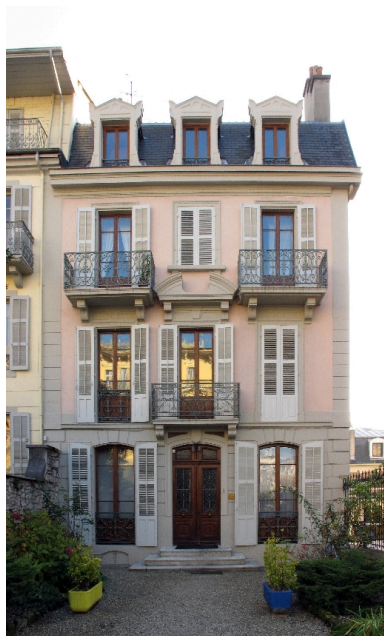
Façade principale Phot. François Fouger IVR82_20127300296NUCA
