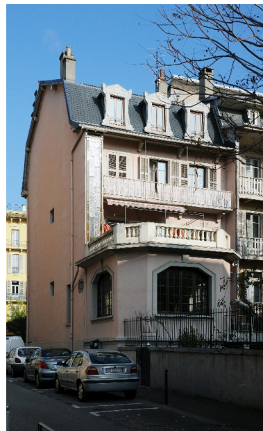
Elévation postérieure Phot. François Fouger IVR82_20127300295NUCA
