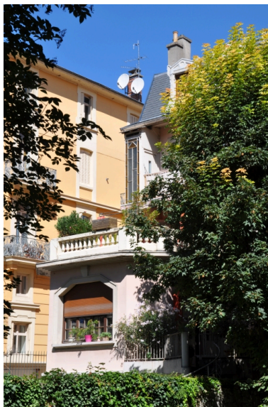
corps postérieur Phot. François Fouger IVR82_20117300480NUCA
