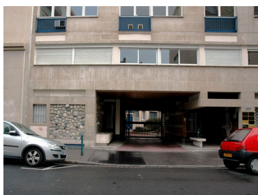
Vue de l'entrée Phot. Maryannick Chalabi IVR82_20076900477NUCA
