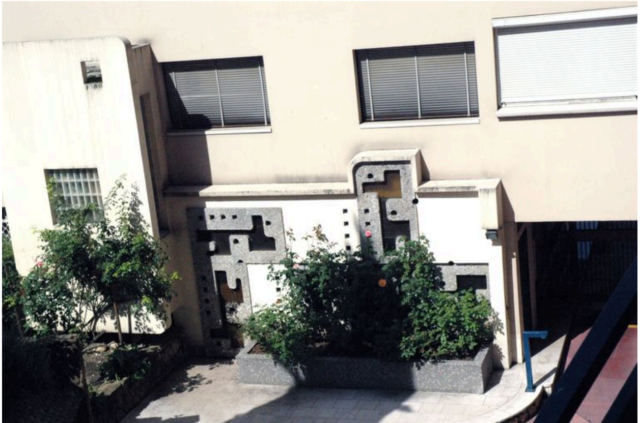
Détail du rez-de-chaussée de l'élévation postérieure
