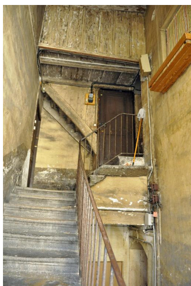
Vue intérieure : la dernière volée de l'escalier et l'échelle d'accès aux combles Phot. Catherine Guégan IVR82_20156902519NUCA
