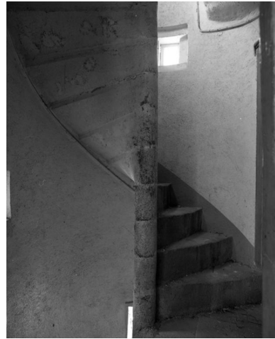
Détail de l'escalier en vis d'accès aux étages. Phot. Jean-Michel Périn IVR83_20096300314X
