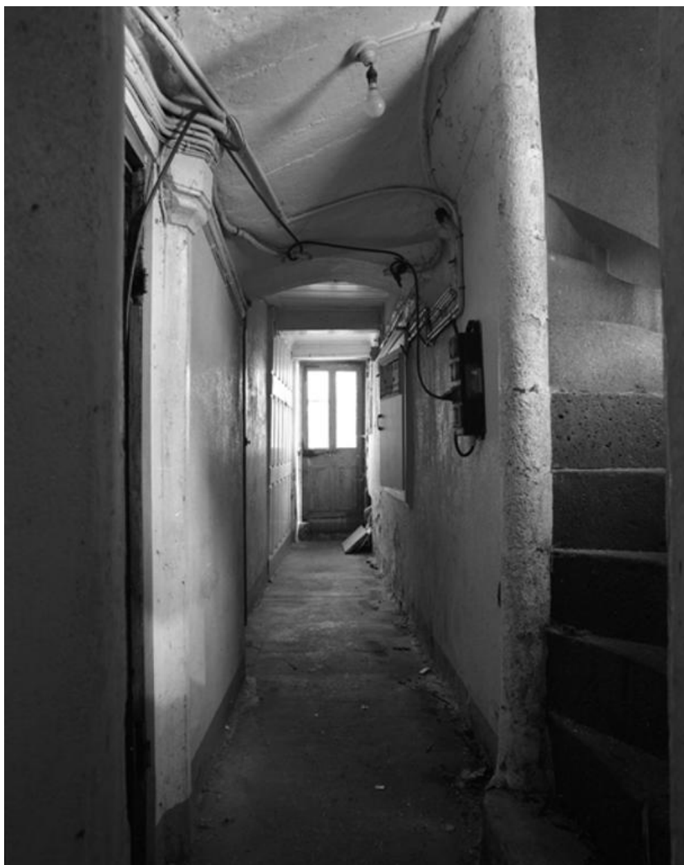
Couloir d'entrée de la maison avant travaux de reconstruction : à droite, départ de l'escalier donnant accès aux étages ; à gauche, porte d'accès à l'escalier en vis du sous-sol.
