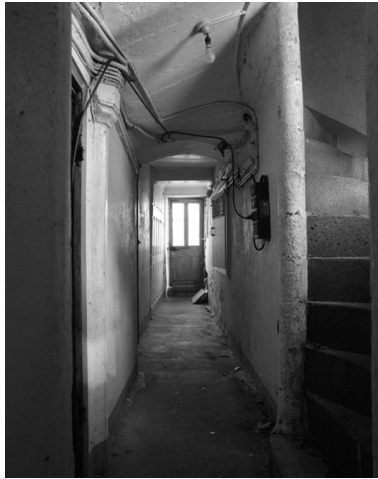
Couloir d'entrée de la maison avant travaux de reconstruction : à droite, départ de l'escalier donnant accès aux étages ; à gauche, porte d'accès à l'escalier en vis du sous-sol. Phot. Jean-Michel Périn IVR83_20096300311X
