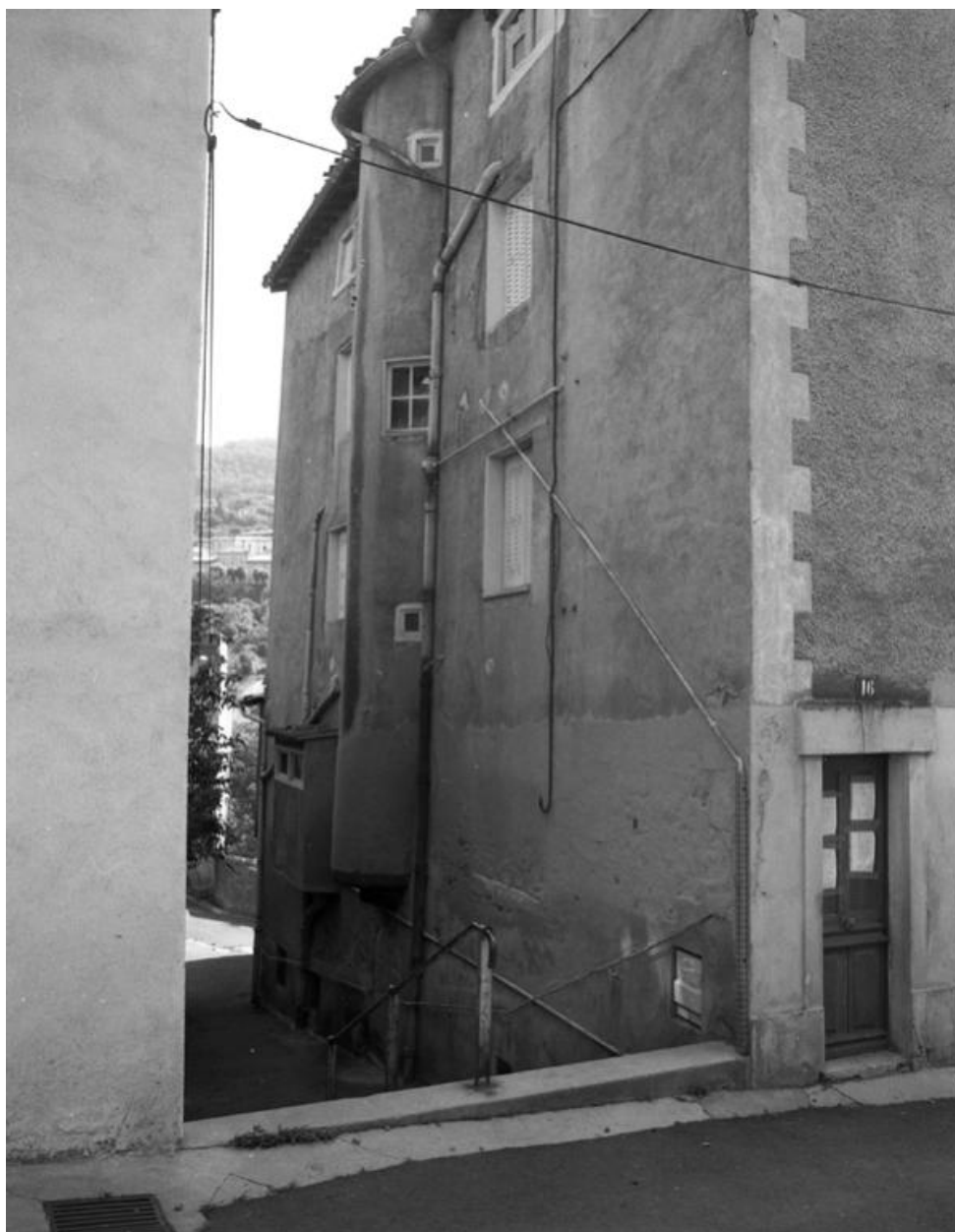
Elévation nord de la maison sur la ruelle adjacente, avant les travaux de reconstruction de 2011.
