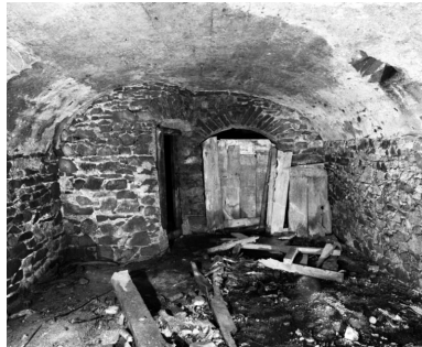
L'une des caves de la maison, avant travaux de reconstruction. Phot. Christian Parisey IVR83_20096300256X
