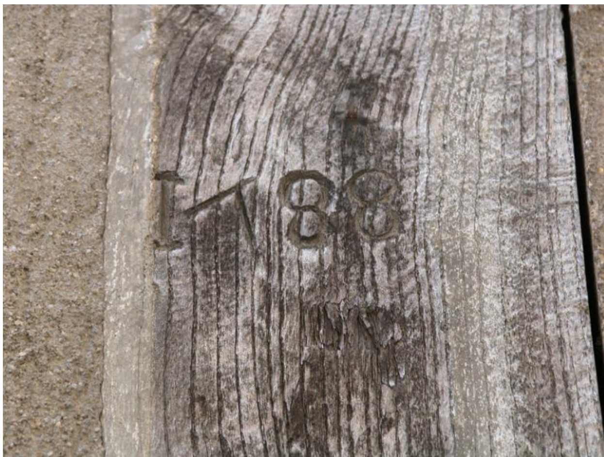
Date portée "1788" sur le montant d'une ancienne ouverture en bois, murée (peut-être une fenêtre d'atelier - voir figure précédente) : élévation nord de l'extension de la maison avant travaux de reconstruction (photographie chercheur).
