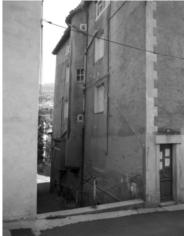
Elévation nord de la maison sur la ruelle adjacente, avant les travaux de reconstruction de 2011. Phot. Celsor Herrera-Nunez IVR83_20066300772X
