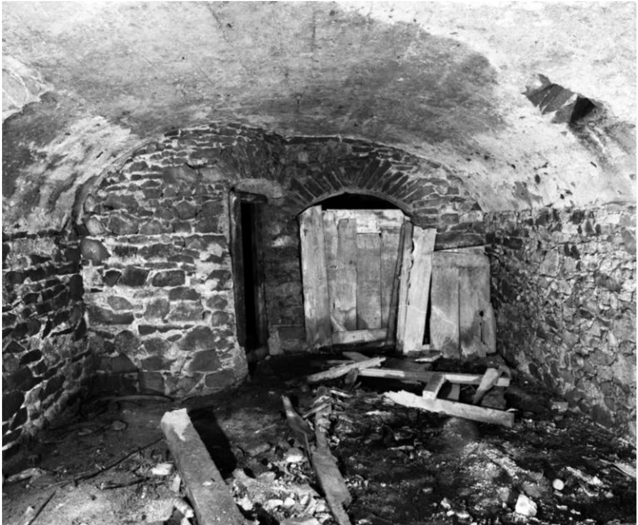
L'une des caves de la maison, avant travaux de reconstruction.
