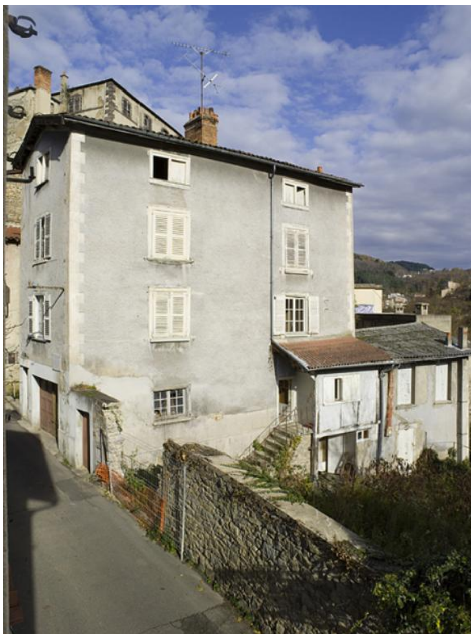
Jardin et élévation sud de la maison : état avant sa reconstruction et son agrandissement en 2011.
