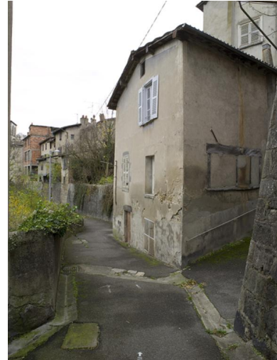
Extension est de la maison depuis le chemin des Murailles, avant travaux de reconstruction. Phot. Jean-Michel Périn IVR83_20096300365NUC4A
