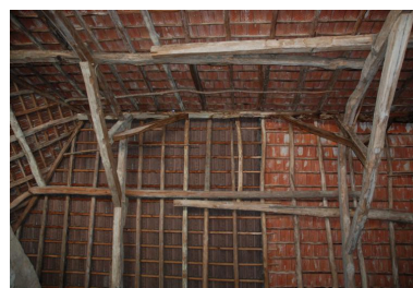
Vue intérieure de la charpente dans la grange. Phot. Thierry Monnet IVR84_20207400645NUCA
