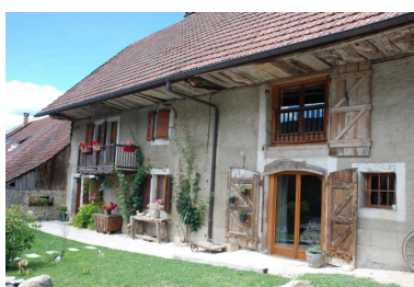
Vue de l'habitation ouest et de l'étable. Phot. Thierry Monnet IVR84_20207400647NUCA
