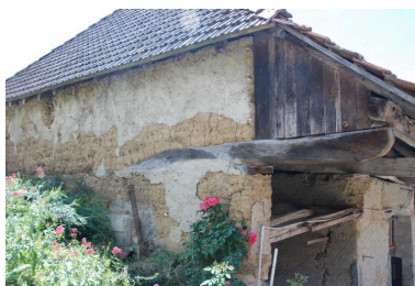
Grange-étable sud, détail du pignon en pisé. Phot. Thierry Monnet IVR84_20207400654NUCA
