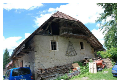
Vue du mur pignon est. Phot. Thierry Monnet IVR84_20207400643NUCA
