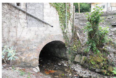
Détail du passage voûté. Phot. Clara Bérelle IVR82_20147302514NUCA
