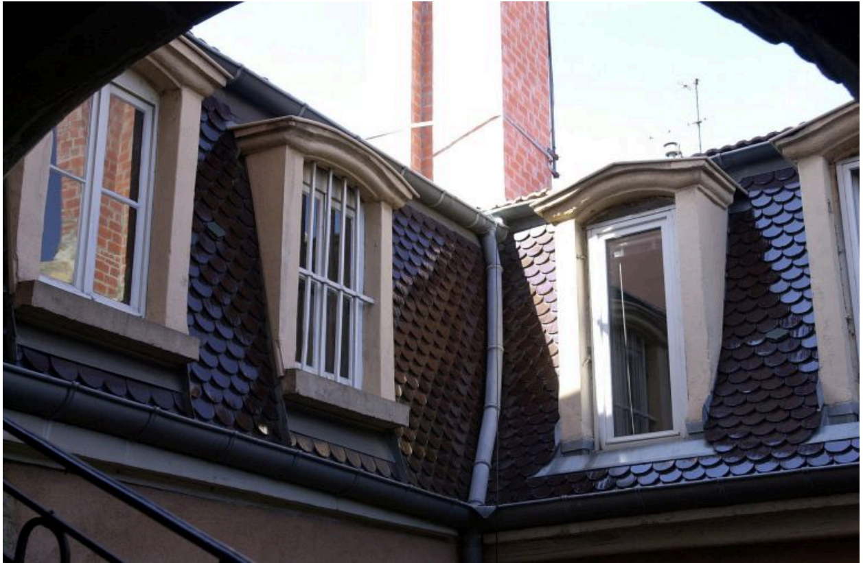
Etage de comble du bâtiment sur la rue Lanterne(à droite) et d'un corps de liaison, vue prise de l'escalier
