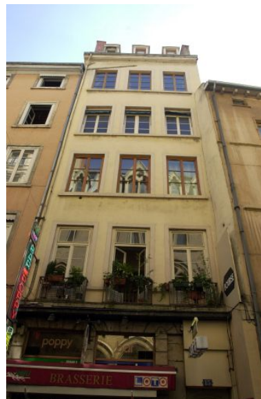
Façade sur la rue Lanterne Phot. Bernard Ducouret IVR82_20036901305NUCA
