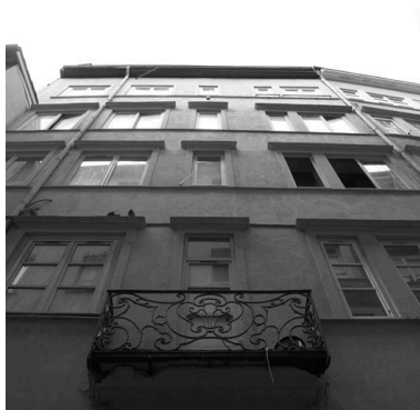
Façade sur la rue du Major-Martin, vue générale par-dessous Phot. Didier Gourbin IVR82_20056901547NUC
