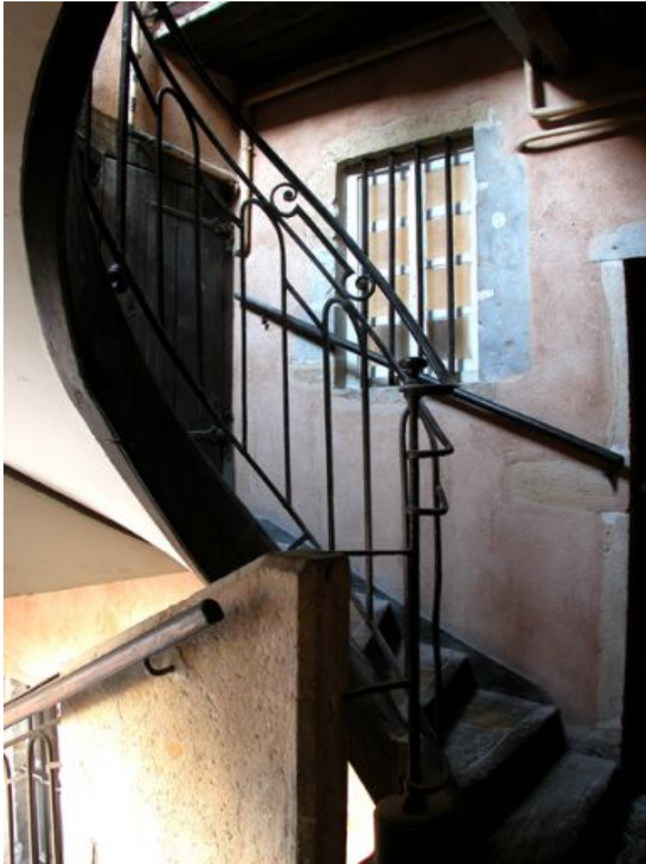
Pavillon d'escalier, palier du 5e étage, départ du petit escalier desservant la pièce sommitale
