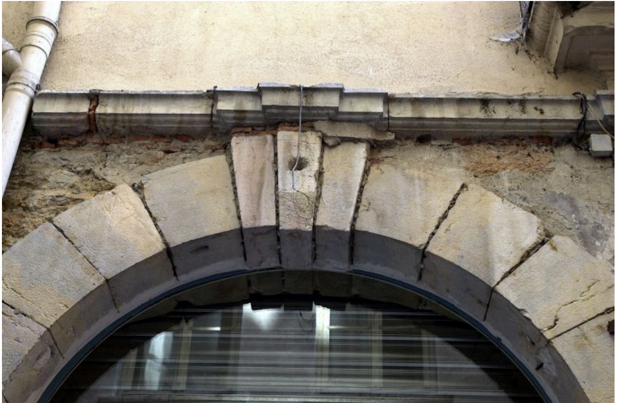
Façade sur la rue Major-Martin, ouverture de boutique de gauche, détail de la clef de l'arc
