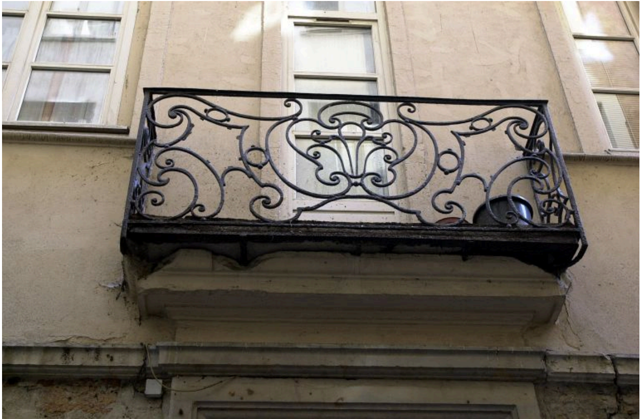
Façade sur la rue Major-Martin, balcon du 1er étage
