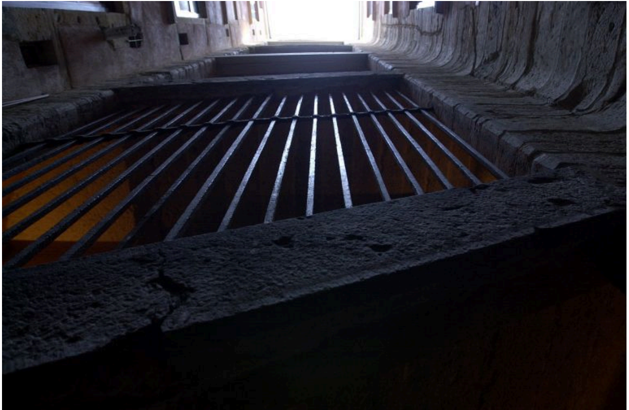
Pavillon d'escalier, façade sur cour
