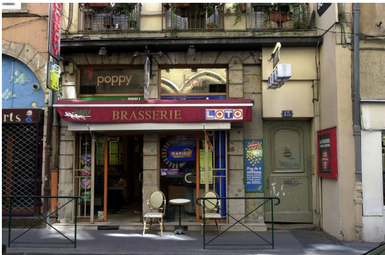
Façade sur la rue Lanterne, rez-de-chaussée
