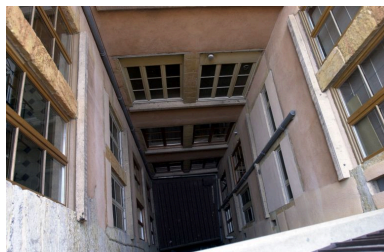
Vue plongeante sur la cour depuis l'escalier Phot. Bernard Ducouret IVR82_20036901299NUCA
