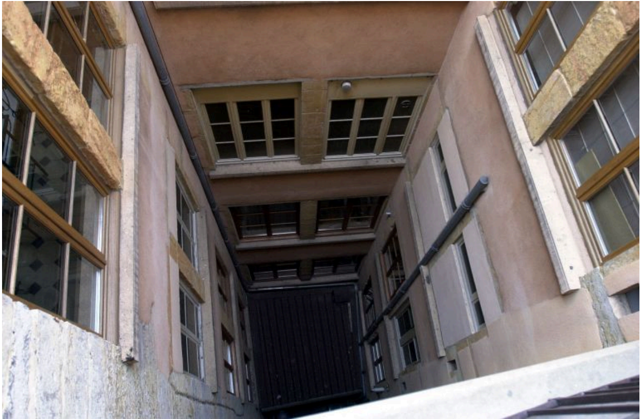
Vue plongeante sur la cour depuis l'escalier
