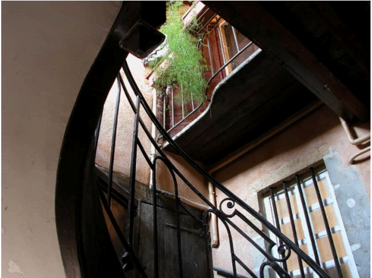
Pavillon d'escalier, escalier et petite coursière desservant la pièce sommitale, vue depuis le palier du 5e étage
