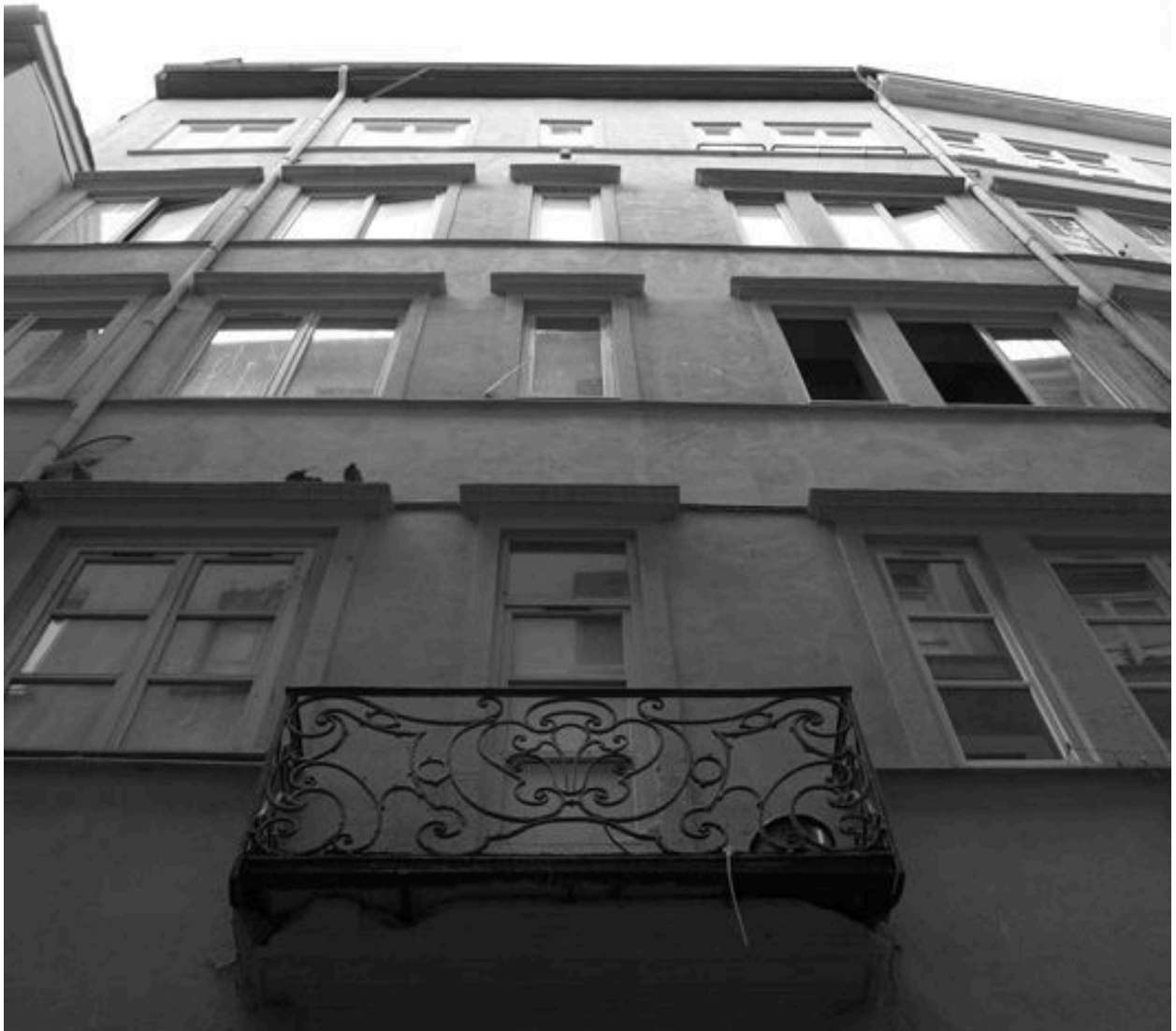
Façade sur la rue du Major-Martin, vue générale par-dessous
