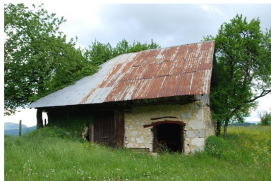
Vue d'ensemble extérieure de trois-quarts avant droit. Phot. Thierry Monnet IVR84_20187400272NUCA
