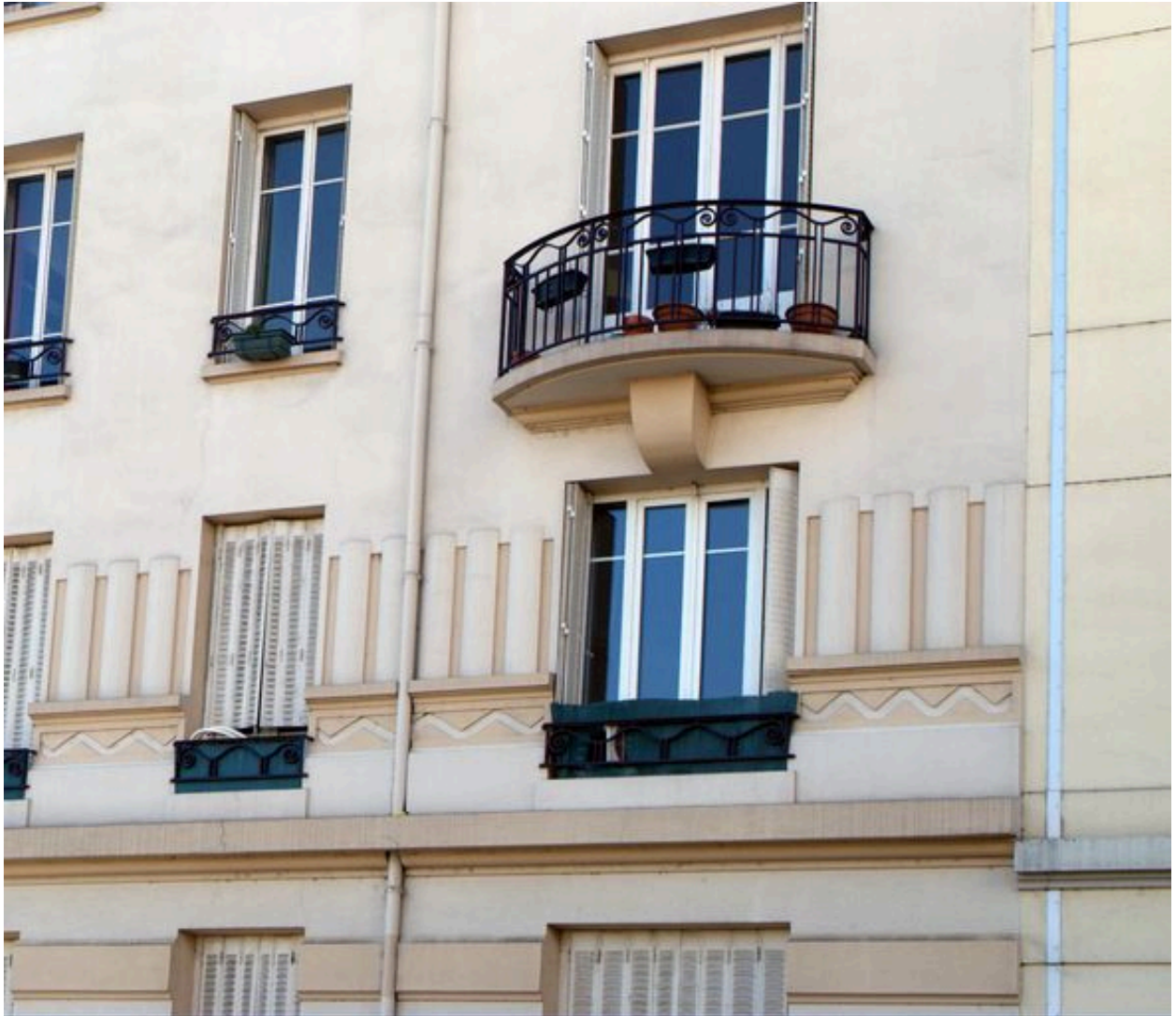
Elévation nord, détail des baies
