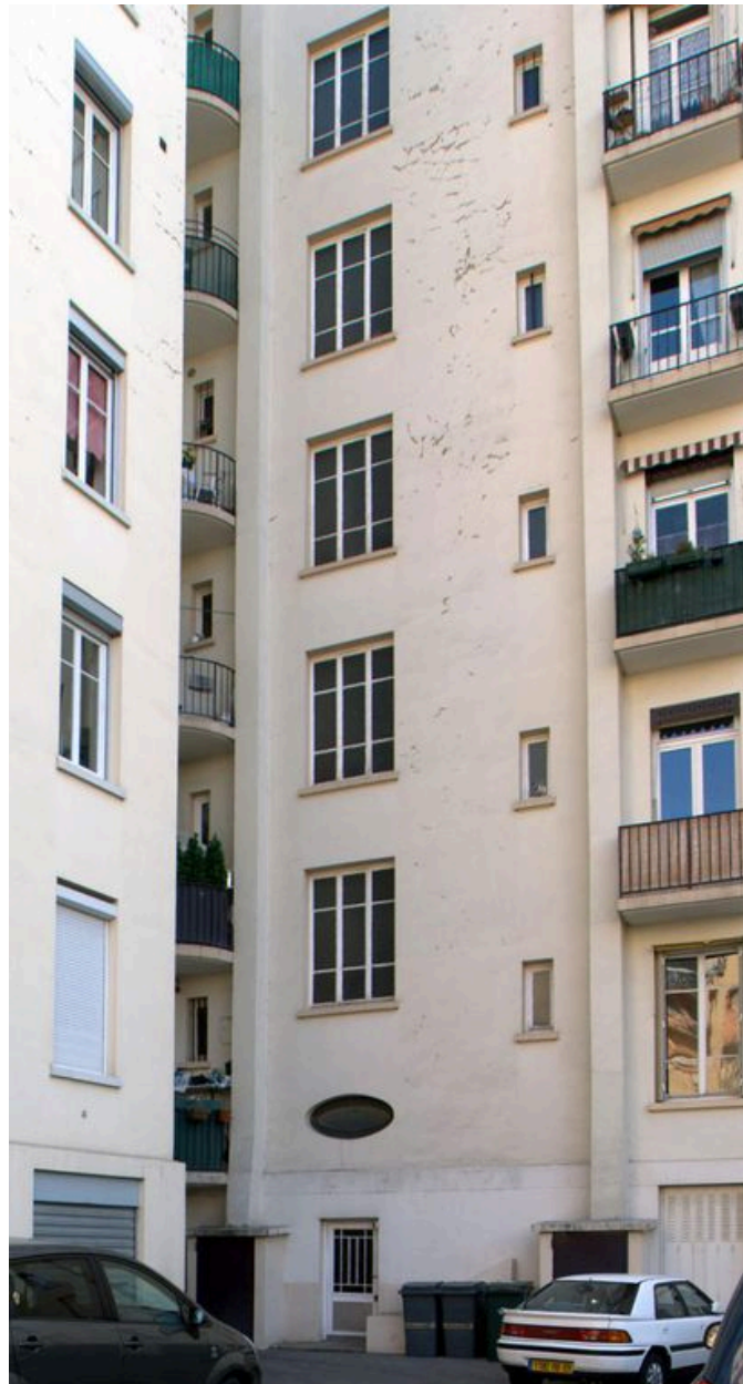
Elévation postérieure, détail de l'angle des deux corps de bâtiment
