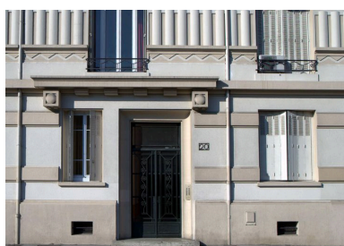
Porte sur rue Phot. Maryannick Chalabi IVR82_20116904941NUCA
