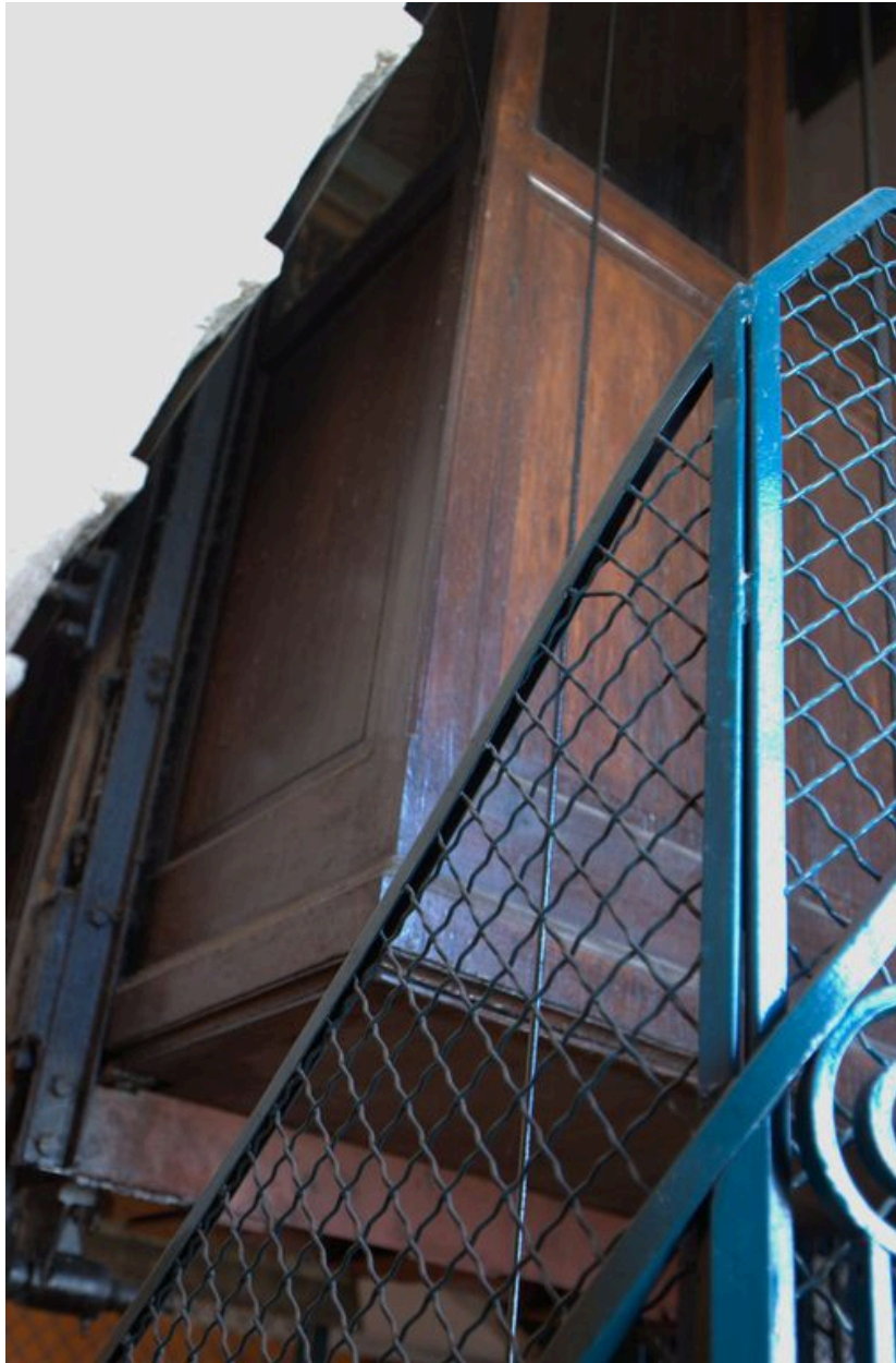
Ascenseur, cabine, vue arrière, par en-dessous
