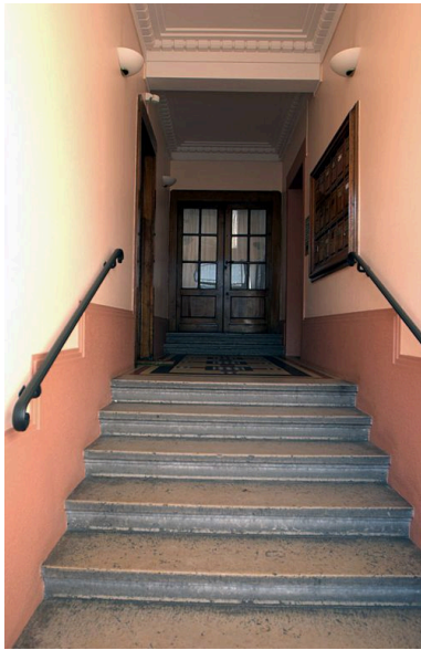
Escalier droit et vestibule Phot. Maryannick Chalabi IVR82_20116904945NUCA
