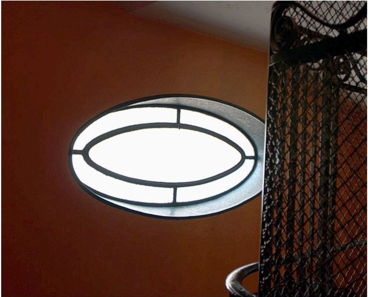
Oculus oblong, dernier repos de l'escalier
