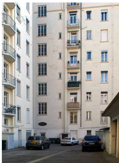
Elévation postérieure depuis l'ouest Phot. Maryannick Chalabi IVR82_20116904943NUCA
