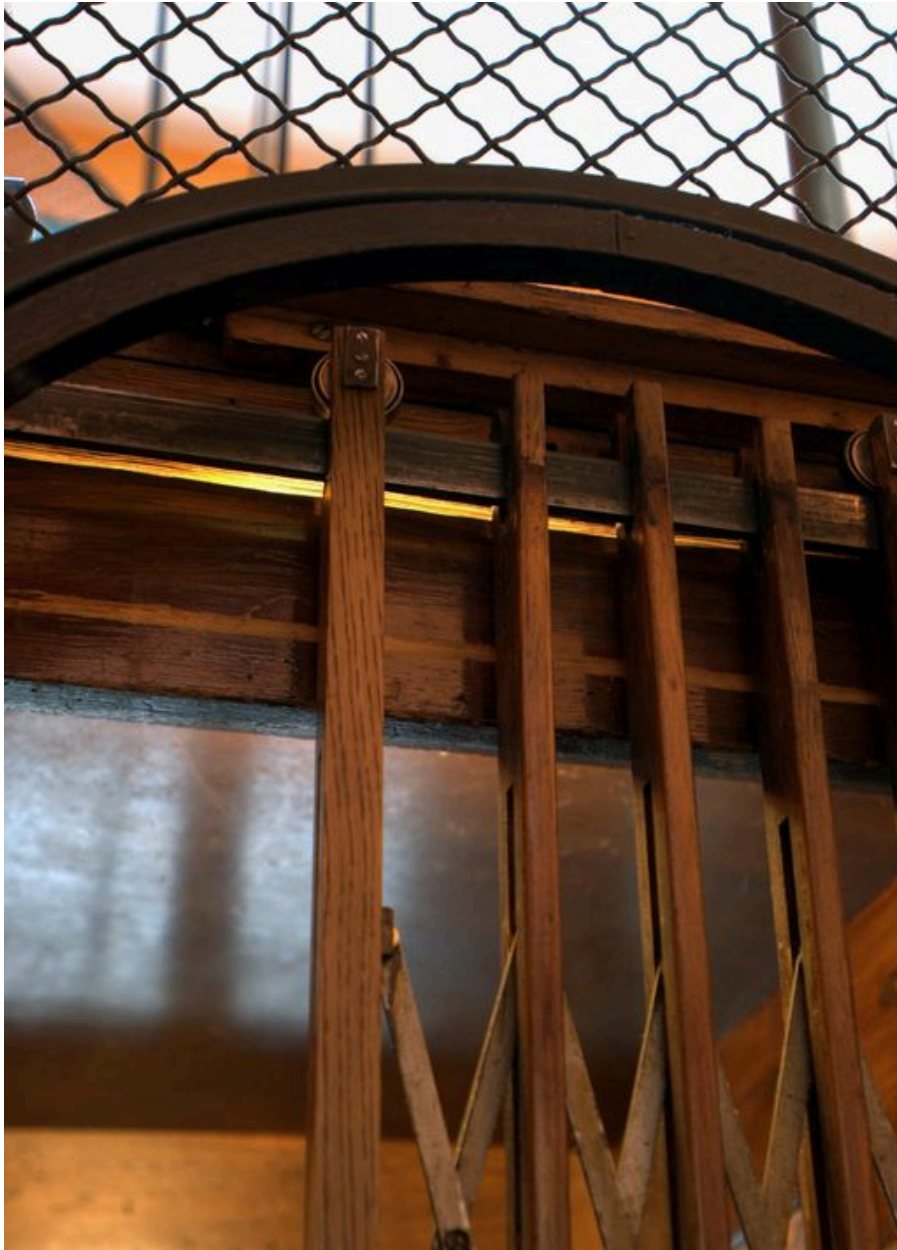
Ascenseur, cabine, détail du volet roulant
