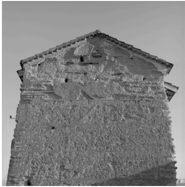
Colombier, détail du pisé du pignon gauche. Phot. Eric Dessert IVR82_20024201588X
