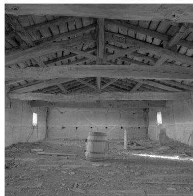
Vue intérieure du grenier, sous la charpente. Phot. Eric Dessert IVR82_20034200208X
