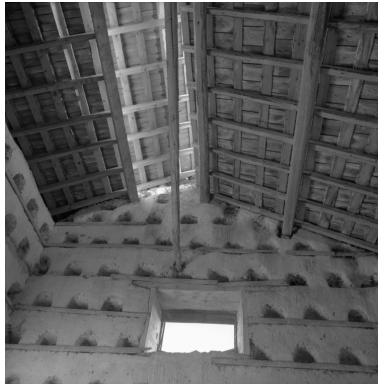
Colombier, vue intérieure : trous de boulins et toiture. Phot. Eric Dessert IVR82_20024201590X
