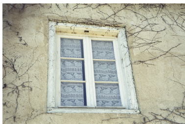
Logis à aître, élévation latérale droite, détail de la baie du premier étage. Phot. Thierry Monnet IVR82_20044200528ZE
