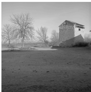
Colombier, vue d'ensemble. Phot. Eric Dessert IVR82_20024201586X
