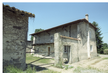
Vue d'ensemble du logis à âître depuis la deuxième cour. Phot. Thierry Monnet IVR82_20044200527ZE
