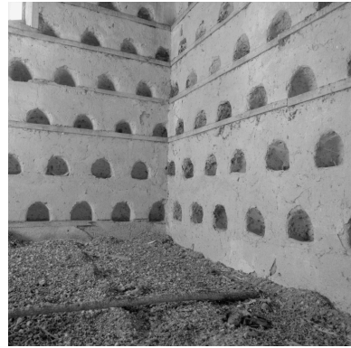
Colombier, vue intérieure. Phot. Eric Dessert IVR82_20024201589X
