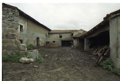
Vue d'ensemble des dépendances depuis l'ouest. Phot. Caroline Guibaud IVR82_20044200611ZE
