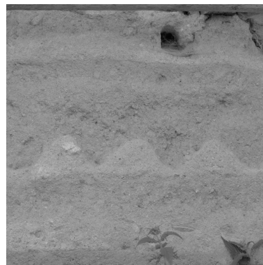
Détail du pisé de la façade antérieure du cuvage. Phot. Eric Dessert IVR82_20024200470X
