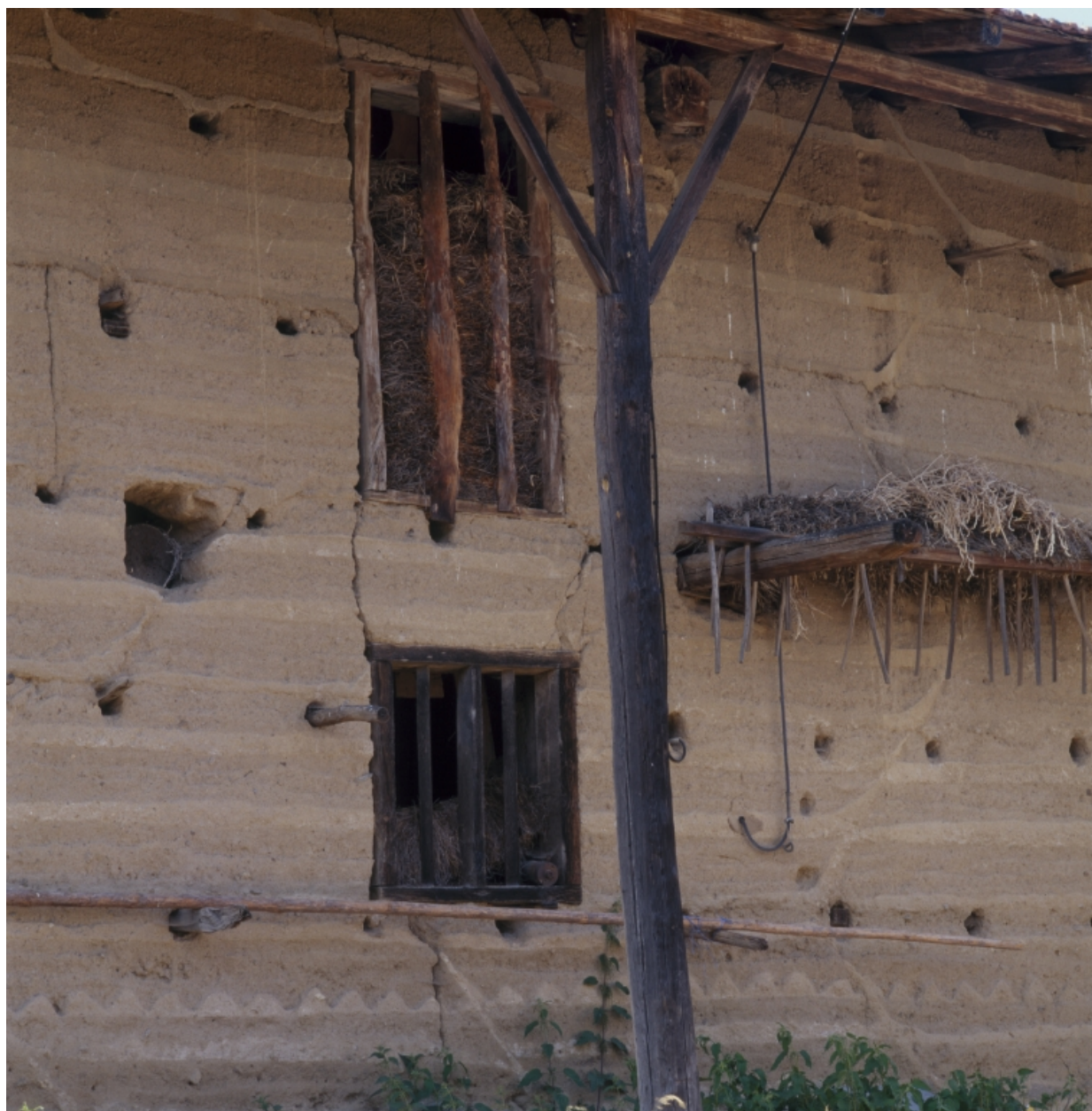
Détail de la façade antérieure du cuvage.
