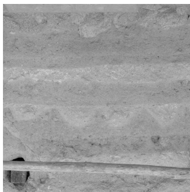
Détail du pisé du cuvage. Phot. Eric Dessert IVR82_20044200623X
