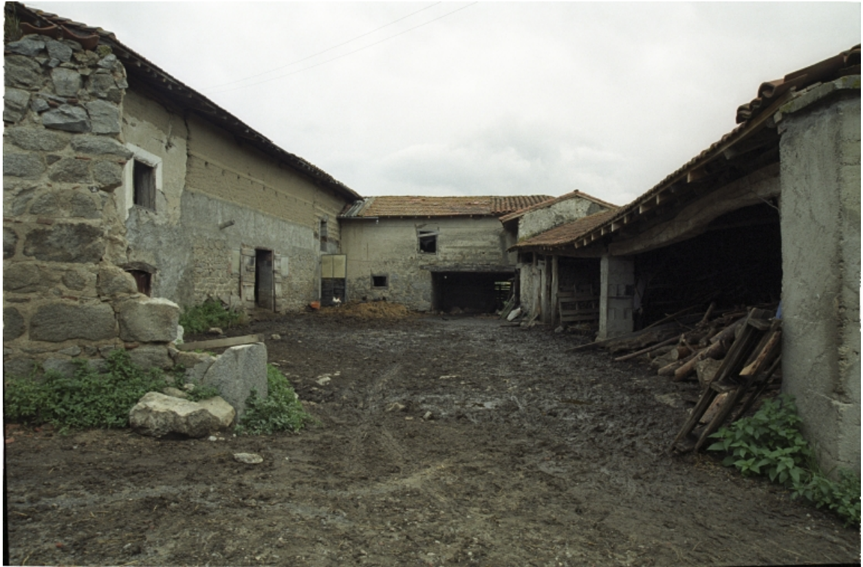
Vue d'ensemble des dépendances depuis l'ouest.
