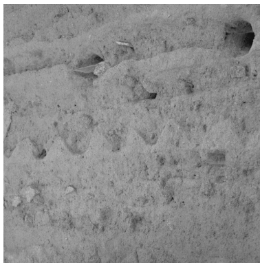
Détail du pisé de la façade antérieure du cuvage. Phot. Eric Dessert IVR82_20024200469X
