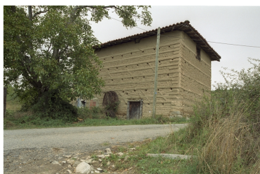
Vue d'ensemble de la grange étable située à l'entrée du hameau au nord-est, depuis l'ouest. Phot. Caroline Guibaud IVR82_20044200613ZE
