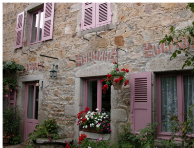
Vue du logis. Phot. Caroline Guibaud IVR82_20124201678NUCA
