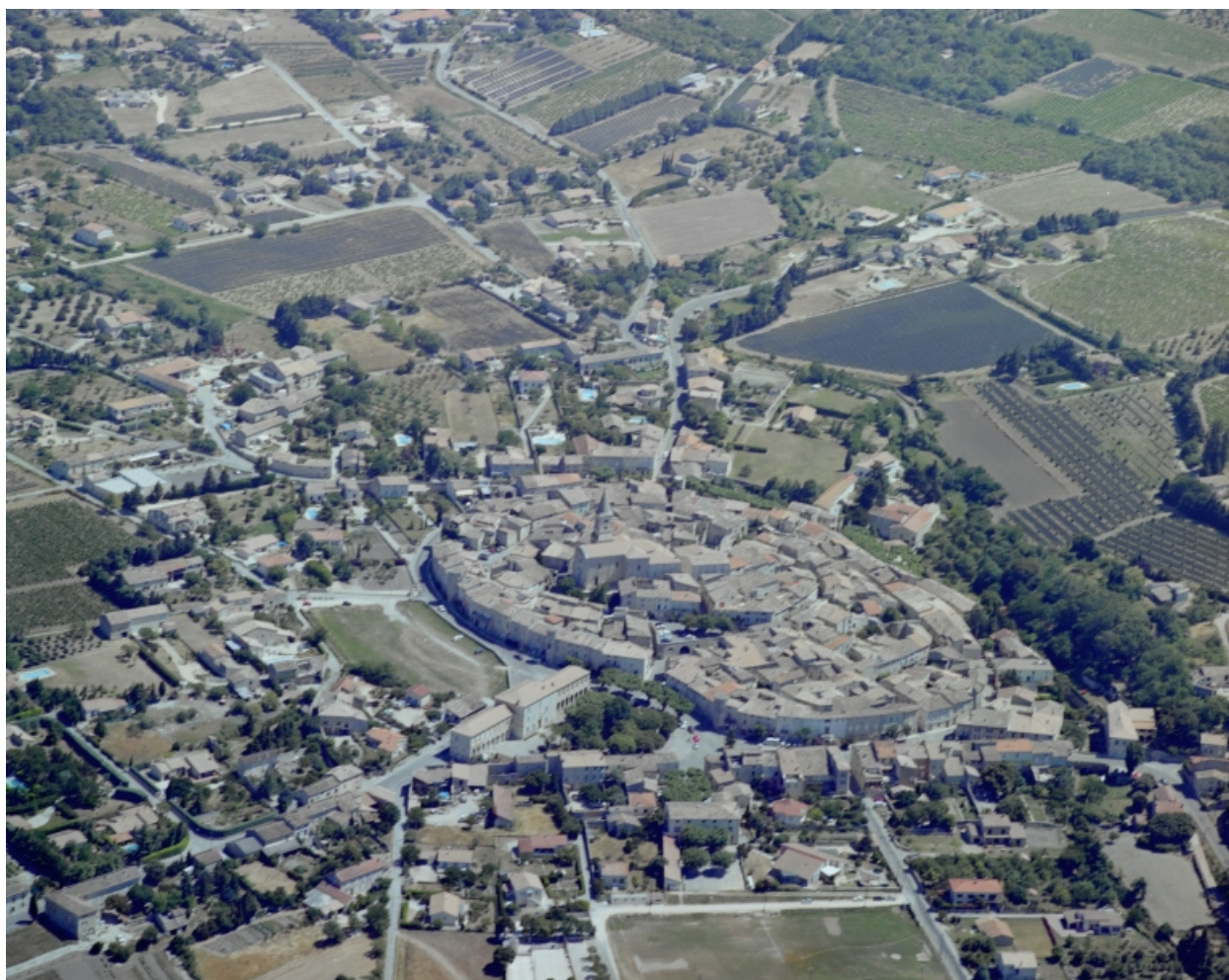
Vue aérienne, prise du sud-ouest.
