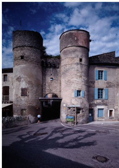
La porte Nord. Phot. Jean-Marie Refflé IVR82_20002600977PA
