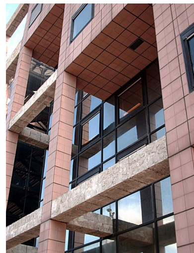
élévation antérieure : détail des matériaux
