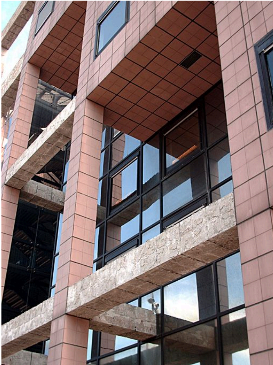
élévation antérieure : détail des matériaux
