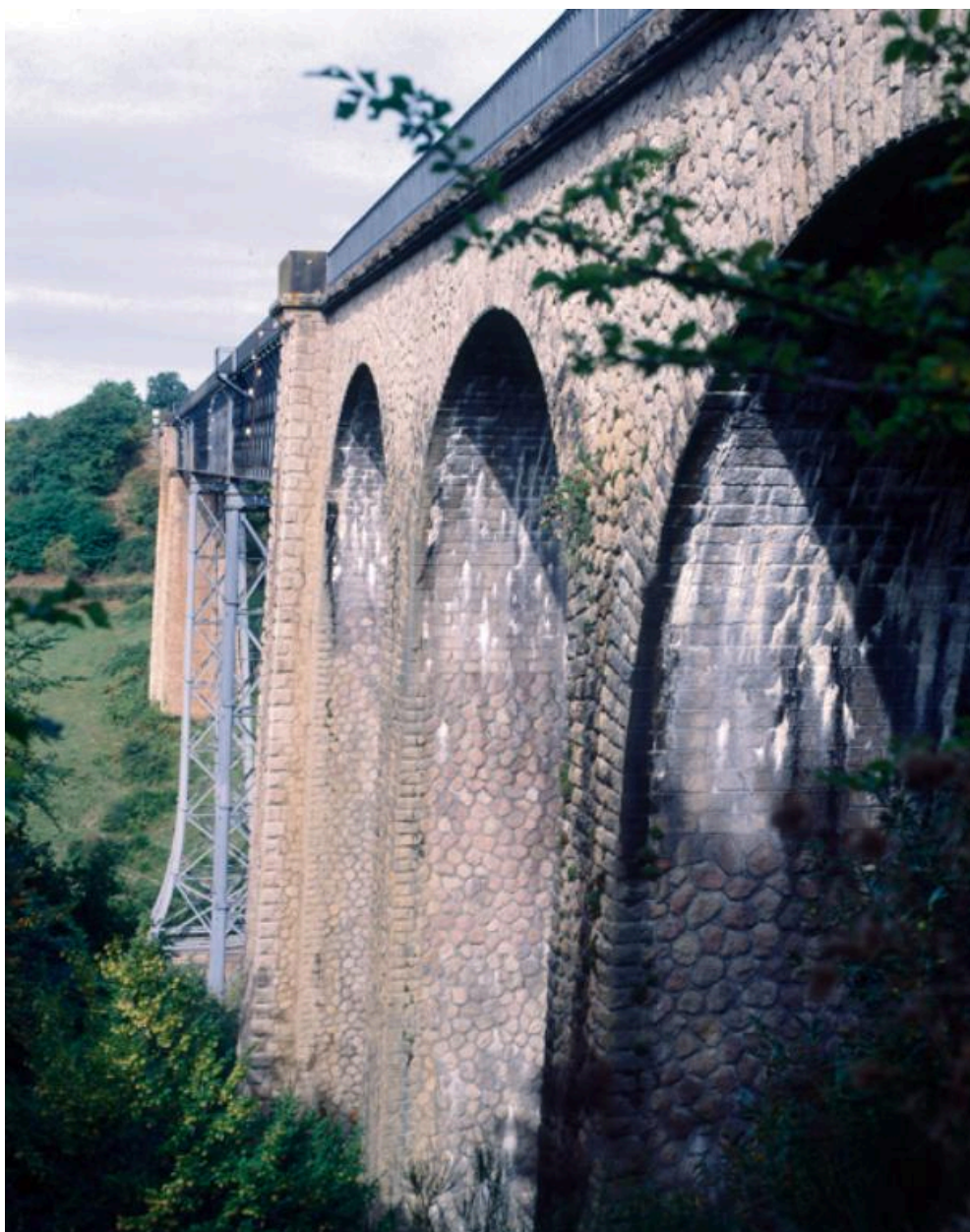
Vue du viaduc de trois quarts.
