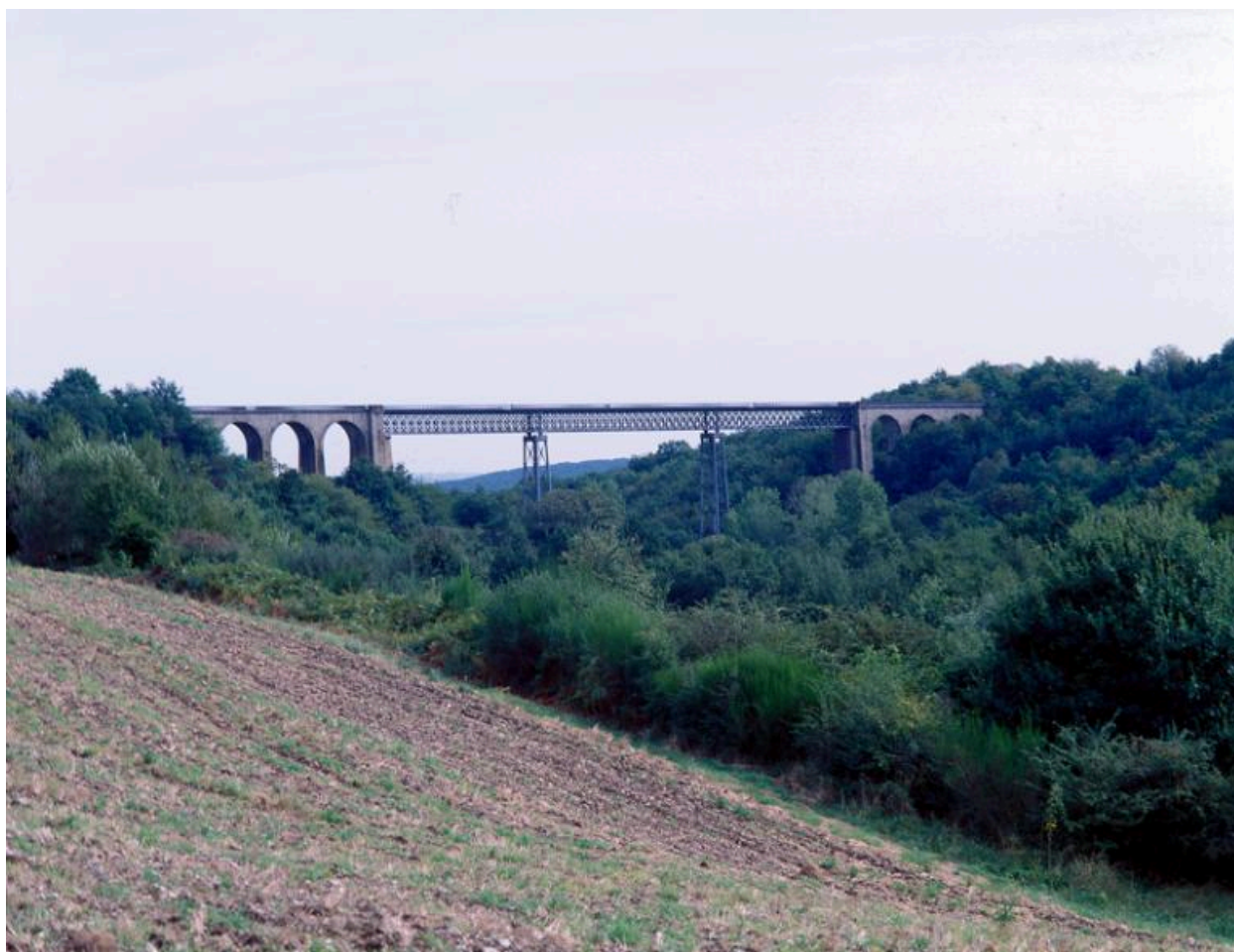
Vue du viaduc dans le site.
