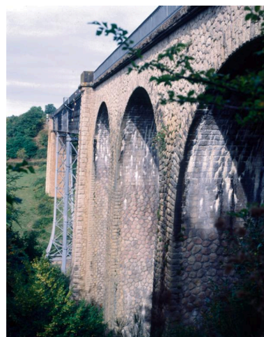
Vue du viaduc de trois quarts. Phot. Roger Choplain, Phot. Roland Maston IVR83_19920300033XA
