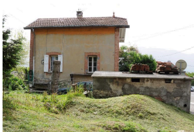
Façade ouest Phot. Denys Harreau IVR82_20147300860NUCA
