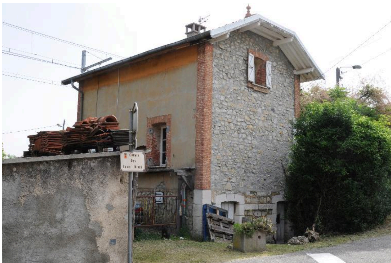
Façade ouest et pignon sud
