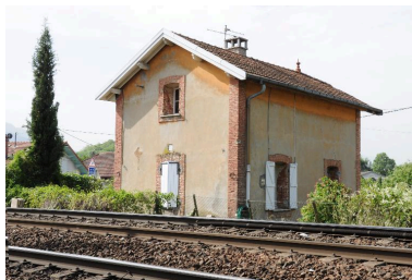
Pignon nord et façade ouest Phot. Denys Harreau IVR82_20147300857NUCA
