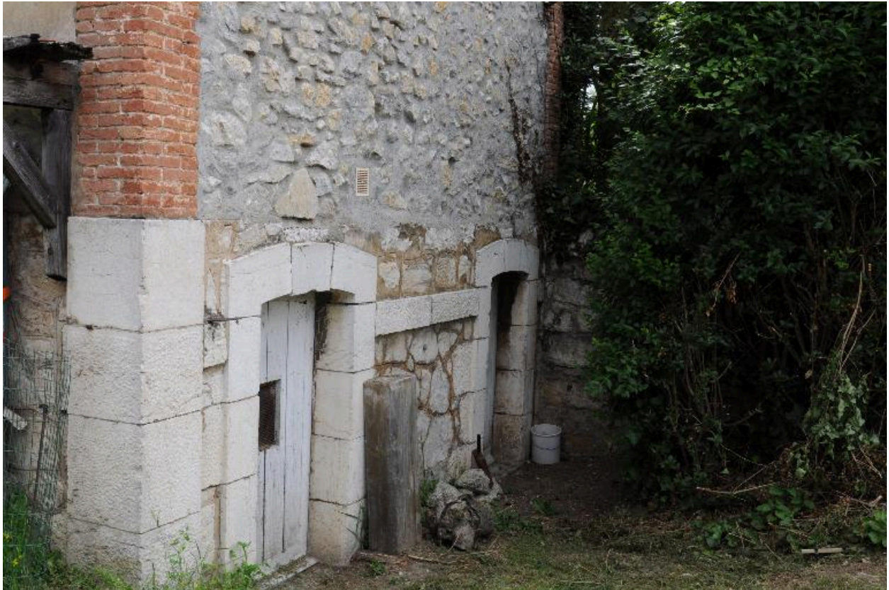
Portes dans le pignon sud
