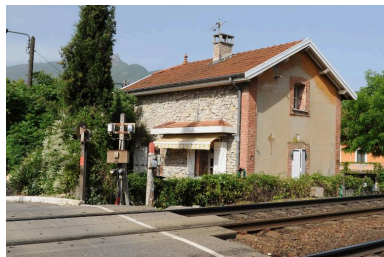
Vue d'ensemble Phot. Denys Harreau IVR82_20147300856NUCA
