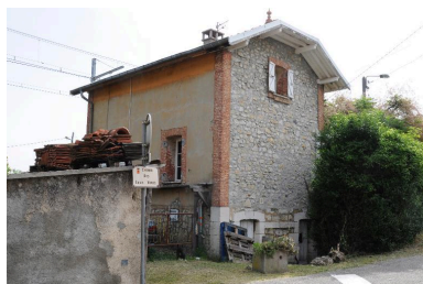
Façade ouest et pignon sud Phot. Denys Harreau IVR82_20147300859NUCA
