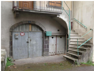
Portes du rez-de-chaussée (du cuveau et du chai situé en sous-sol). Phot. Bruno Decrock IVR84_20206300065NUCA
