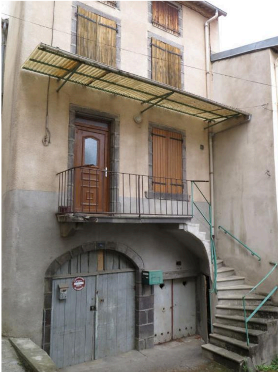
Vue partielle de la façade principale
