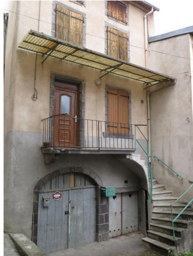
Vue partielle de la façade principale Phot. Bruno Decrock IVR84_20206300066NUCA
