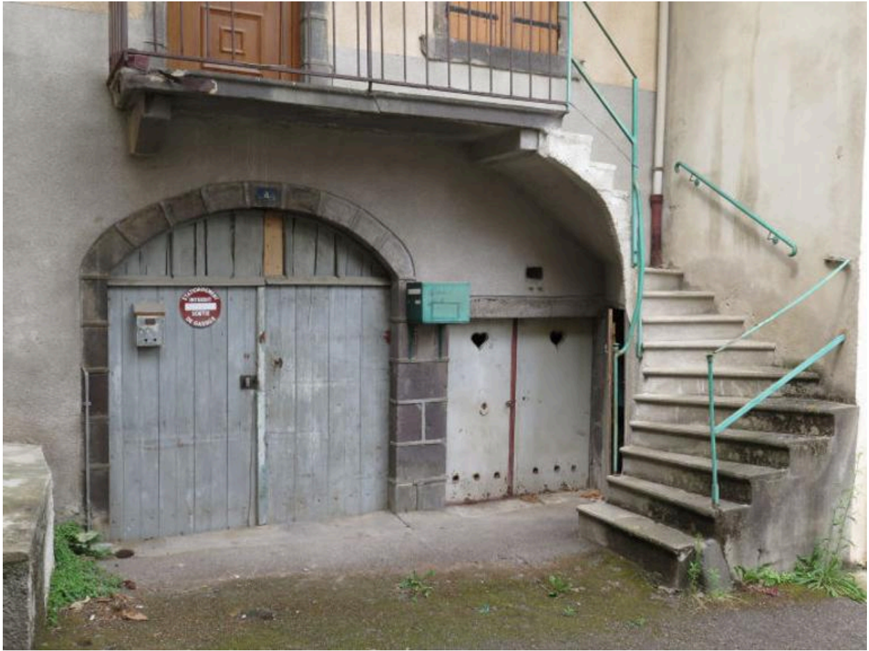
Portes du rez-de-chaussée (du cuvage et du chai situé en sous-sol).
