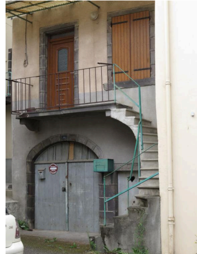
Vue rapprochée de la façade Phot. Bruno Decrock IVR84_20206300064NUCA
