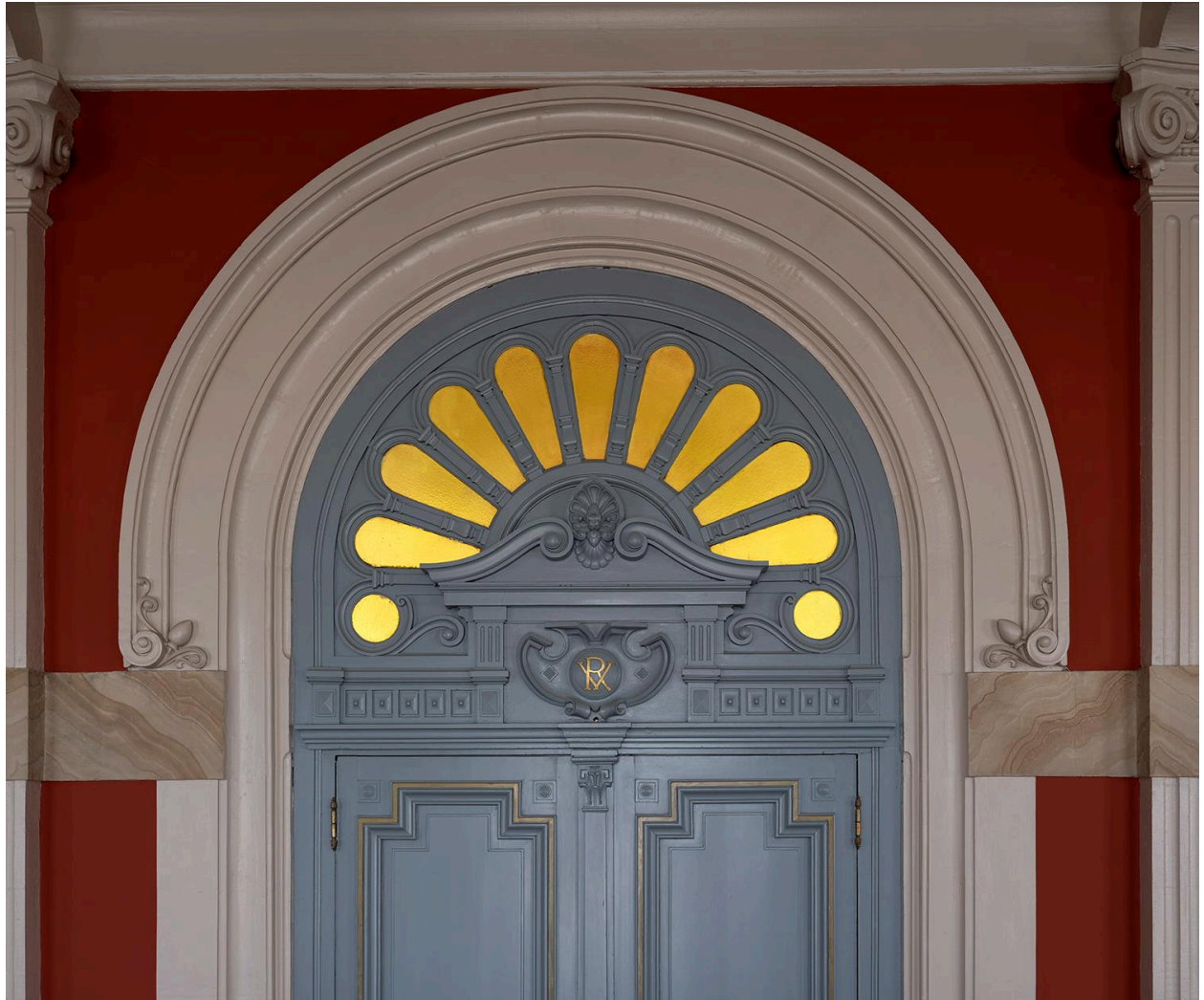
Salle du Conseil municipal, détail d'une porte
