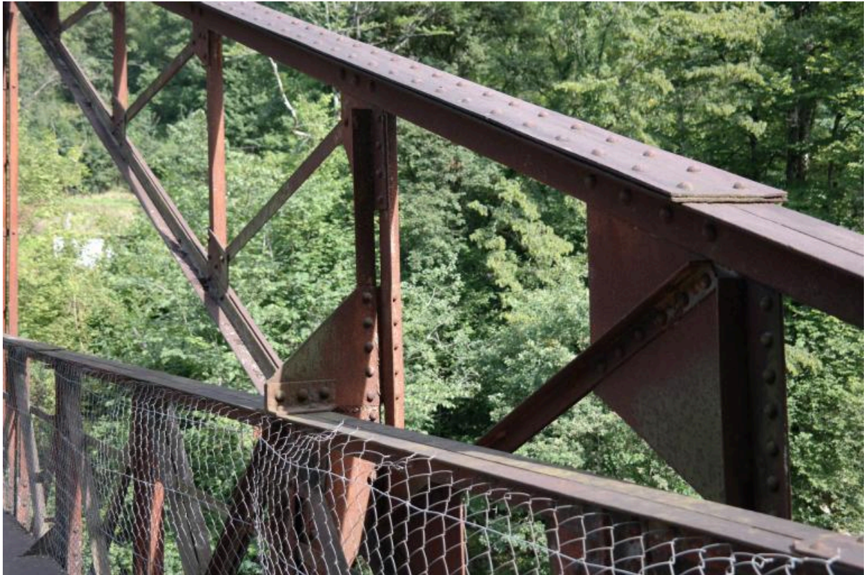
Passerelle de la plâtrière d'Armoÿ, détail de la structure métallique
