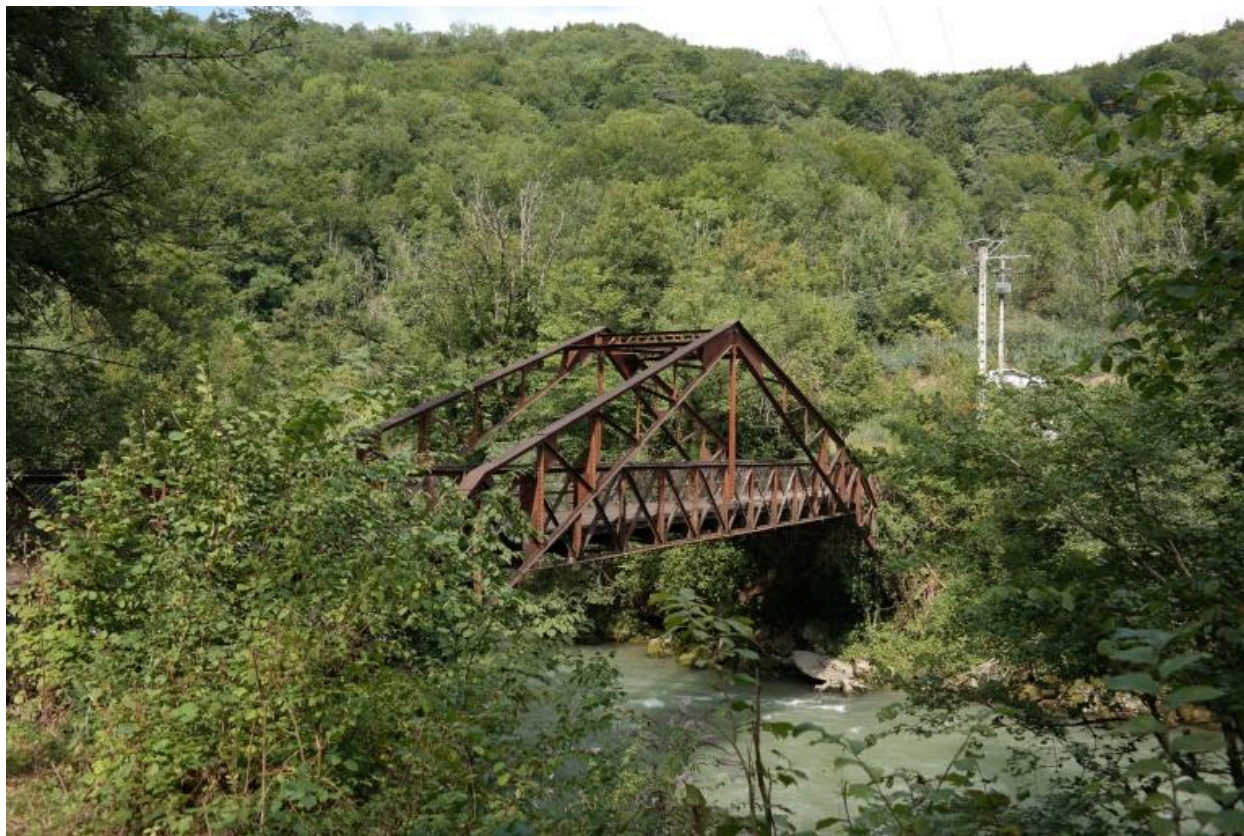
Passerelle de la plâtrière d'Armoÿ, vue de la face amont
