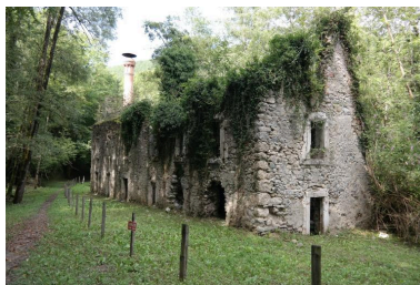
Plâtrière d'Armoy, anciens bâtiment et cheminée Phot. Pascale Renard IVR84_20207401633NUCA
