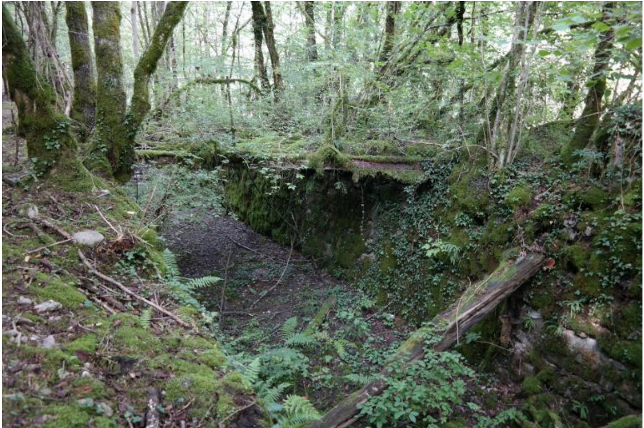
Plâtrière d'Armoÿ, ancien canal de dérivation de la Dranse
