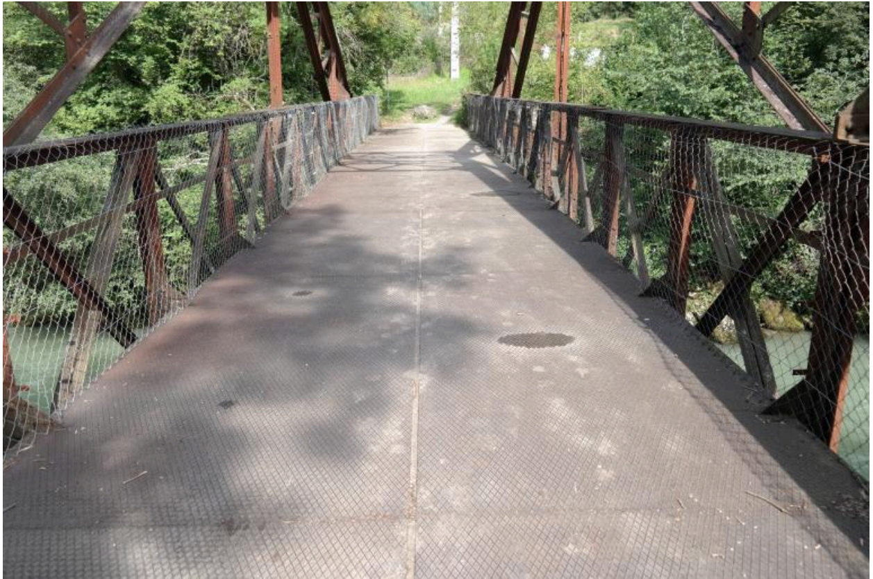
Passerelle de la plâtrière d'Armoÿ, tablier et garde-corps
