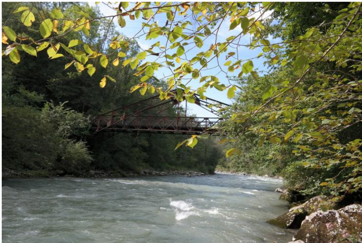
Passerelle de la plâtrière d'Armoiy, vue de la face aval
