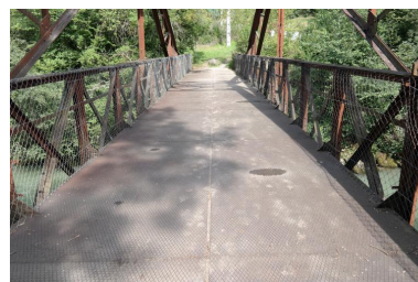
Passerelle de la plâtrière d'Armo y, tablier et garde-corps Phot. Pascale Renard IVR84_20207401629NUCA
