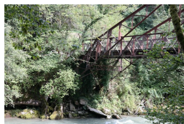
Passerelle de la plâtrière d'Armo y, détail de la structure vers la berge Phot. Pascale Renard IVR84_20207401641NUCA
