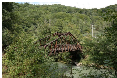
Passerelle de la plâtrière d'Armo y, vue de la face amont Phot. Pascale Renard IVR84_20197401223NUCA
