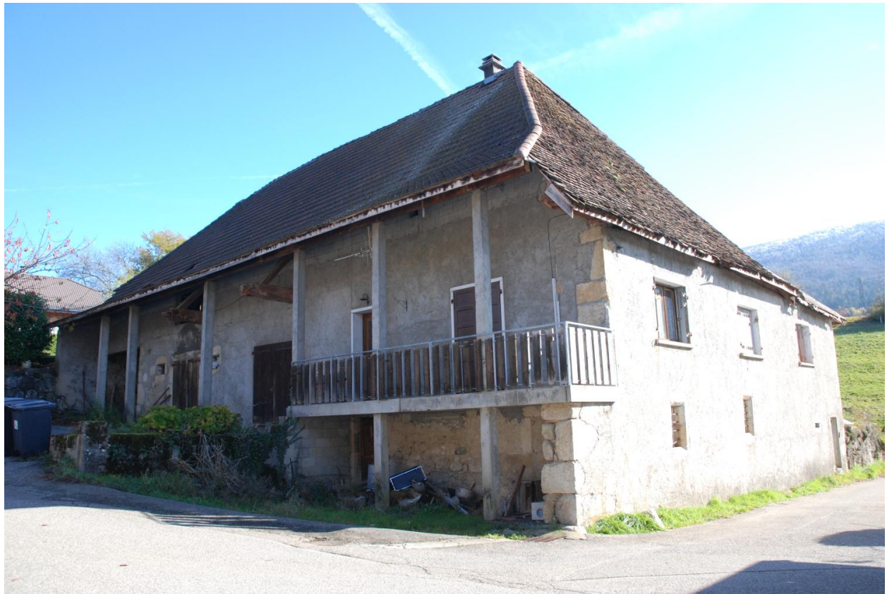
Vue d'ensemble, du nord.
