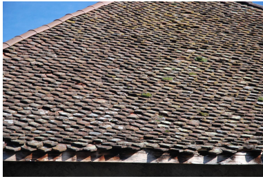
Détail des tuiles en écaille sur la croupe sud-ouest. Phot. Thierry Monnet IVR84_20207402777NUCA
