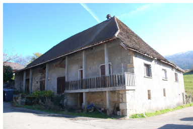
Vue d'ensemble, du nord. Phot. Thierry Monnet IVR84_20207402769NUCA
