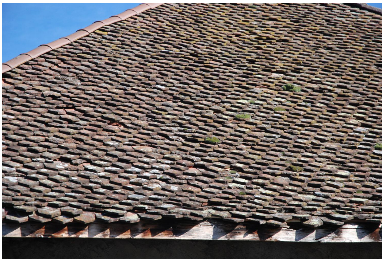
Détail des tuiles en écaille sur la croupe sud-ouest.
