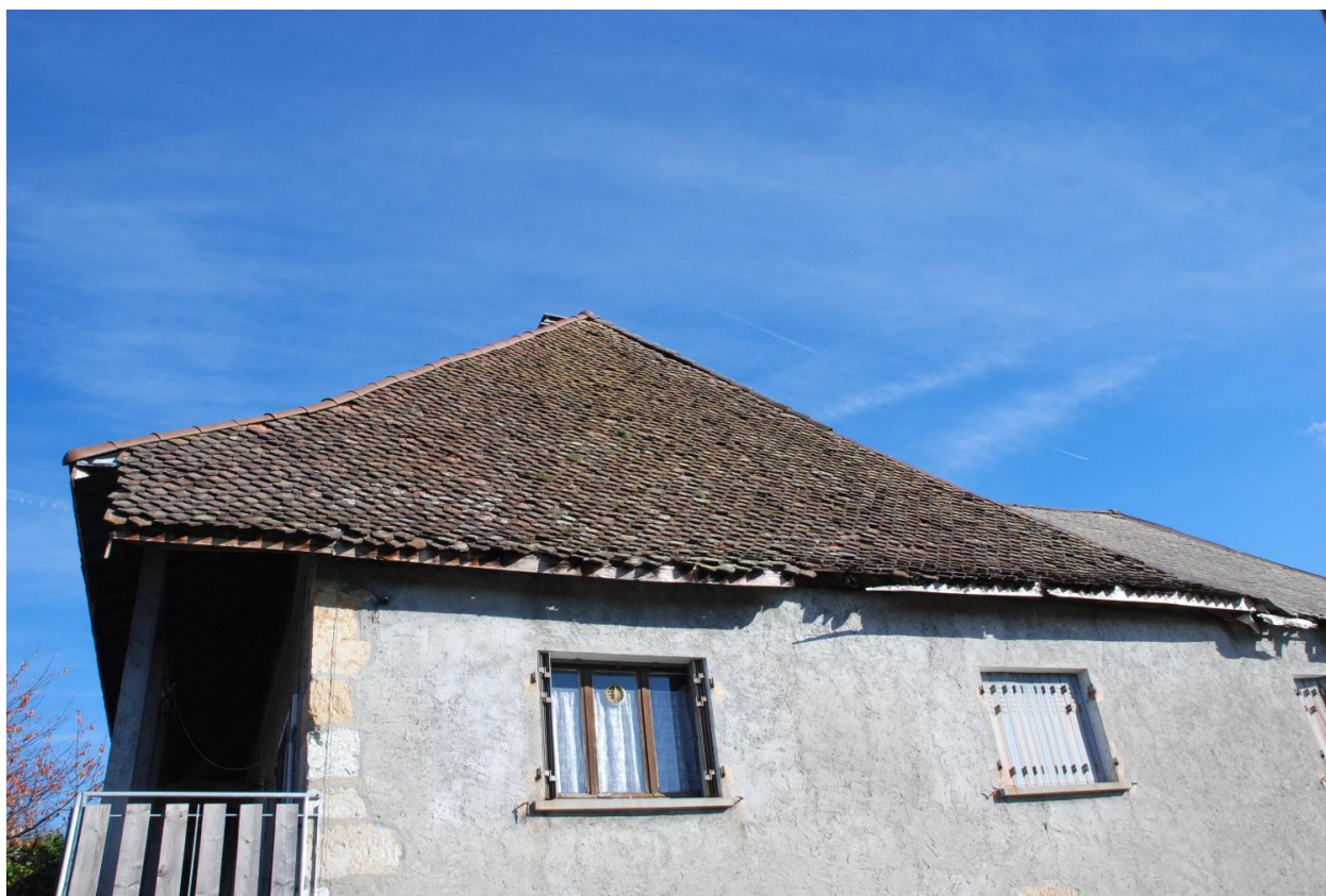
Vue du toit sur l'élévation sud-ouest.
