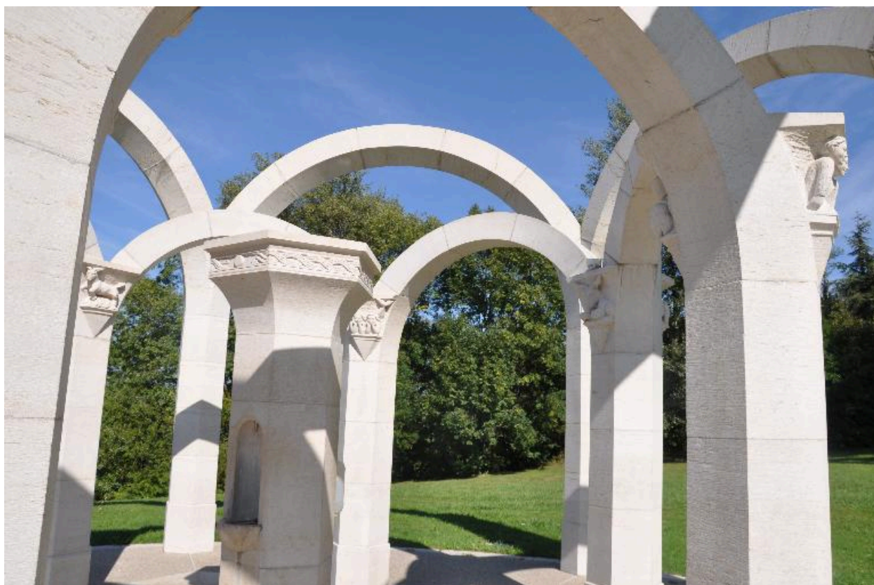
Pilastre renfermant la buvette dans une niche
