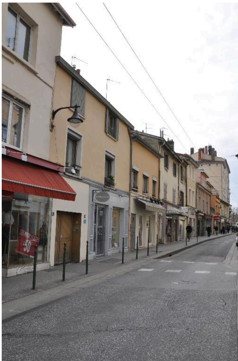
Vue d'ensemble nord ouest de l'immeuble de deux étages
