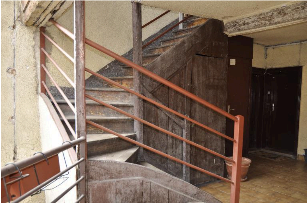
Vue de l'escalier depuis le palier du premier étage
