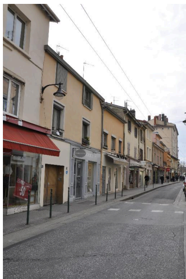
Vue d'ensemble nord ouest de l'immeuble de deux étages Phot. Nadine Halitim-Dubois IVR82_20146900313NUCA
