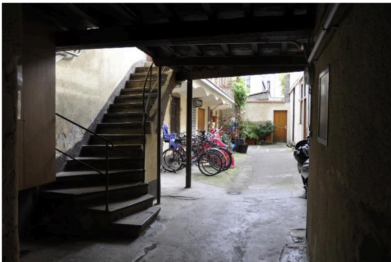
Vue de l'escalier
