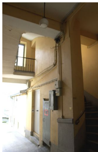
Détail de la 1ère volée d'escalier décalée. Phot. Maryannick Chalabi IVR82_20016900250NUCA
