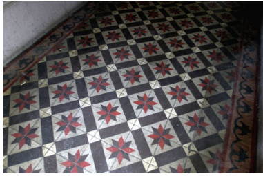
Pavement du vestibule en carreaux de ciment. Phot. Maryannick Chalabi IVR82_20016900253NUCA
