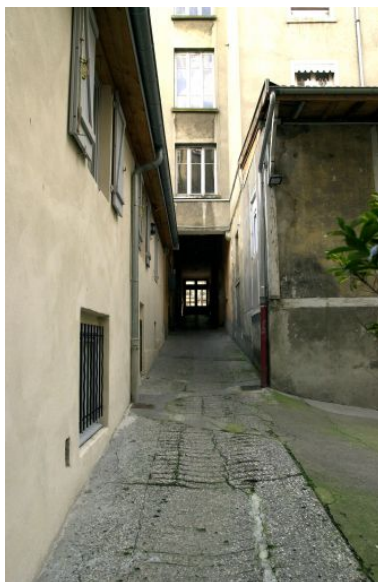
Vue du passage cocher depuis la cour Phot. Maryannick Chalabi IVR82_20016900249NUCA
