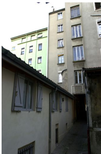
Elévations postérieures et tour d'escalier et vue du corps de bâtiment à droite de la cour Phot. Maryannick Chalabi IVR82_20016900252NUCA
