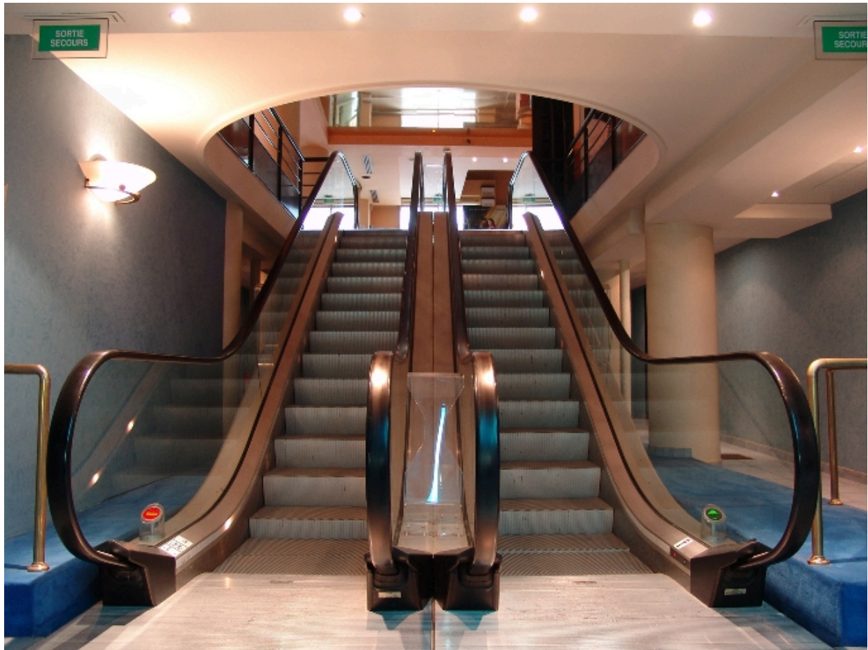
Escalier mécanique d'accès au casino
