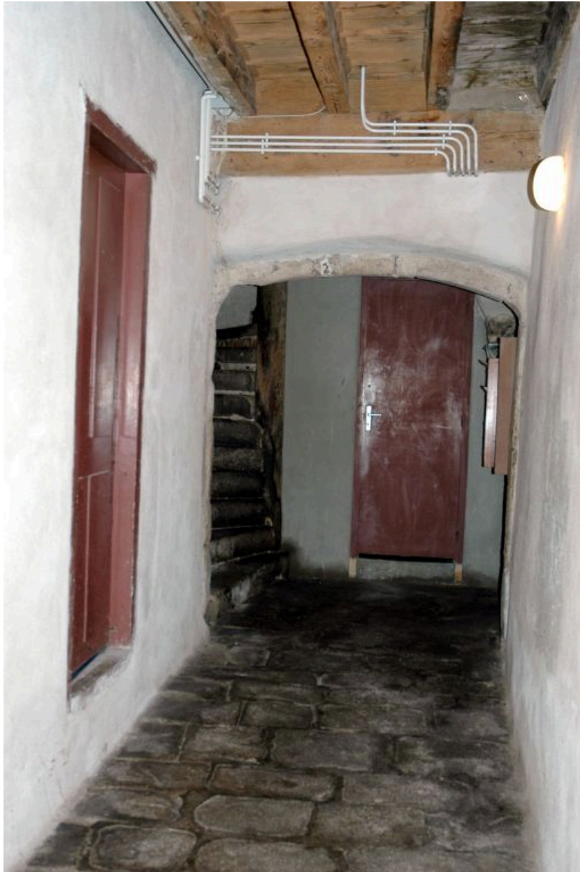
Vestibule d'entrée plafonné et sol dallé.
