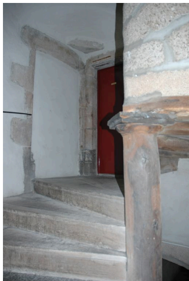
Escalier en vis composé d'un noyau central avec départ en bois puis de marches portant noyau. Phot. Simone Hartmann-Nussbaum IVR82_20124201318NUCA
