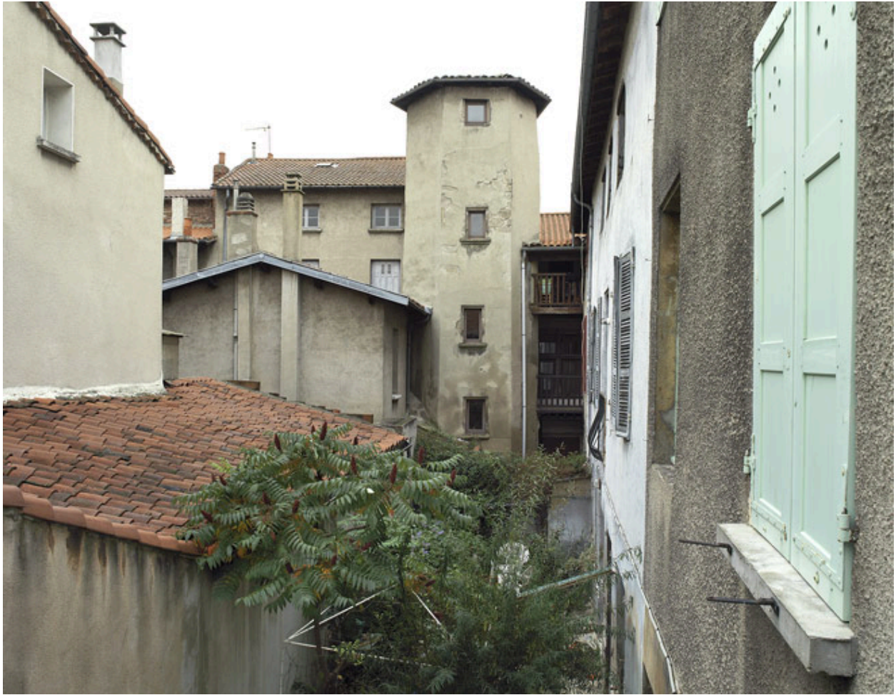
Vue générale sur cour.
