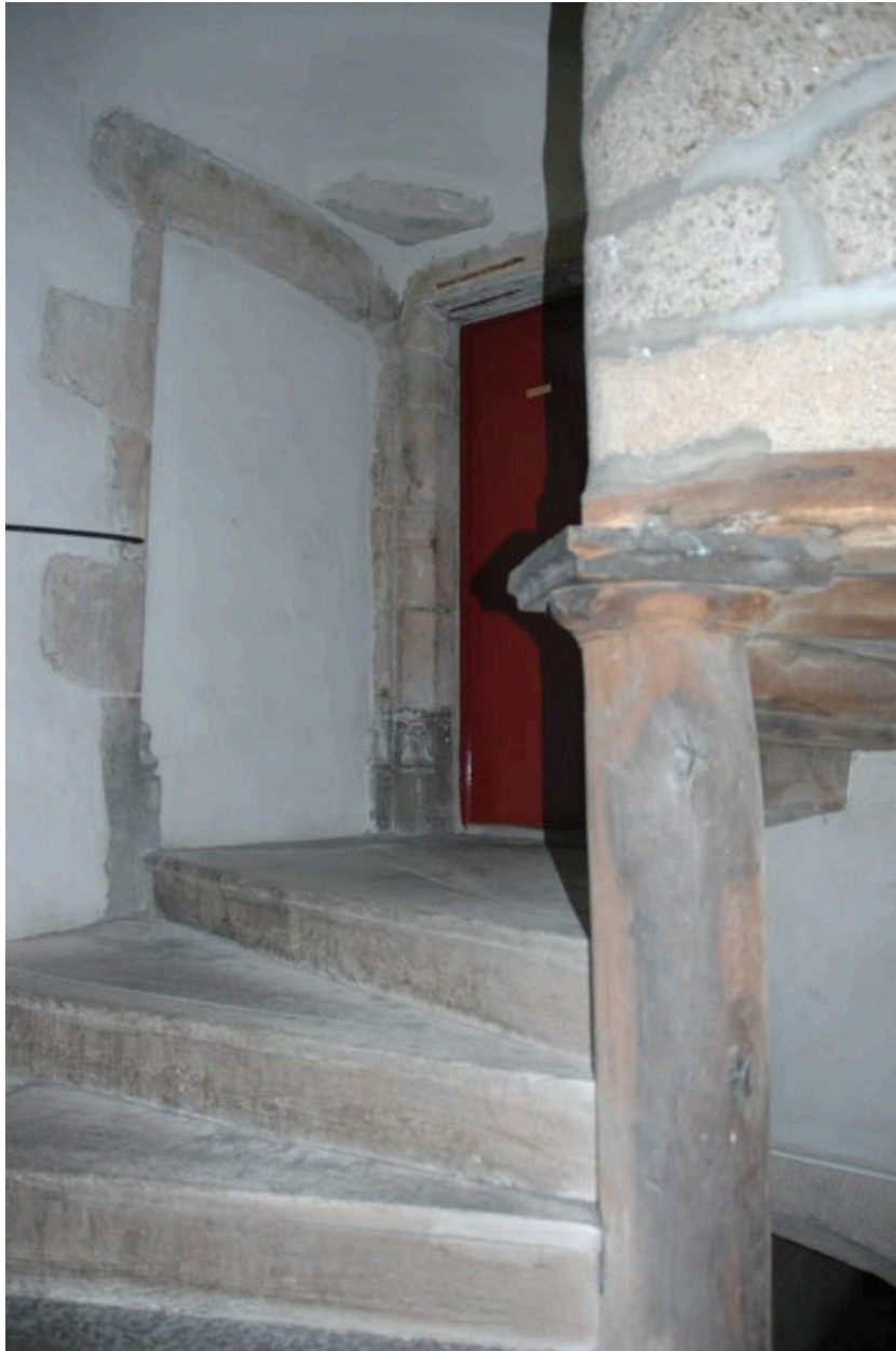
Escalier en vis composé d'un noyau central avec départ en bois puis de marches portant noyau.
