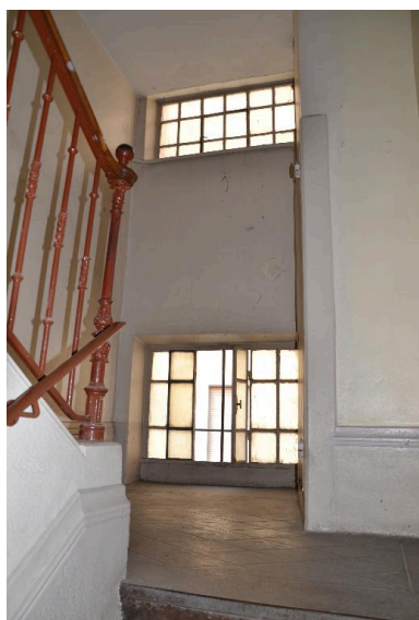
Baie escalier Phot. Noémie Caillat IVR82_20156900661NUCA
